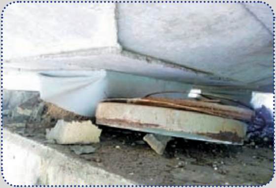
圖42 RP7支承破壞
