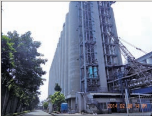
圖12 筒狀飼料倉及儲存輸送設備(二)
