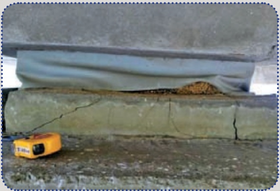
圖45 RP7砂漿墊破裂
