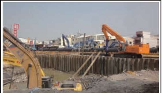
維冠大樓拆除後附近幹管新設搶修
