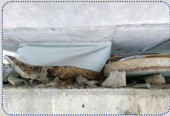
圖48 RP6支承破壞
