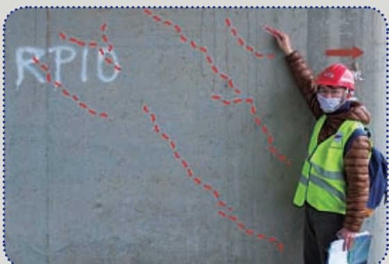
圖59 RP10柱身剪力裂縫
