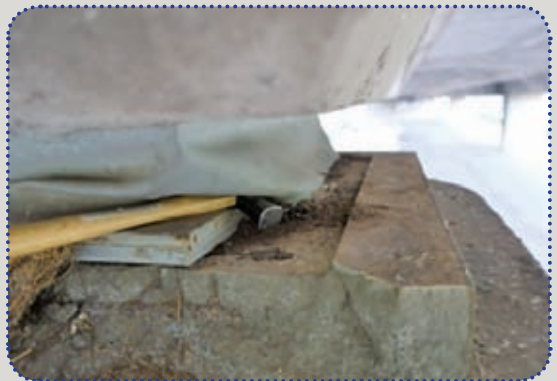
圖55 RP5支承破壞
