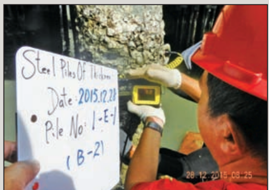
圖19 碼頭鋼樁之樁體腐蝕位置厚度量測作業(一)
