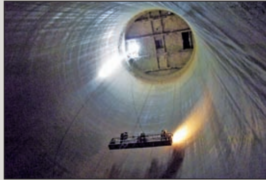
圖13 筒倉清空後進行鋼筋混凝土內壁目視檢測作業
