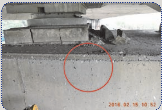
圖58 LP8柱頂裂縫
