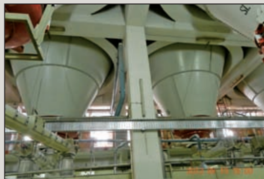
圖10 麵粉倉為鋼筋混凝土構造及倉內運送設備
