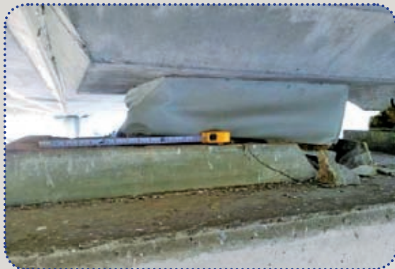
圖53 RP5砂漿墊破裂
