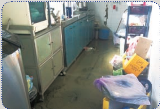
圖18 廚房及廁所噴砂，可見砂錐口
