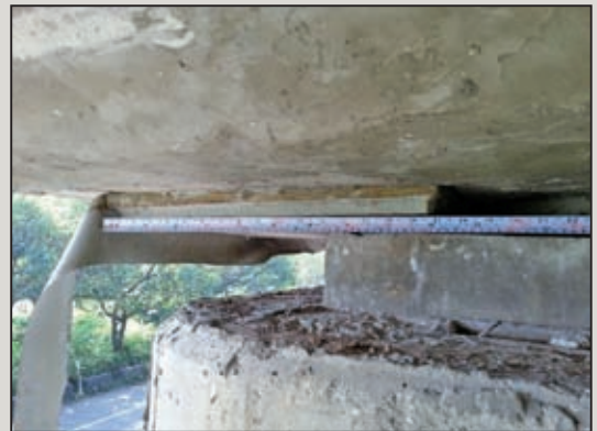
圖41 RP7墩柱活動支承錯移
