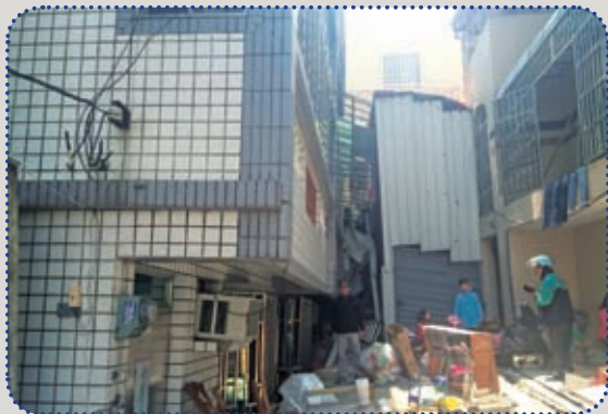
圖23 建物結構無損，但已傾斜下陷
