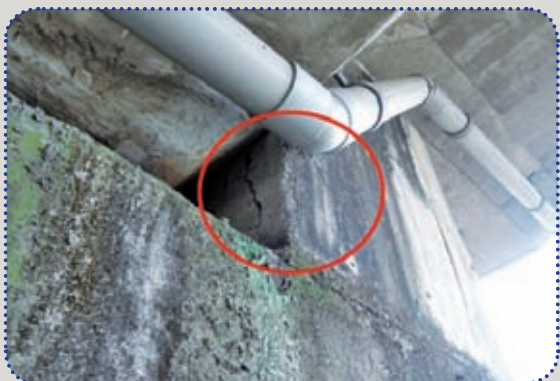
圖60 LA2止震塊損傷
