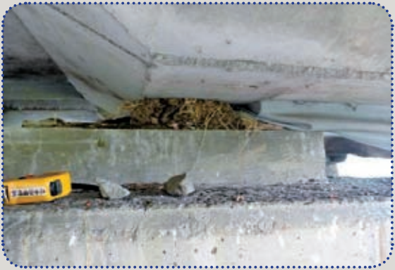
圖43 RP7支承破壞
