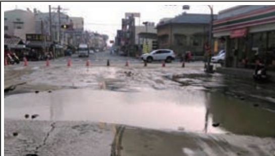
新化區台20線自來水幹管爆管
