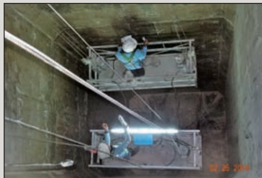
圖14 方形麥倉清空後進行鋼筋混凝土內壁目視檢測作業
