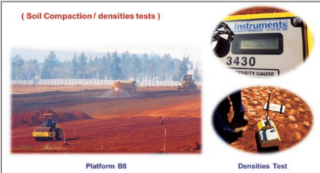
圖12 施工中照片集錦(二)
