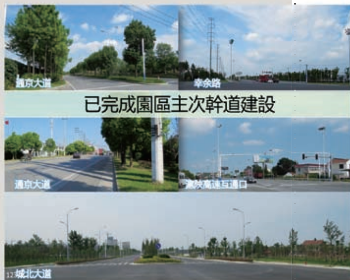
圖28 已完成道路現況
