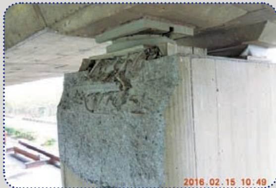
圖57 LP8混凝土剝落鋼筋外露
