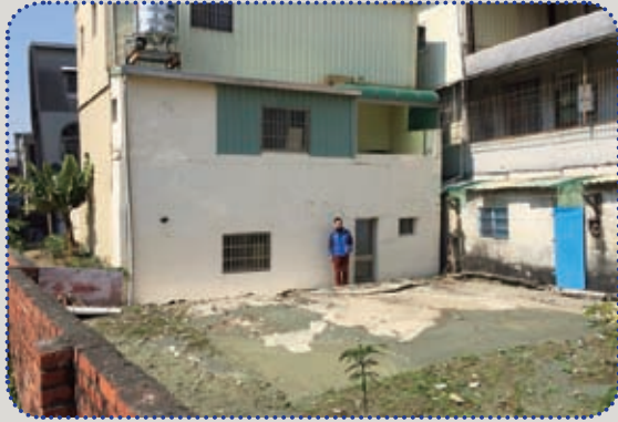
圖16 門前噴砂，建物傾斜下陷
