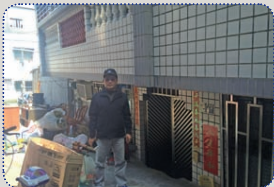
圖24 建物1F沉入地面約1~2m
