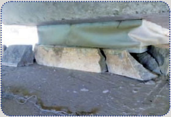
圖44 RP7砂漿墊破裂
