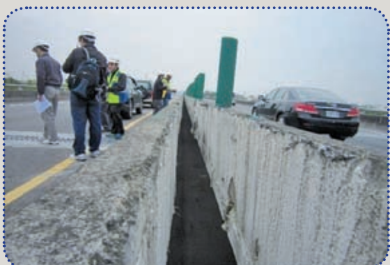
圖61 內側護欄上防眩板脫落
