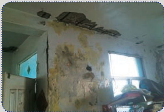
圖19 室內混凝土剝落
