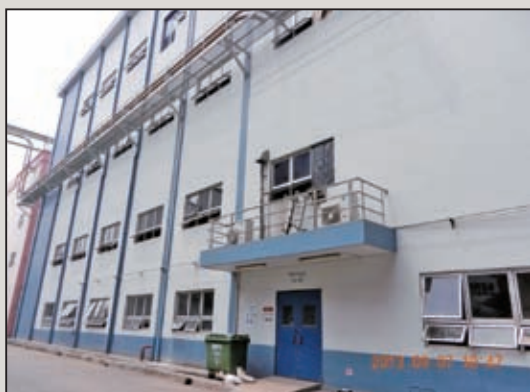
圖7 小麥研磨廠為鋼筋混凝土廠房結構
