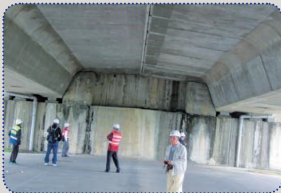
圖62 內側護欄混凝土剝落
