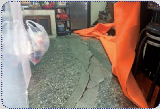
圖17 屋內地板隆起約40m破裂
