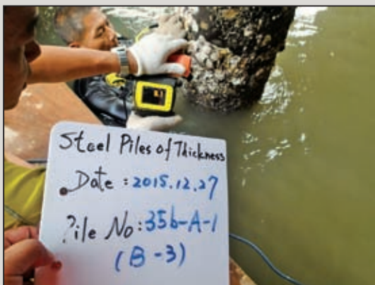
圖20 碼頭鋼樁之樁體腐蝕位置厚度量測作業(二)
