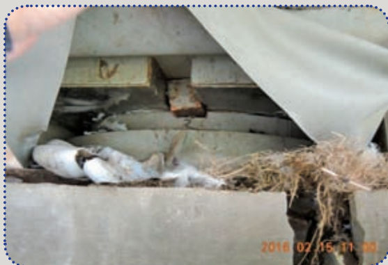
圖51 LP7支承破壞
