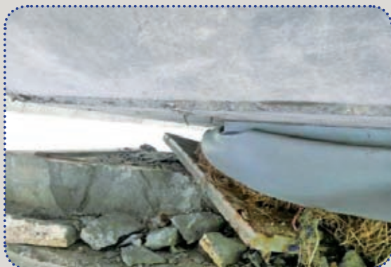
圖50 RP6支承破壞
