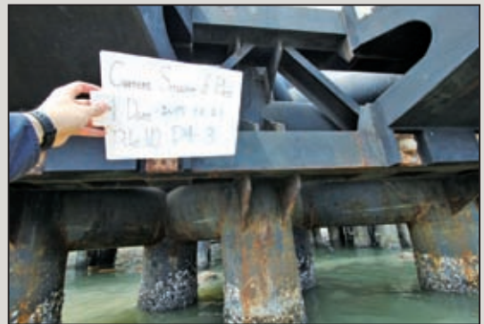
圖18 碼頭鋼樁水上目視檢測及腐蝕現況拍攝作業
