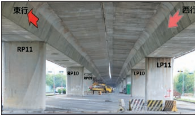
圖39 震後雙向橋體分離現況
