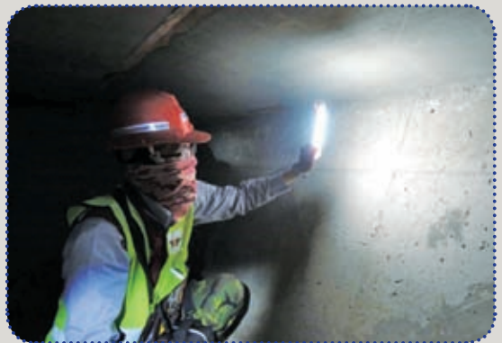
圖71 箱梁內部檢查
