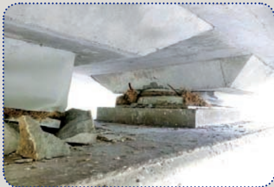
圖52 RP5砂漿墊破裂
