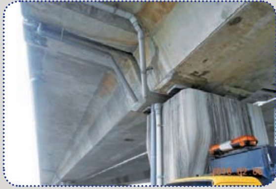
圖47 RP7支承位移及洩水管脫落
