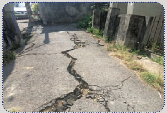
圖10 柏油路面裂縫，寬度達13cm
