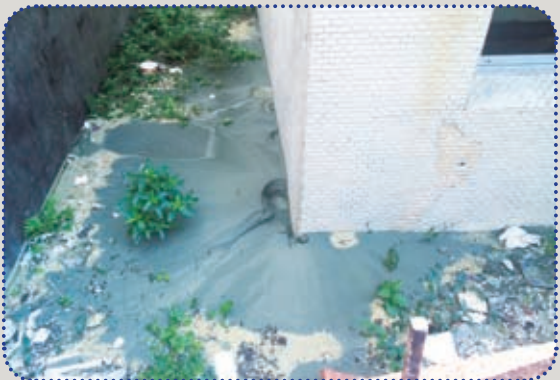
圖14 建物角隅噴砂
