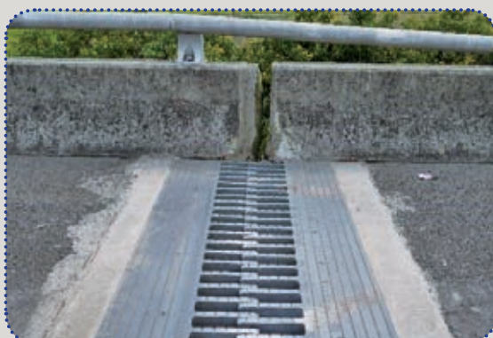
圖65 外側護欄分離約10cm
