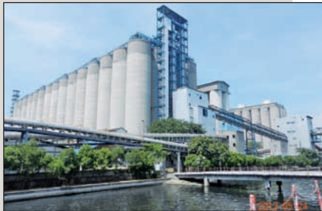
圖5 筒狀小麥倉及儲存輸送設備
