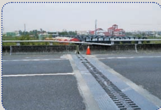
圖63 金屬欄杆掉落
