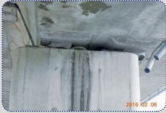
圖46 RP7支承位移及洩水管脫落
