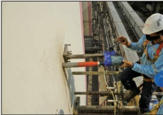
圖15 局部破壞性檢測-混凝土鑽心試驗作業
