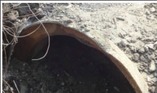
維冠大樓附近自來水幹管接頭變形破壞
