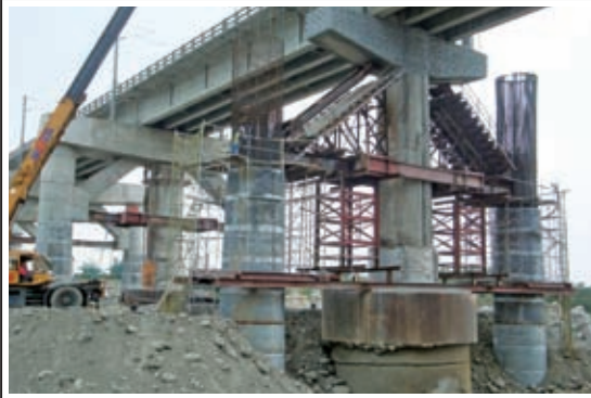
照片3：架設鋼斜撐桿件及水平臨時桿件
