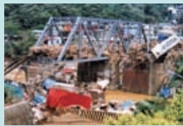
基隆河鐵路橋-斷橋 2001年納莉颱風
