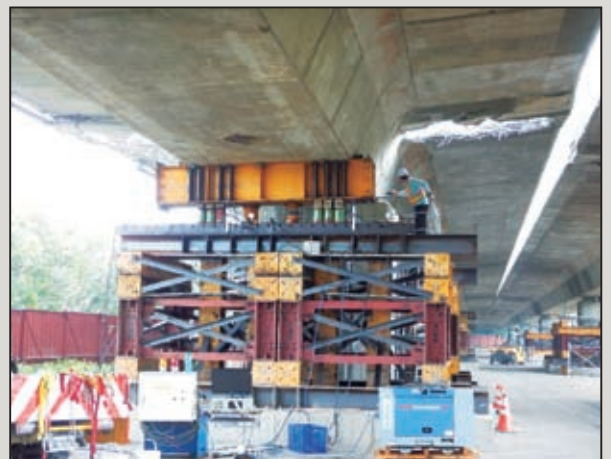
圖14 現場設置之重型支撐架系統
