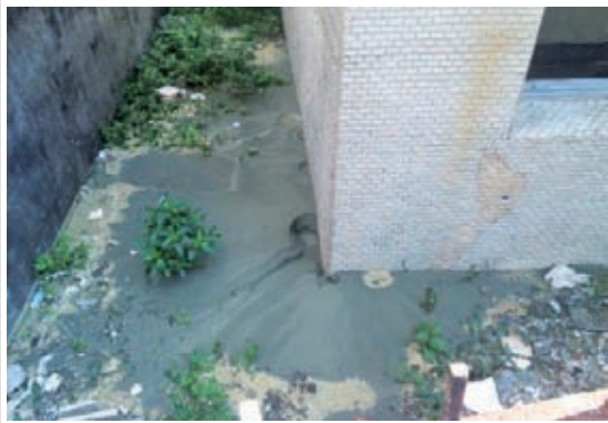
(1)地表冒水噴砂(臺南惠安街，2016年美濃地震)
