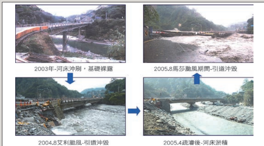
圖22 篤銘橋水害及土石流災害
