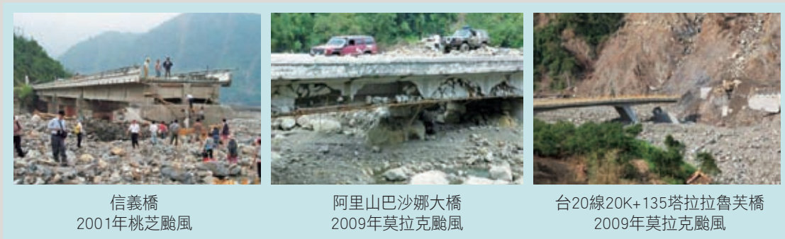
圖10 颱風豪雨造成橋梁土石流災害
