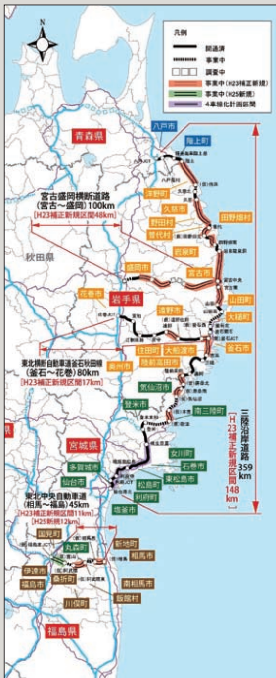
圖20 復興道路與復興支援道路 (資料來源：日本國土交通省東北地方整備局網站)
