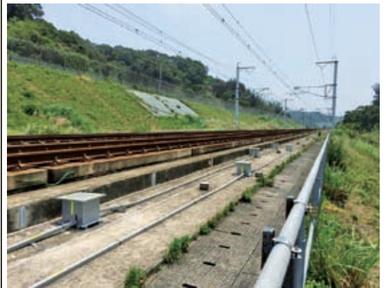
(a) 路堤高程沉陷監測系統
