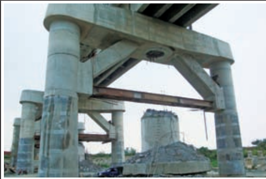
照片5：舊有墩柱分離，載重移轉至新橋柱
