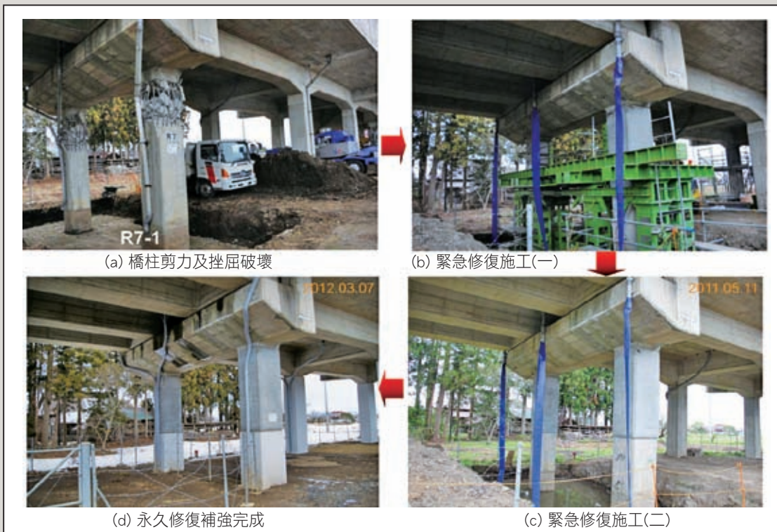
圖7 東北新幹線第1中曾根高架橋震害、緊急補強及永久補強情形(二)
