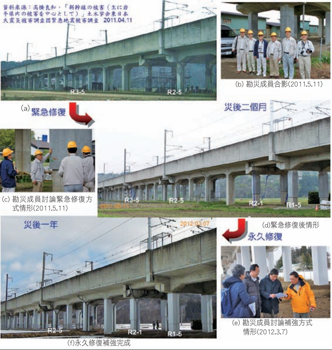
圖8 東北新幹線第1中曾根高架橋震害、緊急補強及永久補強情形(三)
