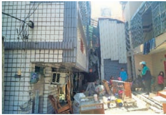
(3)結構體下陷破壞(臺南惠安街，2016年美濃地震)
