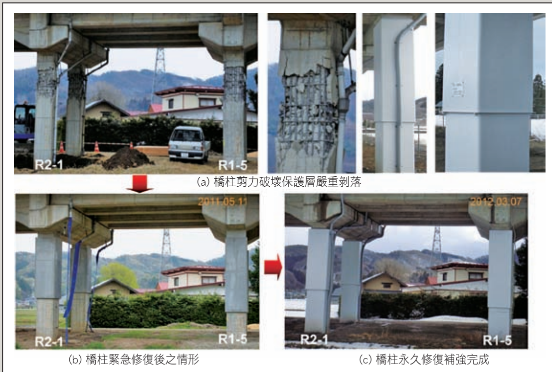
圖6 東北新幹線第1中曾根高架橋震害、緊急補強及永久補強情形(一)
