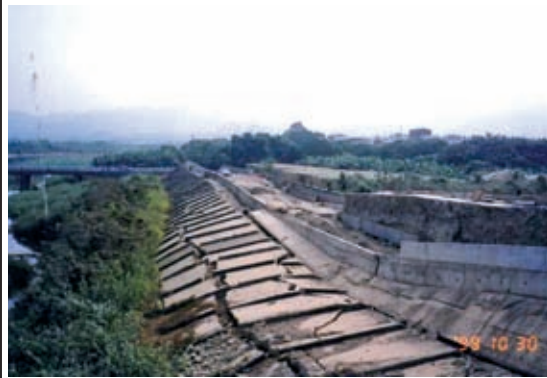
(6)土堤破壞(南投小溪橋，1999年集集地震)
