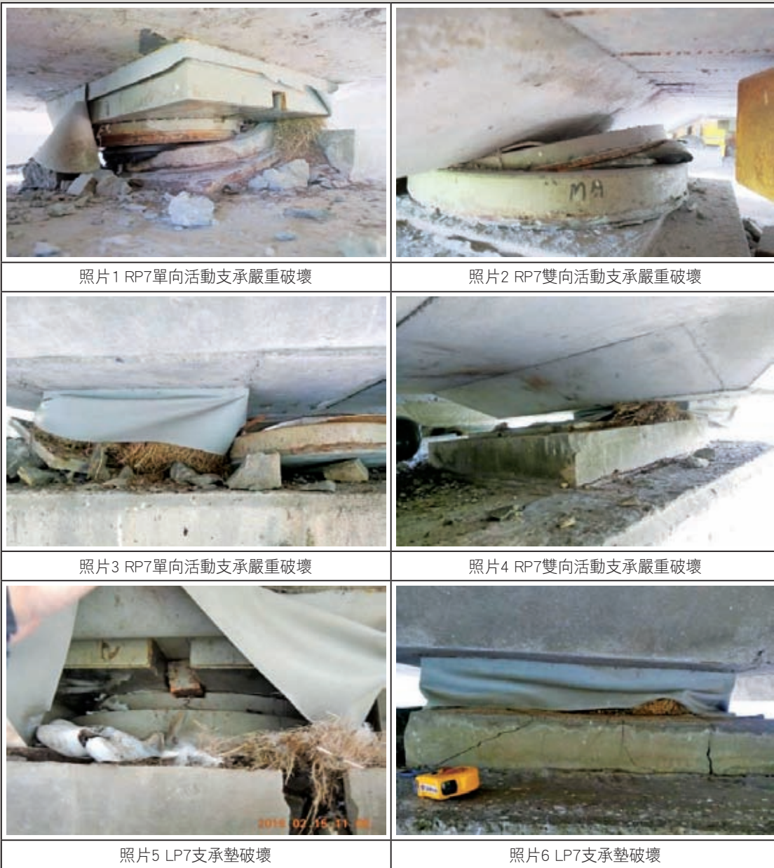
圖9 橋梁損傷照片
