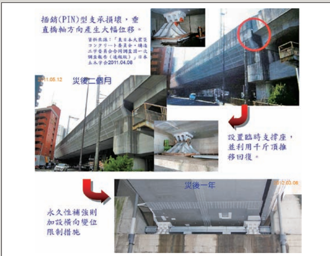
圖10 東北新幹線花京院橋震害
