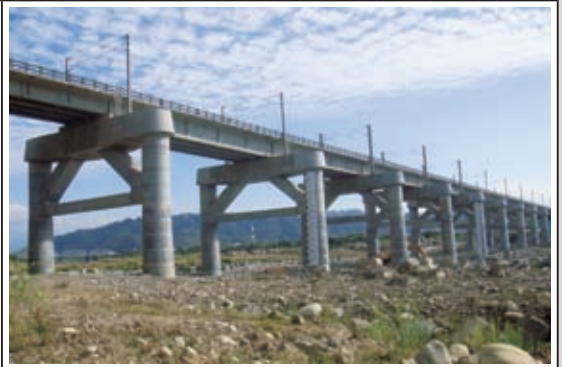
照片6：橋梁換底完成
