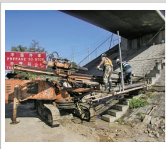
圖7 橋台液化補強採地盤改良施作
