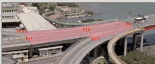
圖4 關渡橋引橋P9~P11現況
