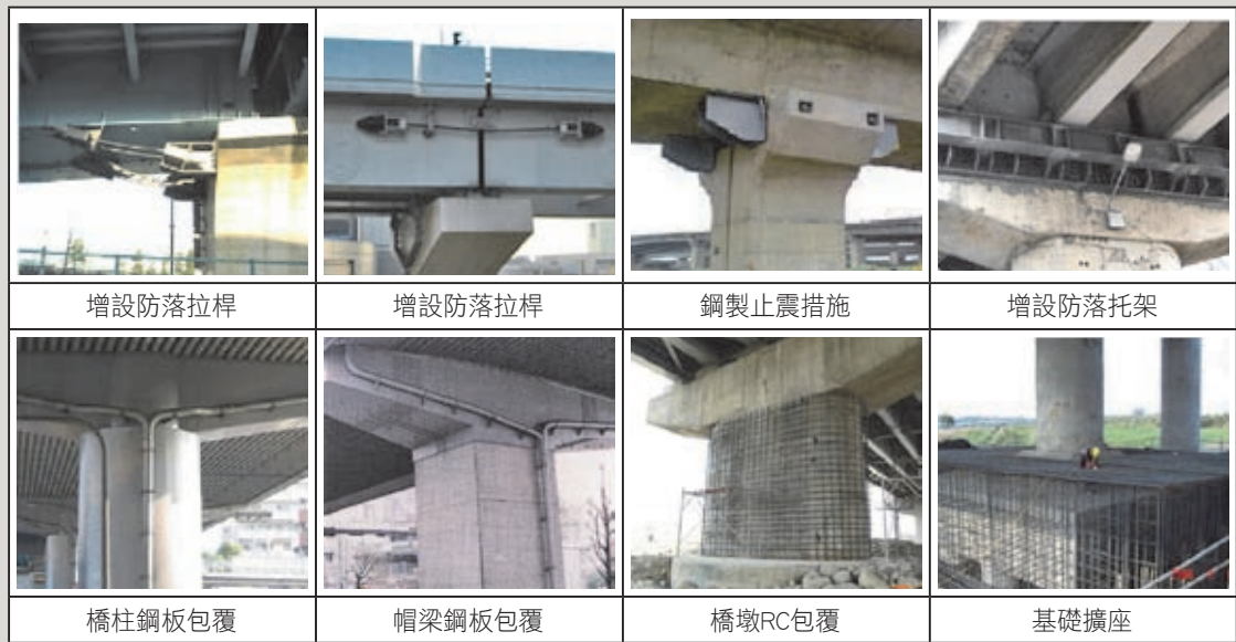
圖1 傳統橋梁耐震補強方式
