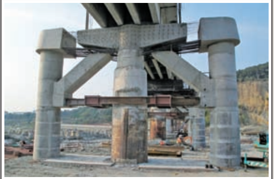
照片4：施作新帽梁，混凝土包覆鋼斜撐桿件
