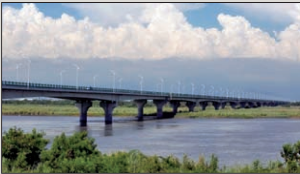
圖17 雙園大橋完工照片
