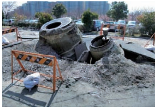
(5)人孔結構體上浮破壞(浦安市，2011年東日本地震)
