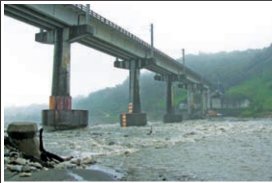
照片1：原橋沉箱基礎裸露
