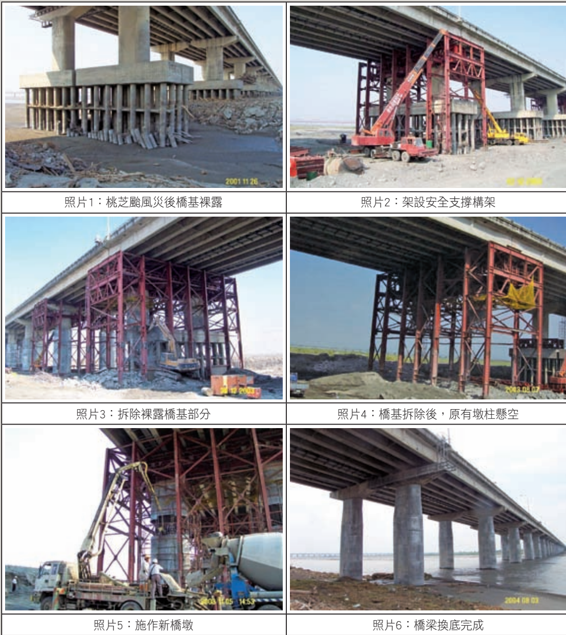
圖10 溪州大橋換底工法照片
