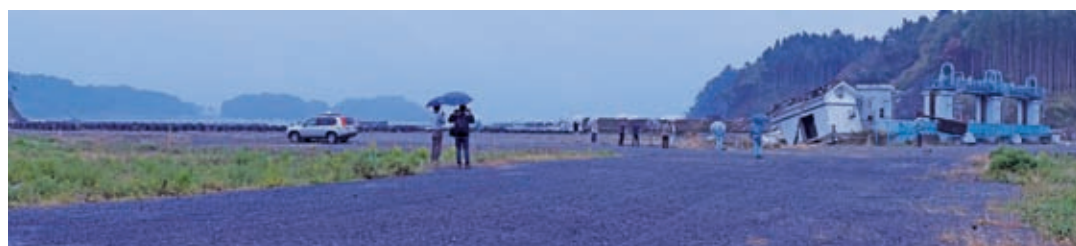
(d) 橋址橋墩拆除後整地情形(2014.10.21)
