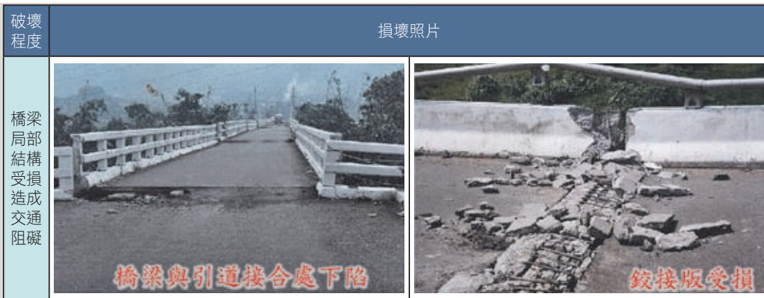
圖1 橋梁於大地震中遭受不同程度損壞照片
