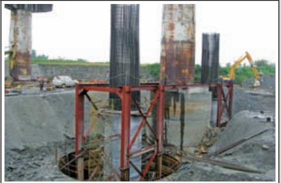
照片2：施築新基礎及底柱
