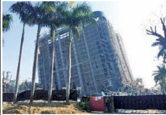
(4)結構體傾斜破壞(臺南旺林飯店，2016年美濃地震)
