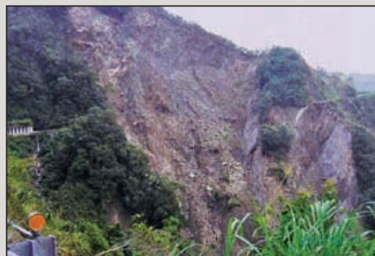
圖25 台18線71.1k邊坡災害(2009年莫拉克颱風)
