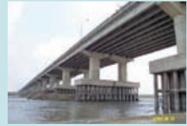
溪州大橋-基礎裸露 2001年桃芝颱風
