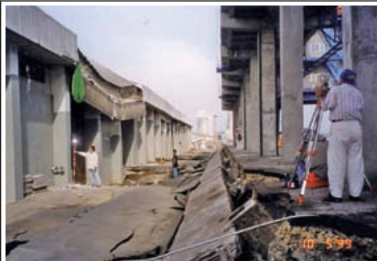
(8)側向流動導致之破壞(臺中港，1999年集集地震)
