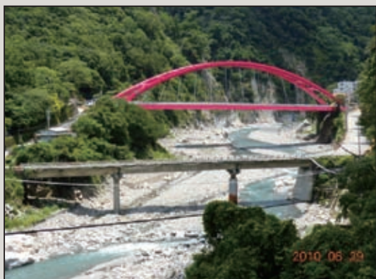
圖24 台8線篤銘橋完工照片
