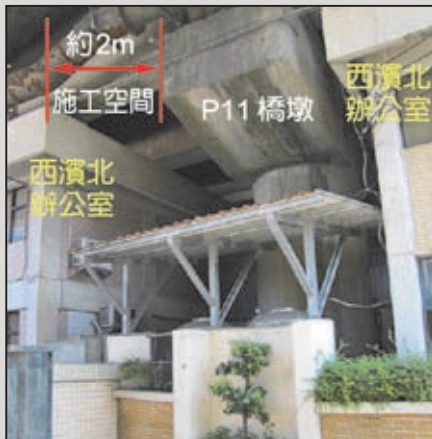
圖6 關渡橋P11現況
