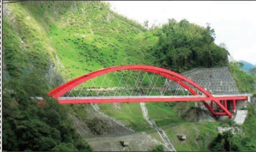
圖28 台18線71.1k橋梁完工照片
