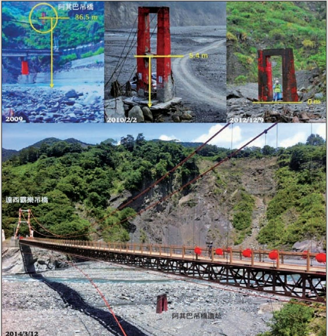
圖1 新建達西霸樂吊橋及歷年河床變化圖[4]
