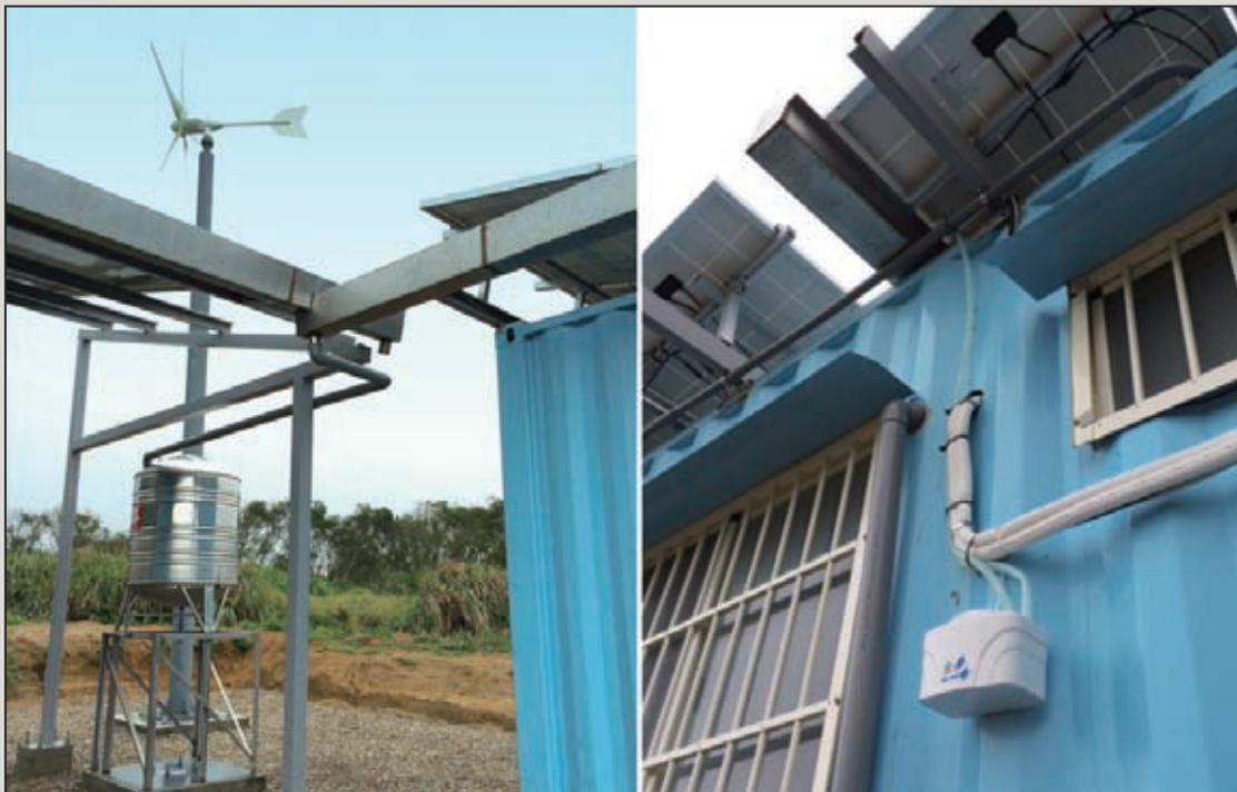
圖13 集水天溝與蓄水塔(左)及冷氣排水回收(右)設施
