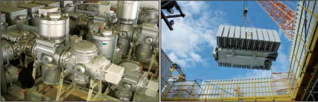
圖7 GIS配置與變壓器吊裝圖
