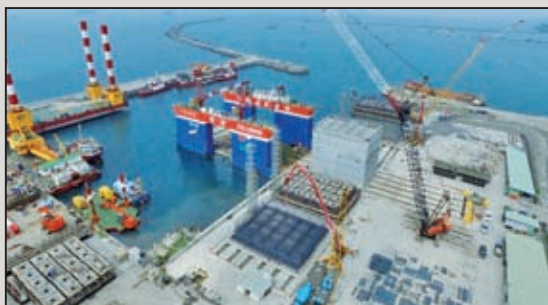
圖15 岸線工程陸上軌道台車運移工法實景
