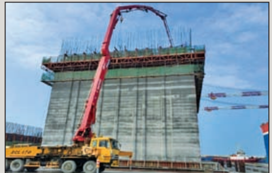
圖16 自動化滑模系統工法施工實景
