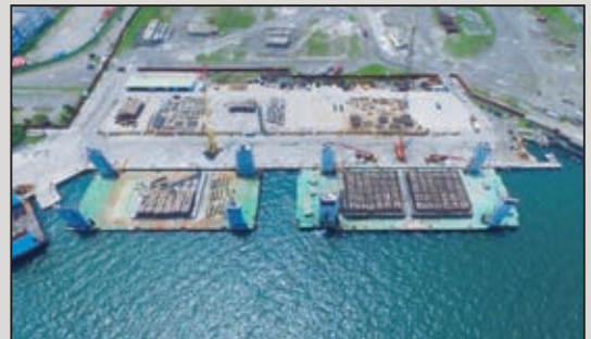
圖14 外廓堤工程浮沉台船工法實景
