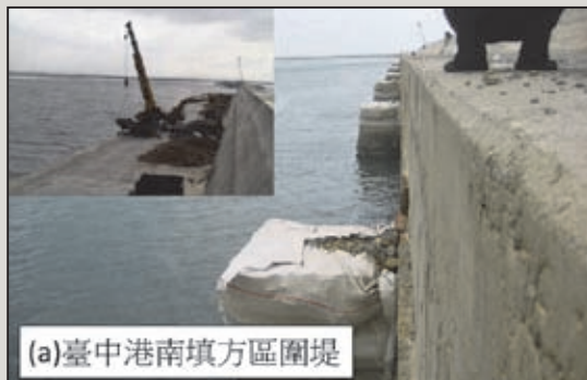
圖10 沉箱堤失效之防漏設計
