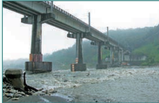
照片2a：鐵路大甲溪橋原橋沉箱基礎裸露
