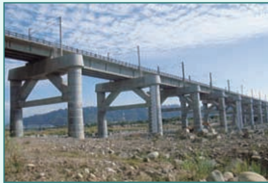
照片2b：鐵路大甲溪橋換底完成
