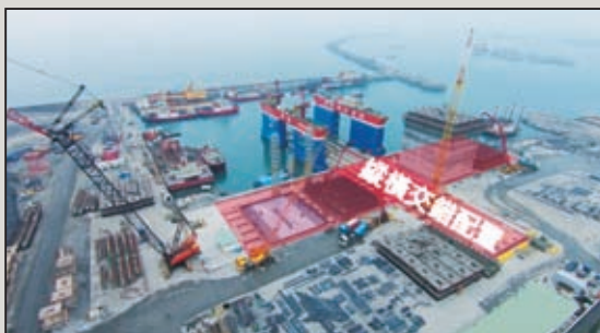
圖15 岸線工程陸上軌道台車運移工法實景
