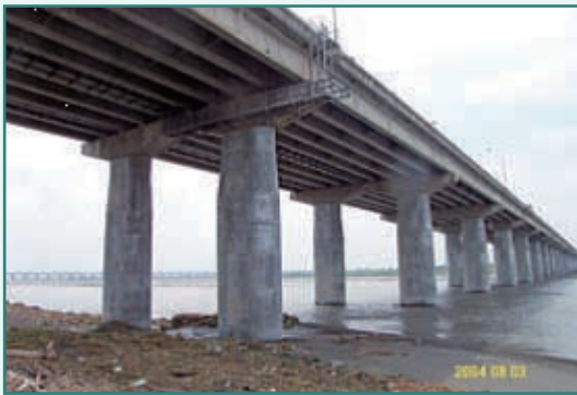
照片1b：溪州大橋換底完成
