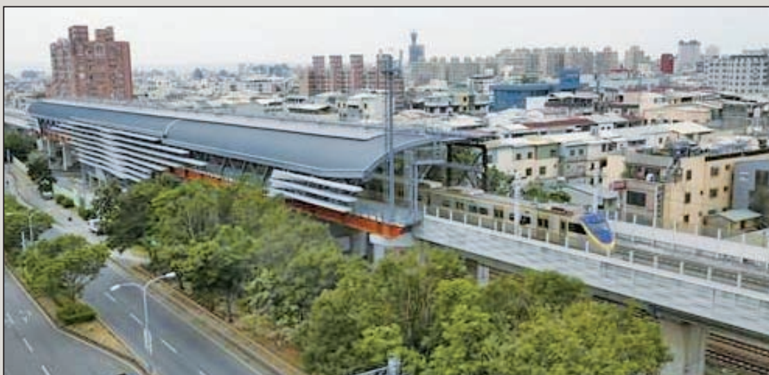
圖25 精武車站單側完成照片(供列車通行，車站暫不啟用，另側施工中)
