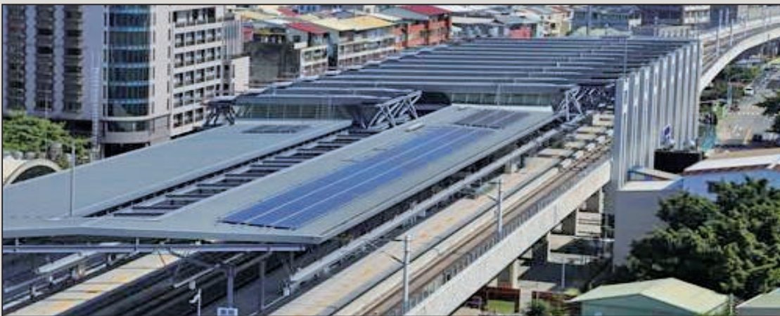
圖22 豐原車站第一階段通車後照片
