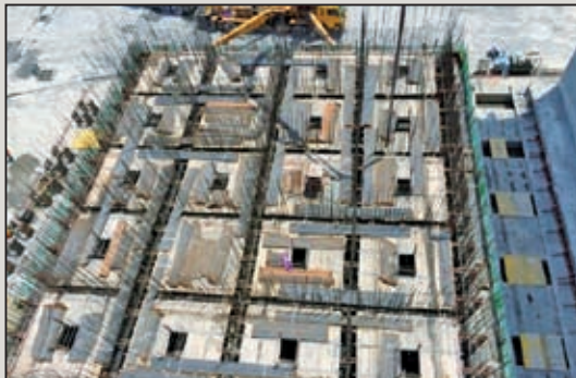
圖16 自動化滑模系統工法施工實景
