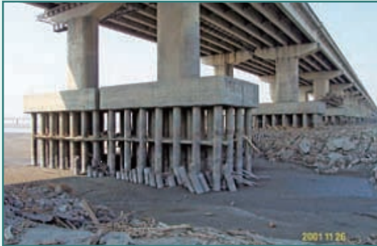
照片1a：溪州大橋於桃芝颱風災後橋基裸露
