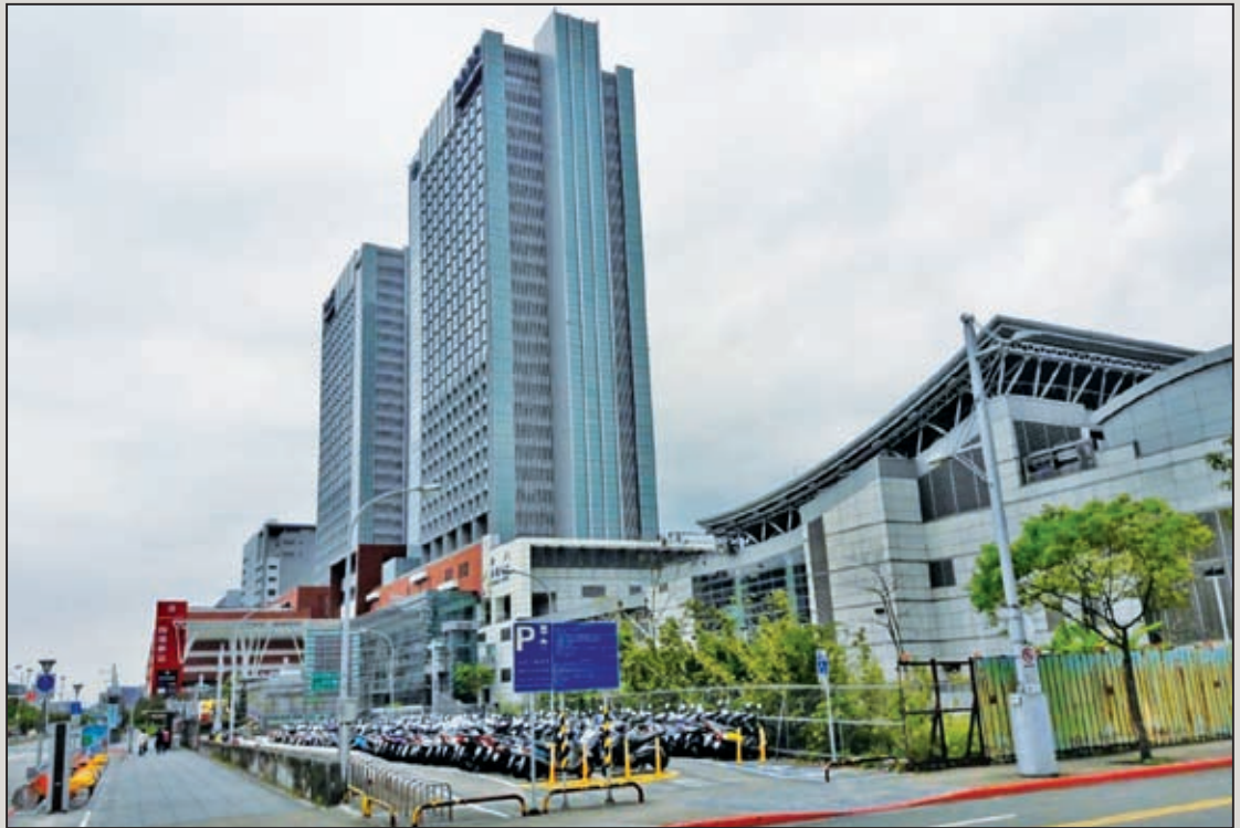
圖13 南港車站完工站片(自東南向西北方向拍)
