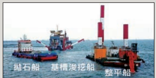
圖17 沉箱拖放機具、拖放數量及施工機具施工實景
