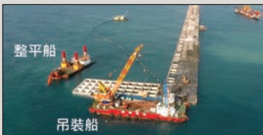
圖17 沉箱拖放機具、拖放數量及施工機具施工實景
