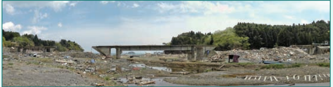
氣仙沼線鐵路橋
