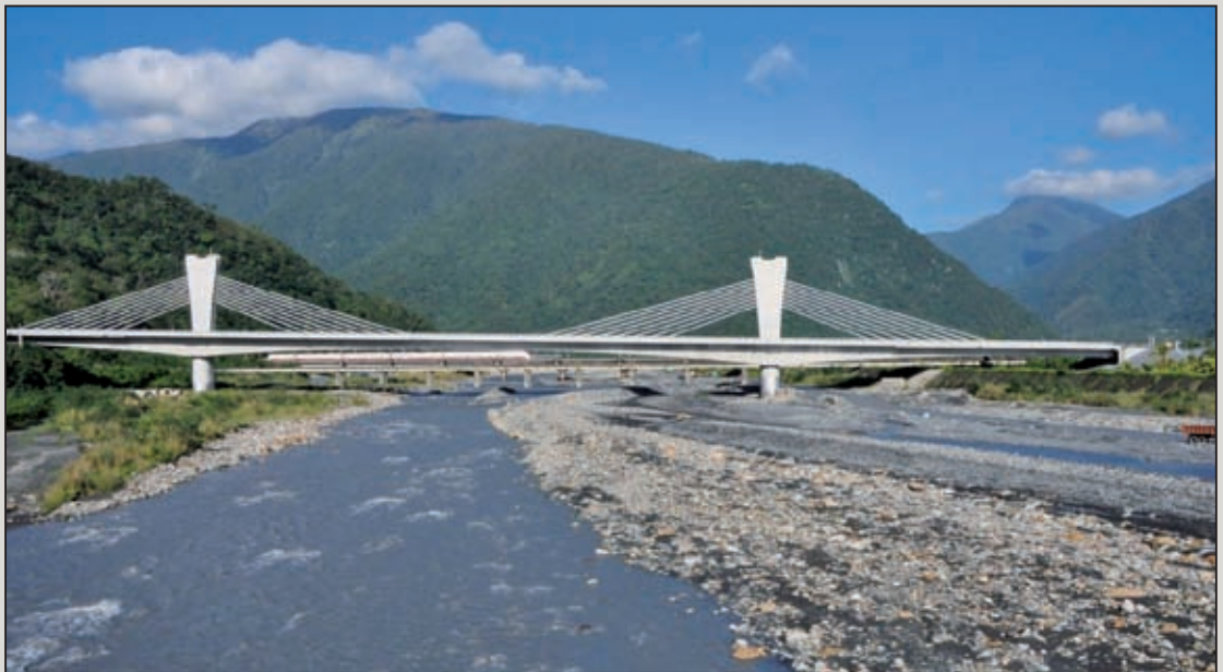
圖11 南澳北溪景觀橋施工現況
