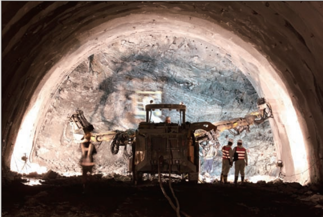
圖2 蘇花公路改善計畫-觀音隧道
