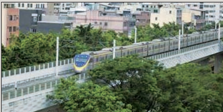
圖16 竹編式預鑄護欄及弧形曲線墩柱帽梁完成照片
