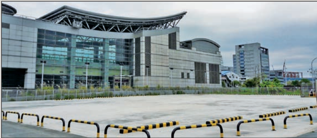
圖11 位於A1東側出入口旁之A2棟基地現況
