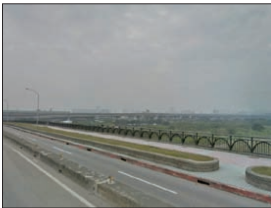
橋梁上植栽槽生長環境不良
