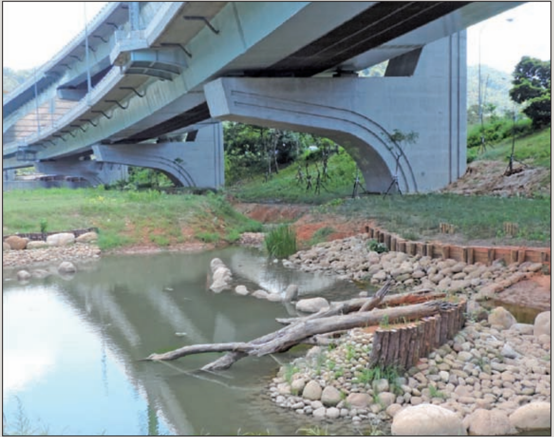
圖20 完工後由橋下生態池仰視雙層高架橋
