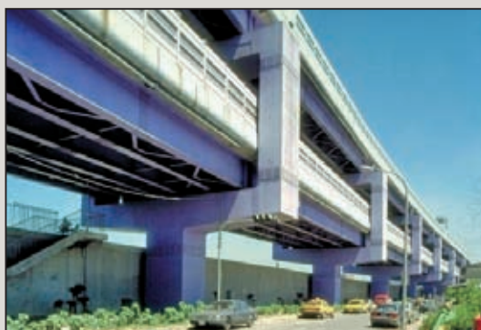
圖10 傳統框架式雙層橋
