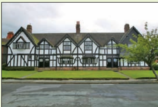
Port Sunlight員工住宅及前庭
