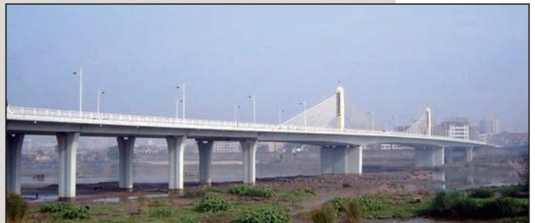
圖7 漳州戰備大橋 (參考自 http://bridge.tongji.edu.cn/qiaoliang/bridgeaided/album/subject/SUBJECT7/2.htm )
