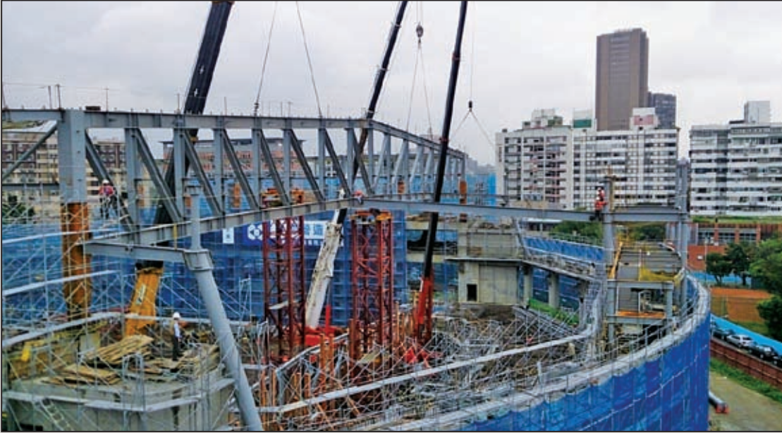
圖11 籃球館鋼構桁架吊裝過程
