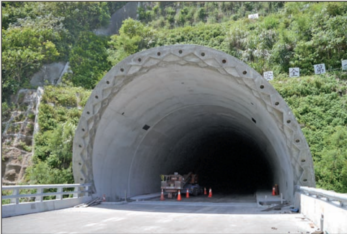
圖30 武塔隧道南洞口
