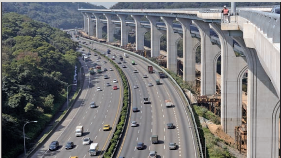
圖11 國道1號五股林口路段壯觀雙層橋段
