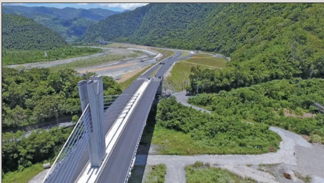
圖39 南澳南溪路堤工程現況
