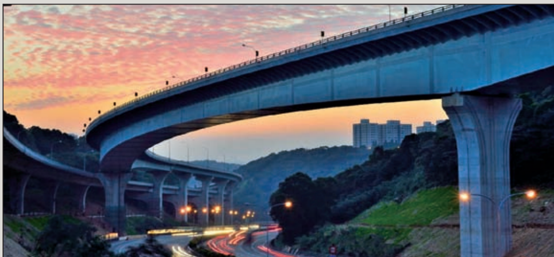
圖8 林口跨越橋照片二
