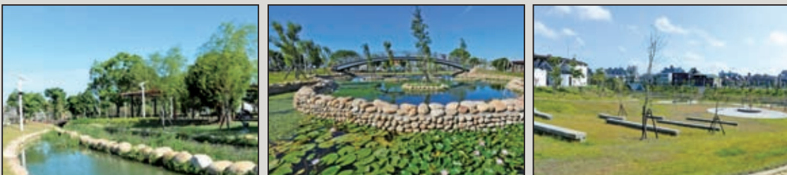
圖22 卵礫石利用於水圳護岸、環滯洪池步道及座椅基座
