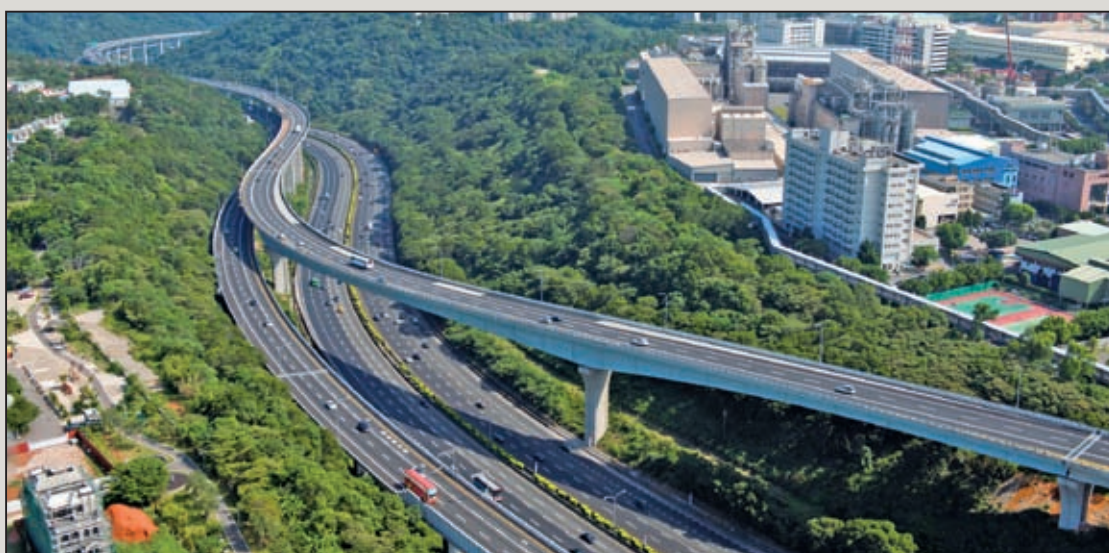
圖7 林口跨越橋照片一
