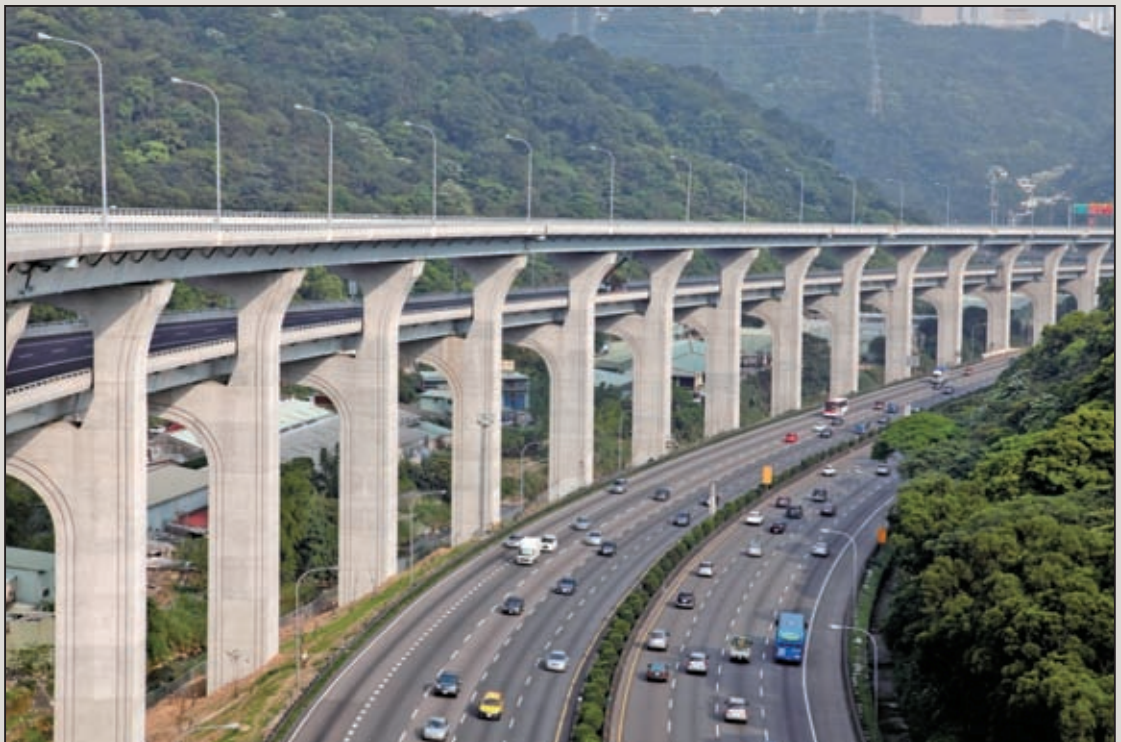
圖21 完工後雙層高架橋色彩融入環境的呈現
