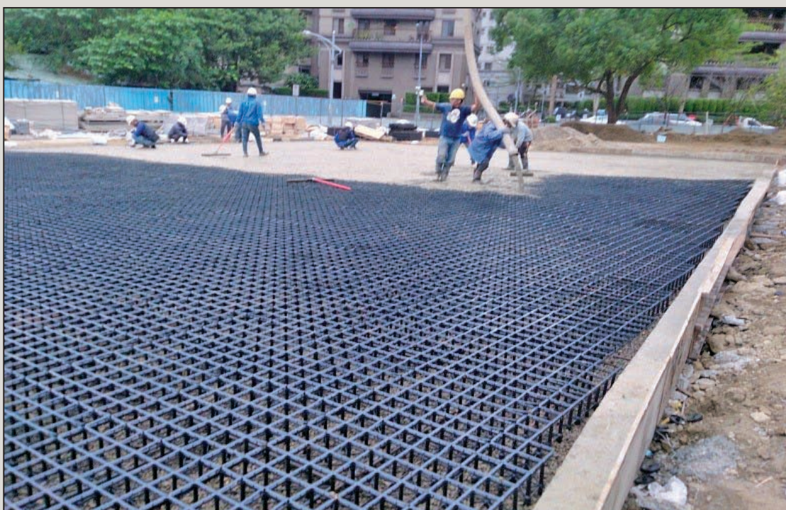
圖10 管式透水鋪面施工過程
