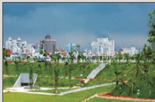
圖11 多功能滯洪池
