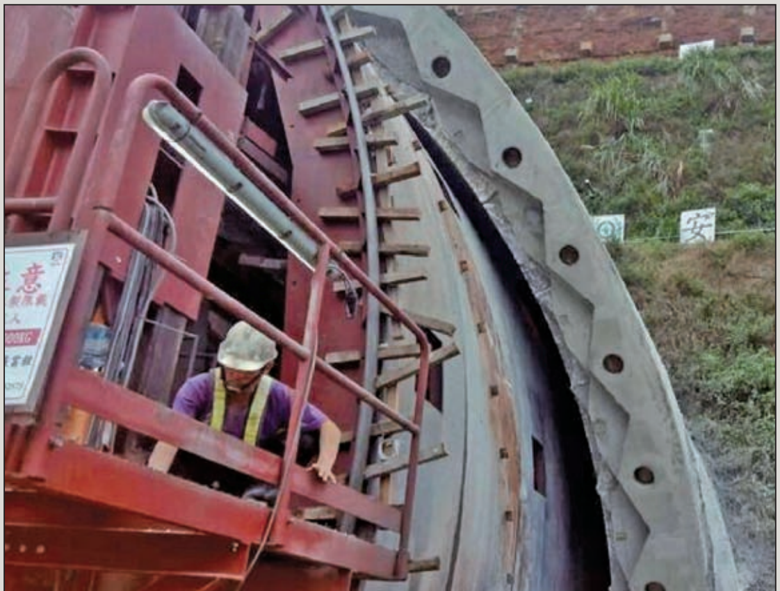
圖29 隧道洞口造型模板拆模(二)
