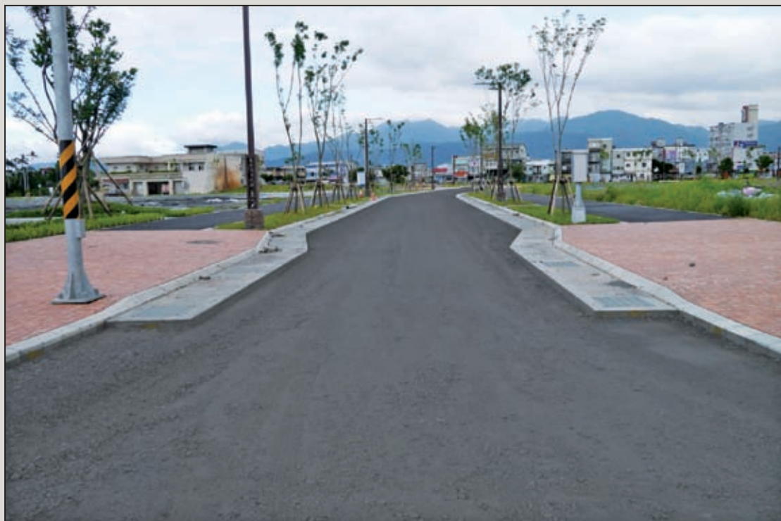
圖42 服務性道路施工現況圖
