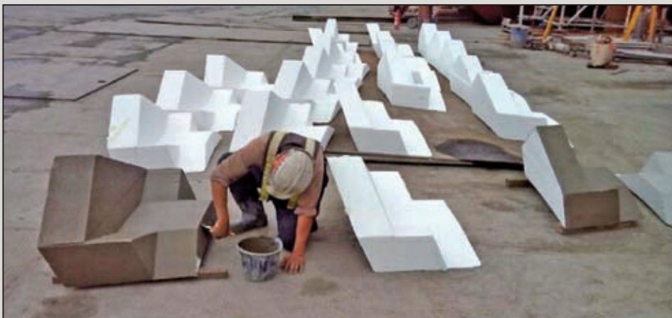
圖27 隧道洞口造型模板
