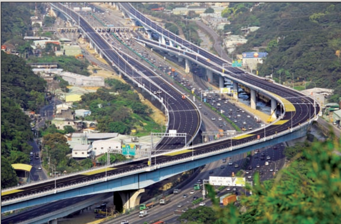
圖5 泰山跨越橋照片一
