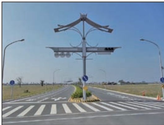
牌面、號誌及路燈共桿
