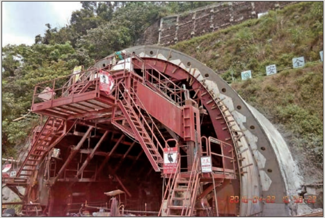
圖28 隧道洞口造型模板拆模(一)
