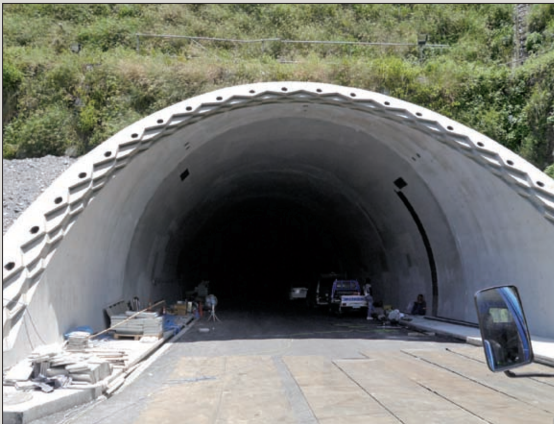
圖31 武塔隧道北洞口
