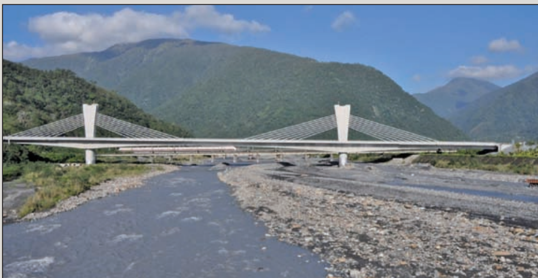
圖63 南澳北溪橋完工照片
