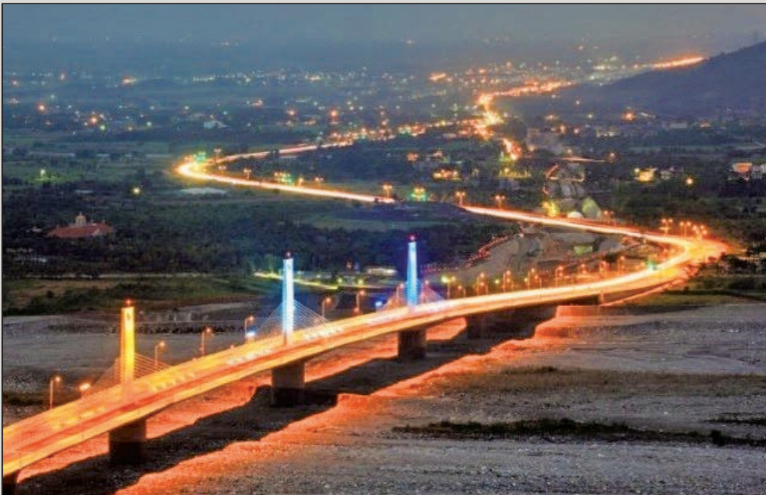
圖26 新豐平大橋完工照片
