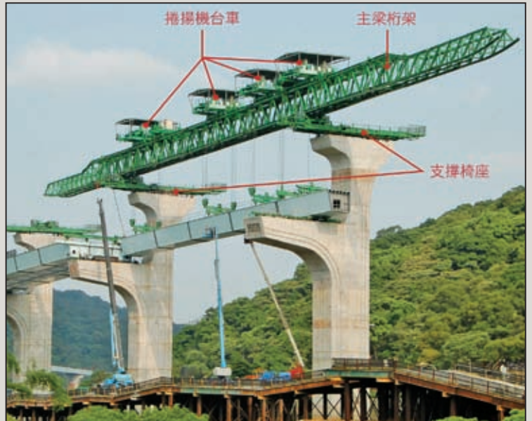
圖21 全跨徑架設梁吊裝工法
