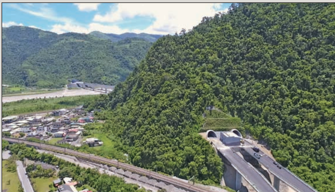
圖25 蘇花公路改善計畫武塔部落與武塔隧道鳥瞰
