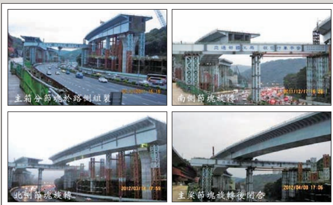
圖19 旋轉工法施工(可維持國道1號正常通行)
