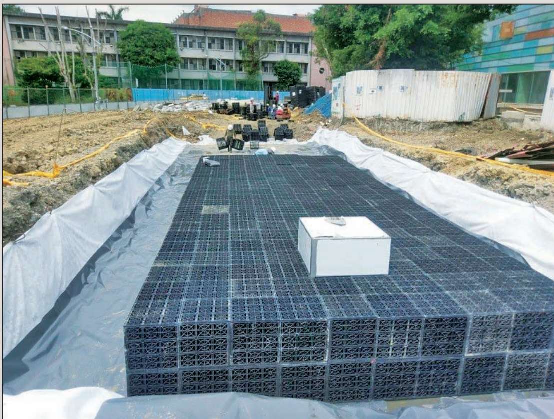
圖9 水撲滿施工過程
