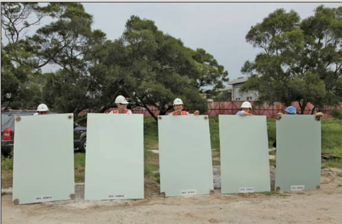
圖19 施工階段現場色彩比對
