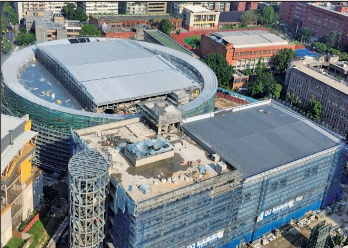
圖12 鈦鋅版屋頂施工過程
