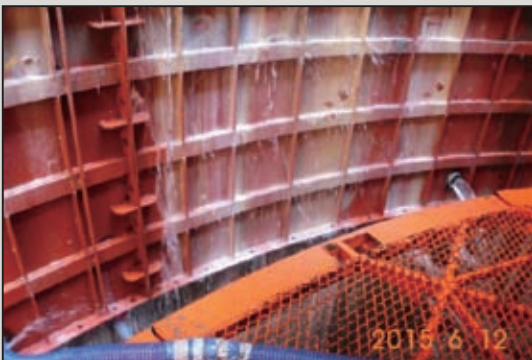
圖10 模板配合壁體增設排水管開孔
