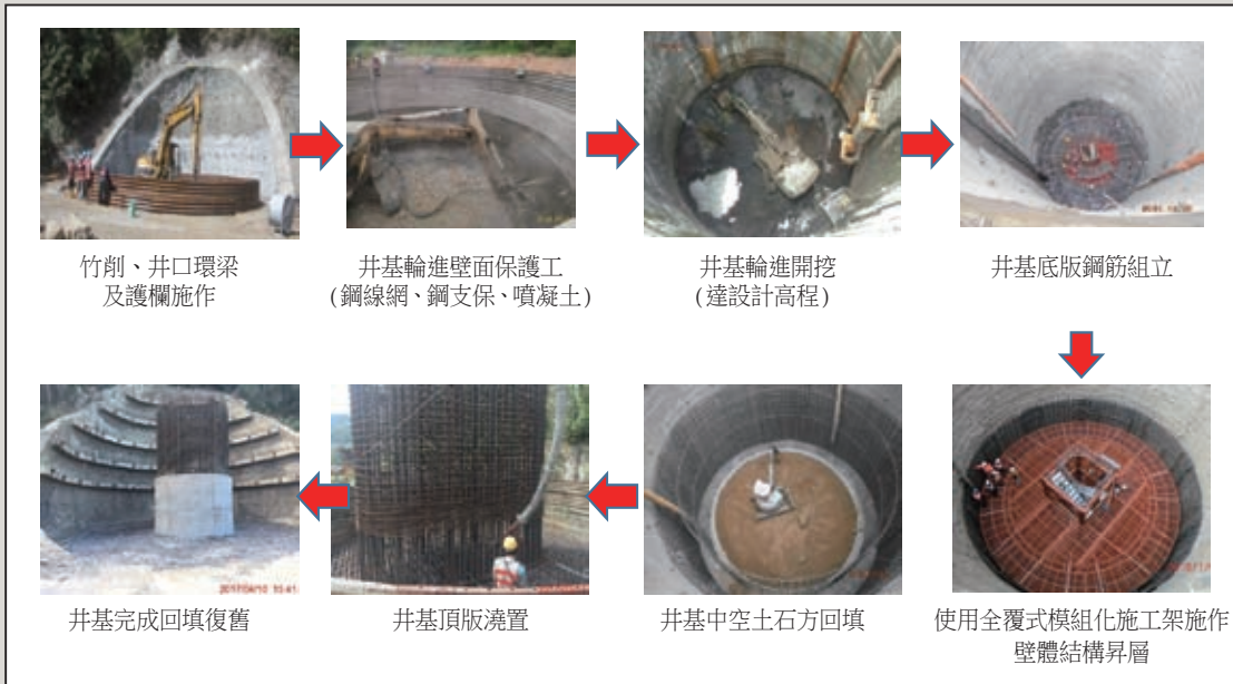
圖2 井式基礎施工流程圖
