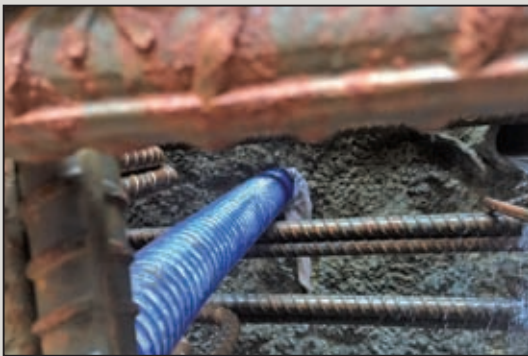
圖9 排水管直接連接壁體安裝
