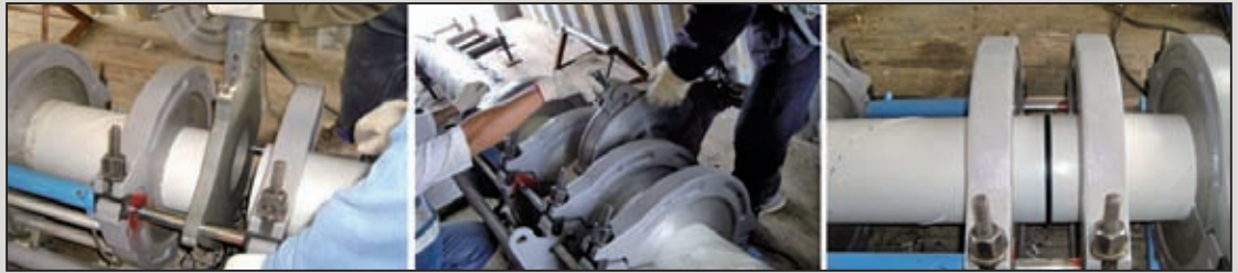
圖20 HDPE外護管熔接
