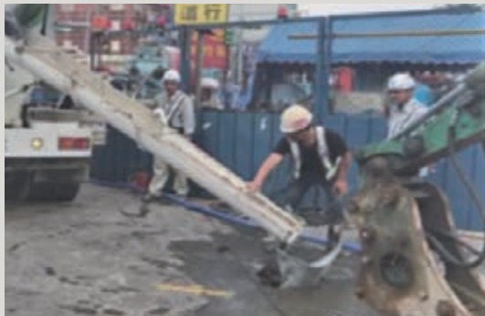
圖13 砂漿填補地層孔洞
