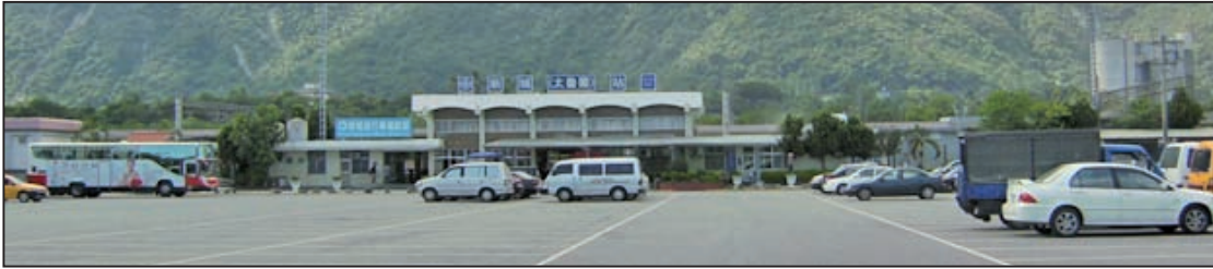
新城車站施工前
