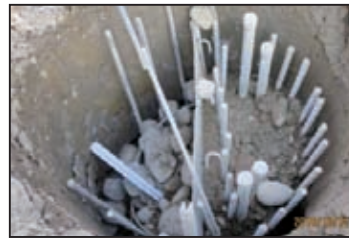
15. 完成 (左：礫石側；右：混凝土側)
