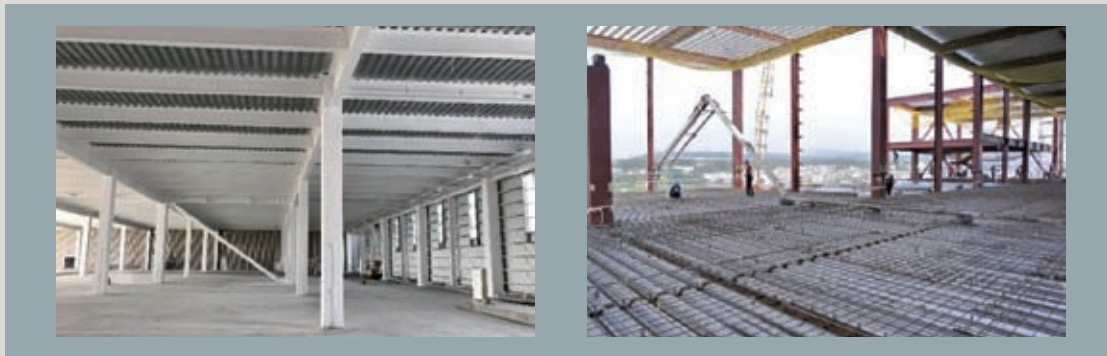
圖6 挑高樓層之樓板採用DECK施工
