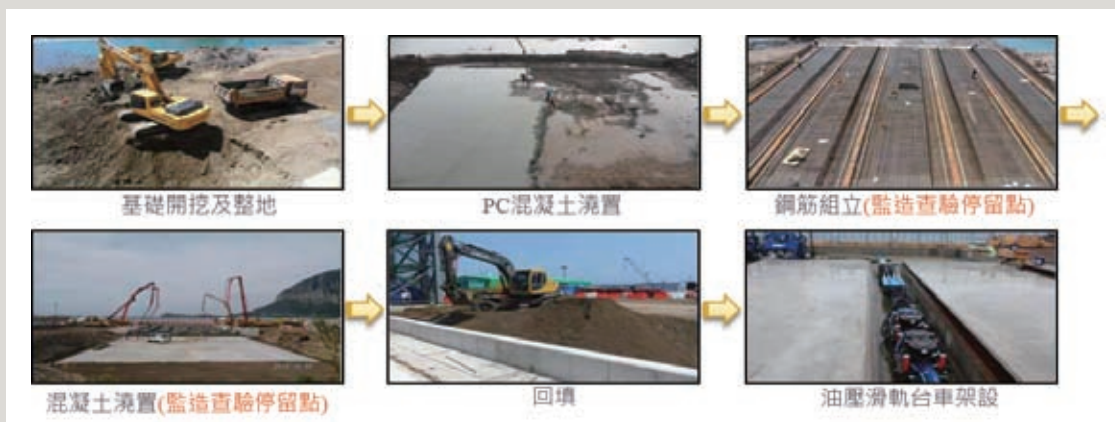
圖9 陸上軌道工法場地建置流程
