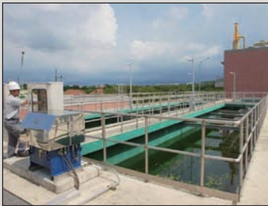
照片A3 刮泥設備功能運轉測試(控制)
