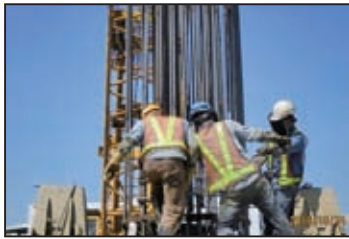
7. 半圓形鋼筋籠主、箍筋搭接
