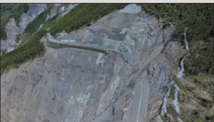
圖16 106年6月2日台20線146K坍方及路基流失
