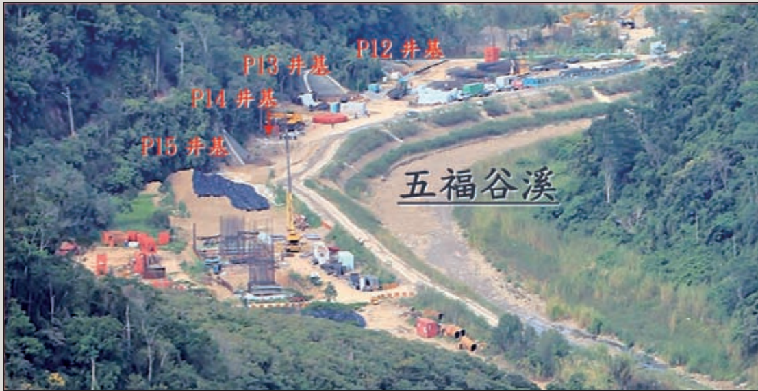
圖3 井式基礎緊鄰五福谷溪之情形
