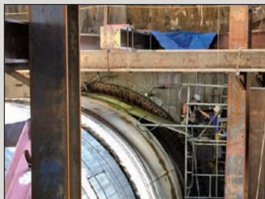
圖33 鏡面周圍水平止水灌漿
