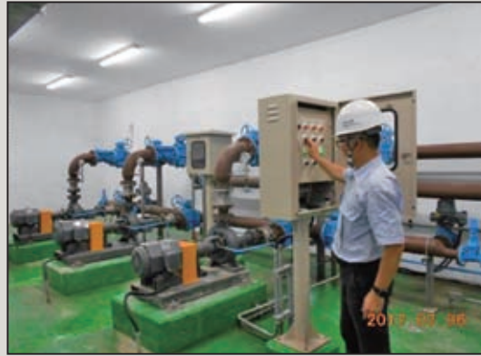
照片A2 泵浦設備功能運轉測試(運轉)
