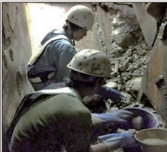
圖31 切刃盤幅梁間礫石清除順序
