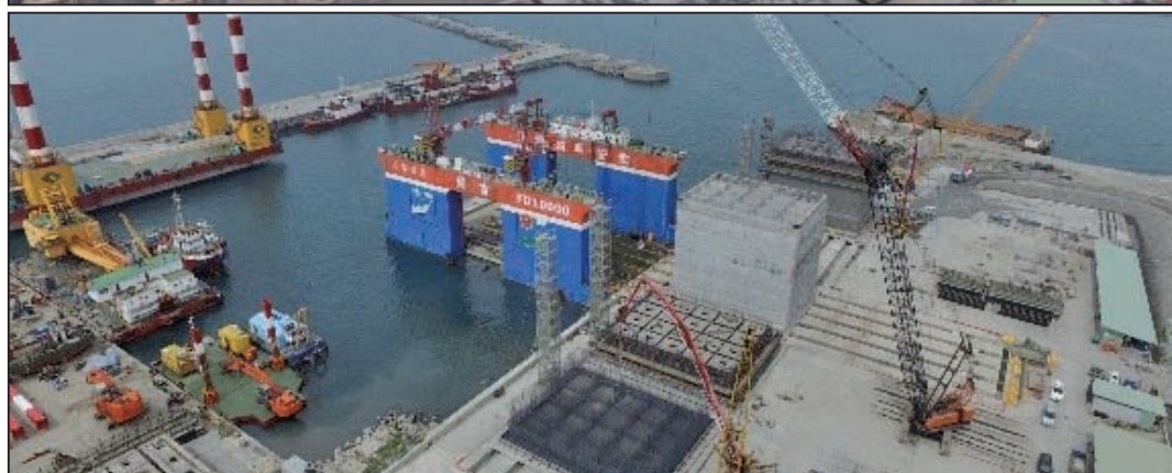
圖21 岸線工程陸上軌道台車運移工法實景
