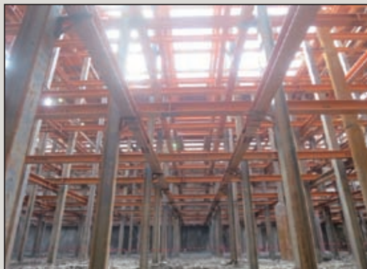
圖7 G9-1開挖擋土支撐現況(第五層支撐-深24m)
