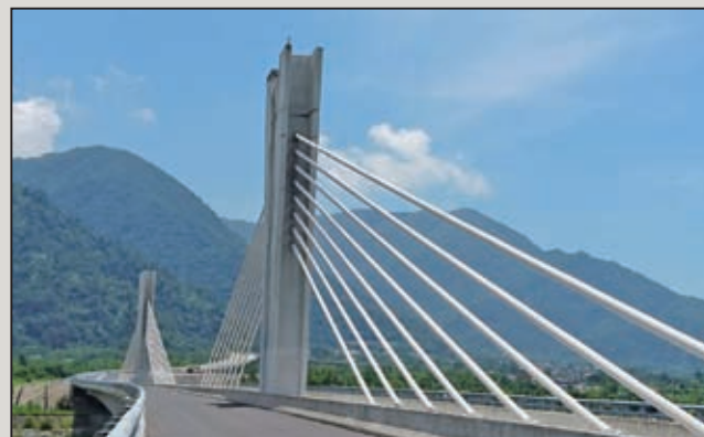
圖2 南澳北溪脊背橋完工照片
