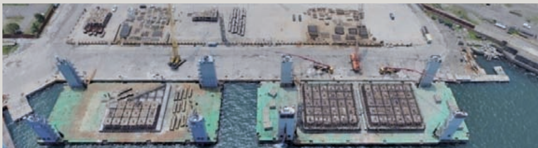
圖2 中工1號、中工3號浮沉台船製作沉箱
