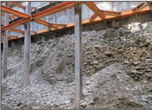
圖8 未能立即掛網噴漿之開挖區先預留土心壓重
