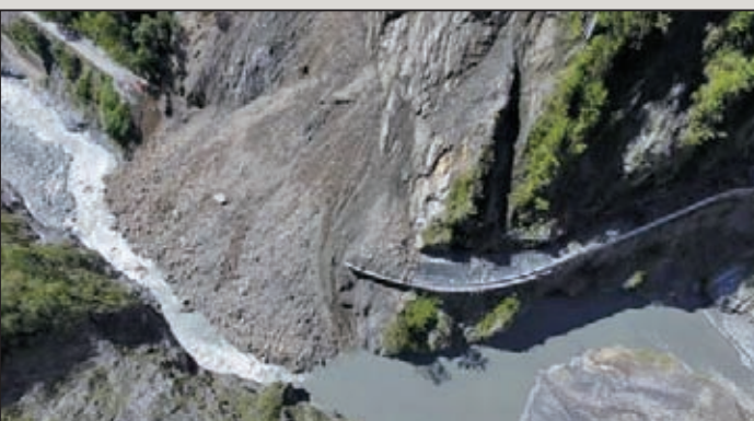
圖15 105年10月4日台20線182k六口明隧道附近坍方
