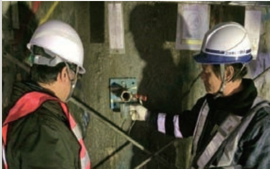
圖15 連續壁鏡面一次破除前水平試水
