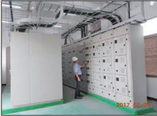
照片A1 電氣設備運轉測試(電壓/電流)
