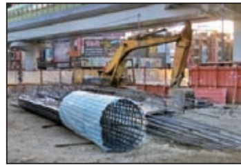
3. 鋼筋籠底部包覆帆布
