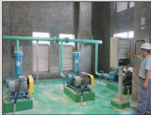
照片A4 鼓風機設備功能運轉測試(運轉)
