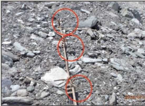
圖11 安全母索固定栓錨錠示意圖
