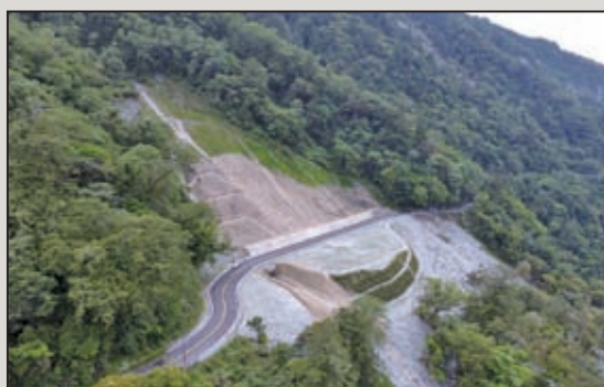
圖5 邊坡植生工法
