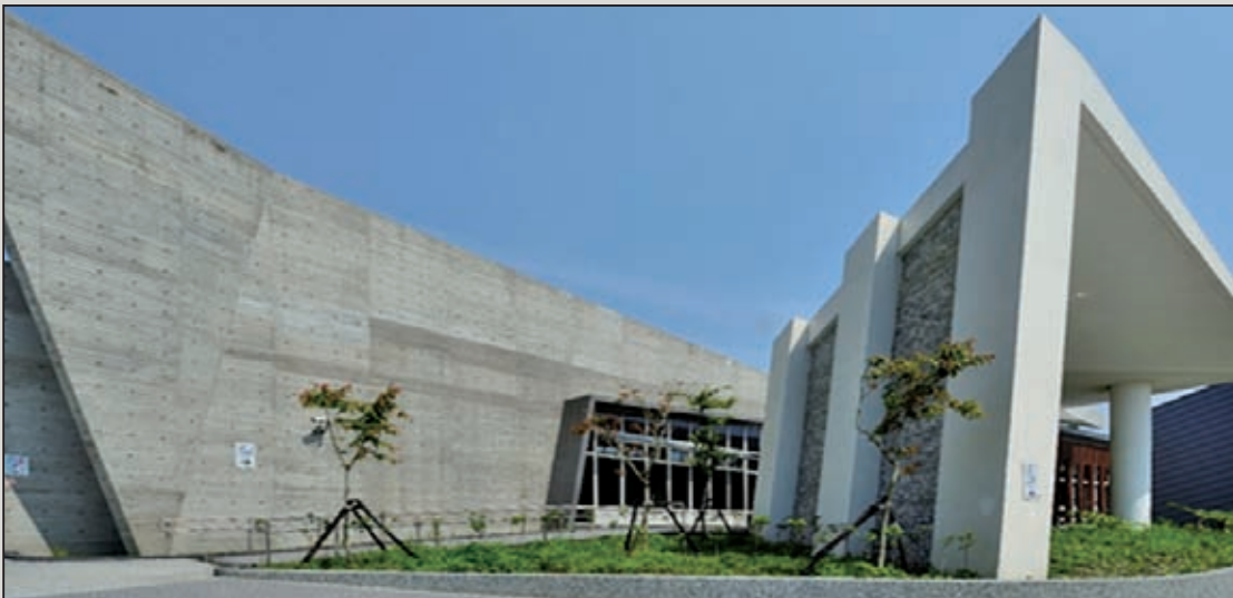
圖16 車站立面仿木紋清水混凝土造型
