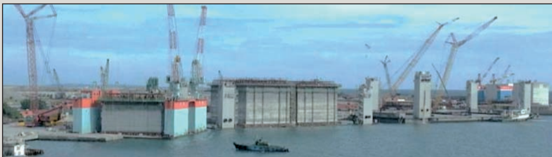
圖15 洲二第一標工程浮沉台船工法實景
