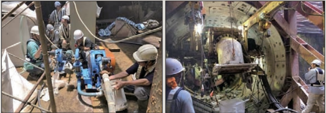
圖22 注入可塑性黏土及螺運機排土作業
