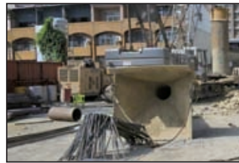
12. 礫石傾倒槽準備
