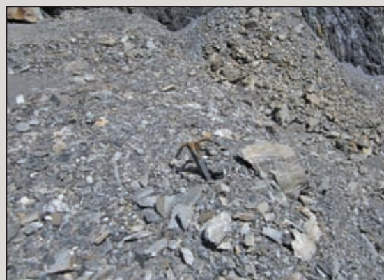
圖8 錨錠彎鉤以防繩索脫落
