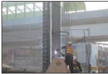
8. 半圓形鋼筋籠背板焊接
