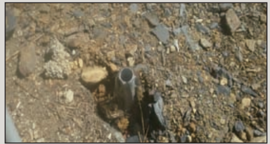
圖15 灌漿時鄰近PVC管出水，顯示透水環未阻塞
