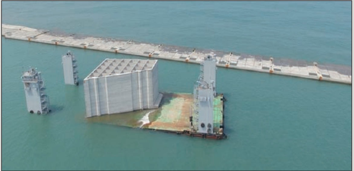
圖11 一次完成工法製作異型沉箱
