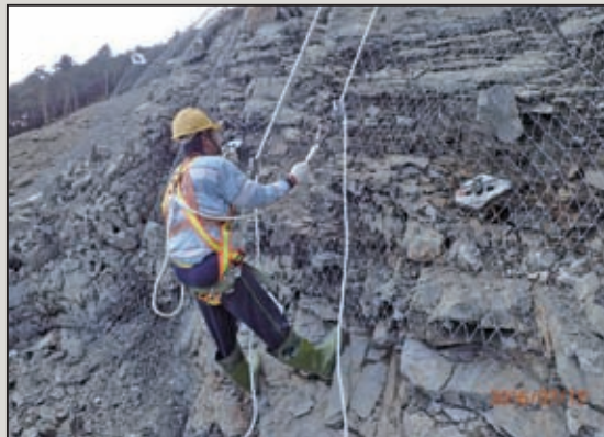
圖14 邊坡施工人員進場施工示意圖
