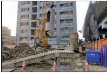
4. 全套管擋土樁鑽掘
