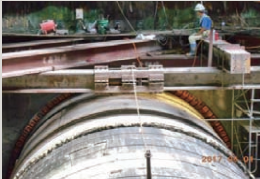
圖11 鏡面上方水平灌漿
