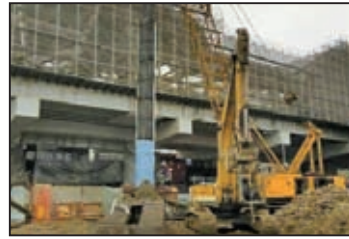
6. 半圓形鋼筋籠吊放
