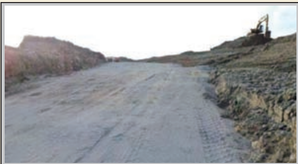
106年1月17日「台北港使用底渣再生粒料」鋪設情形
