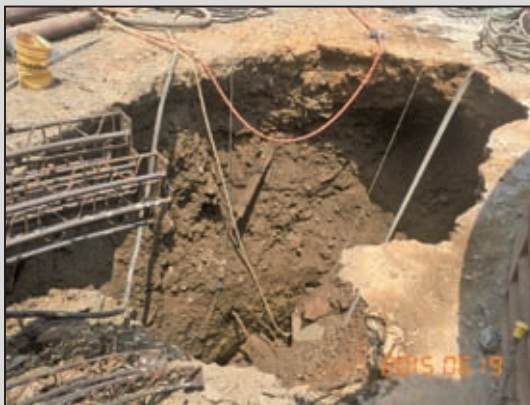
圖6 井基外側地面坍塌
