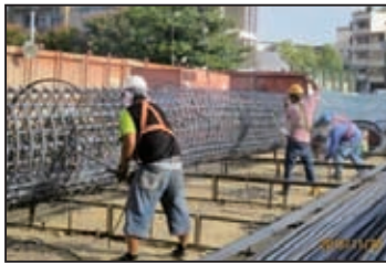
1. 半圓形鋼筋籠製作
