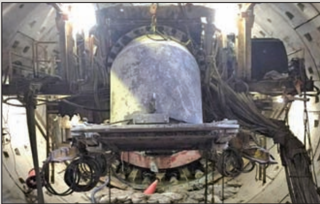
圖19 螺運機二次閘門
