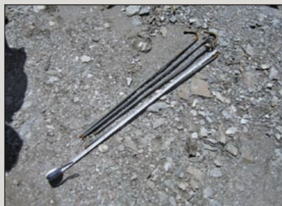
圖7 錨錠鋼筋尺寸確認
