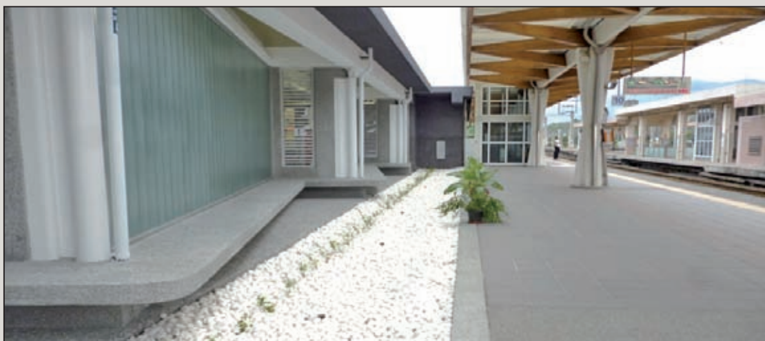
圖7 增設第一月台(岸壁式)現況
