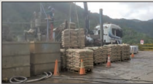
圖14 透水環孔隙灌漿
