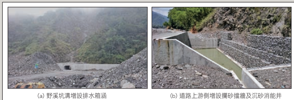
圖26 野溪坑溝佈設考量完工照片
