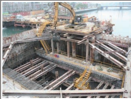
(1) 鋼板樁打設圍堰
