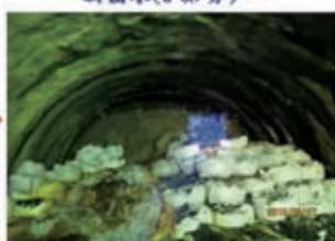
6/27 NS688輪右側支保 腳較高位出水(24.1噸/分)
