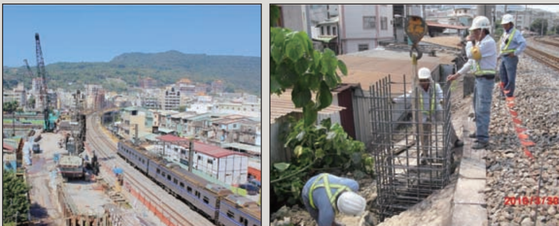
圖5 緊鄰營運中鐵道及既有建物施工
