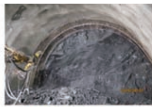
6/7 NS687輪開挖面
