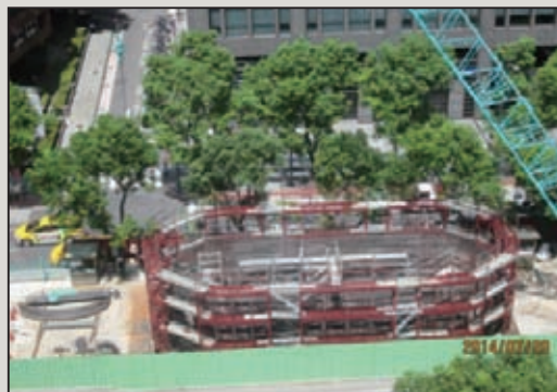
圖10 台電沉箱壓入
