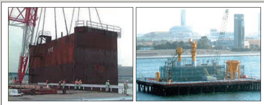
圖5 日本東京晴豐2號橋下部工程採壓氣沉箱施工(2004.12~2006.9)
