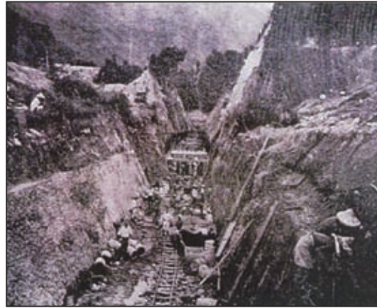
東口隧道掘鑿作業
