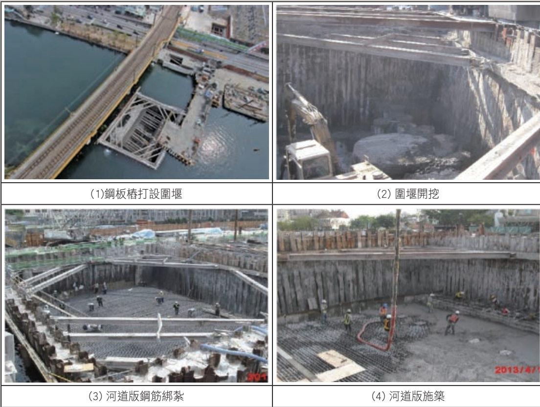
圖17 圍堰河道版施工
