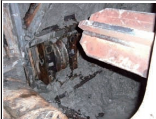
土艙內設置攪拌棒
