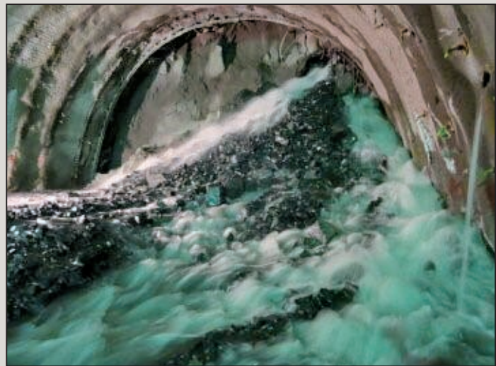
圖22 北口南下線里程7K+200.5(688輪)突發性大量湧水
