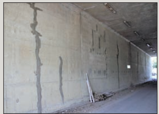
圖7 國十13k+772箱涵結構裂縫
