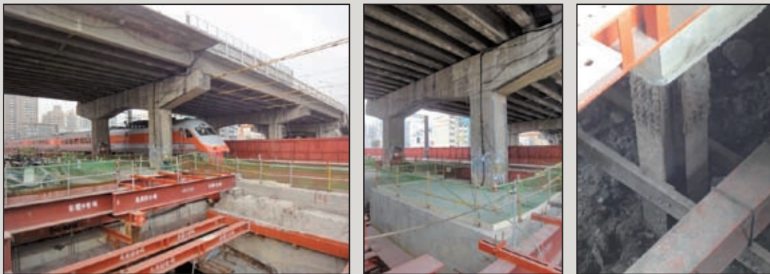
圖7 東側P6與P7托底橋墩與支撐版、臨時支撐柱施工狀況
