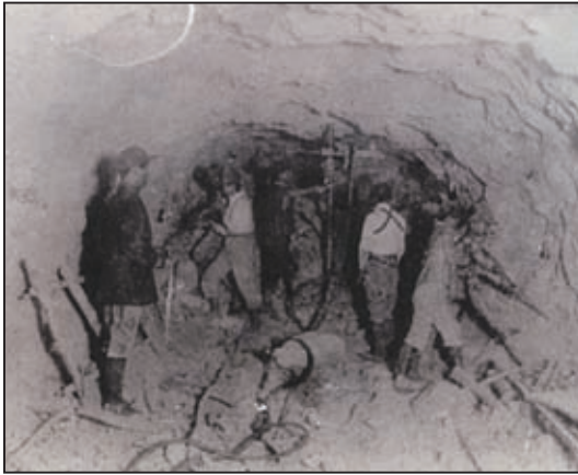
隧道掘鑿作業
