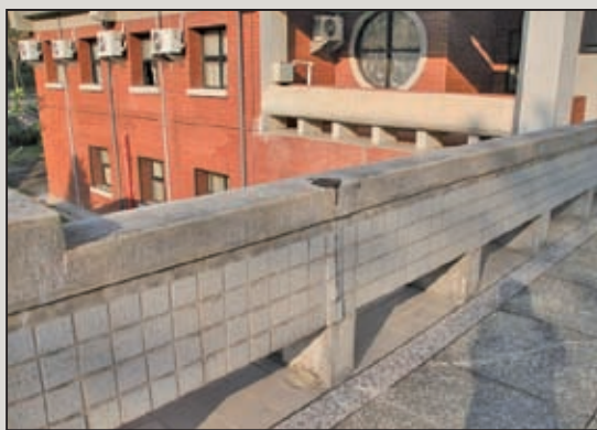
圖6 高師大物理館路橋結構裂縫
