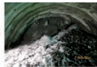
6/11 NS688輪右側支保 腳較高位出水(27噸/分)
