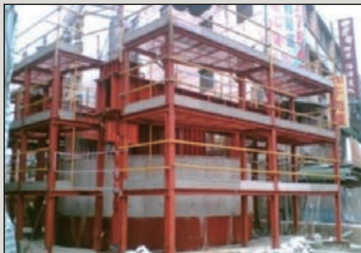
圖9 北捷壓入沉箱施工
