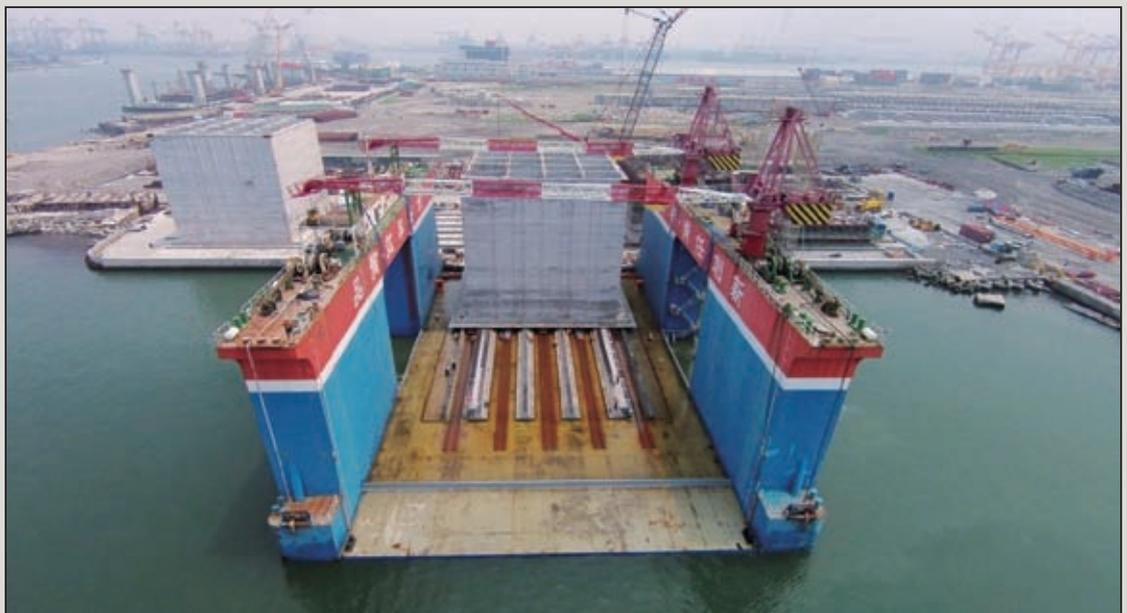
圖5 陸上軌道工法沉箱製作場
