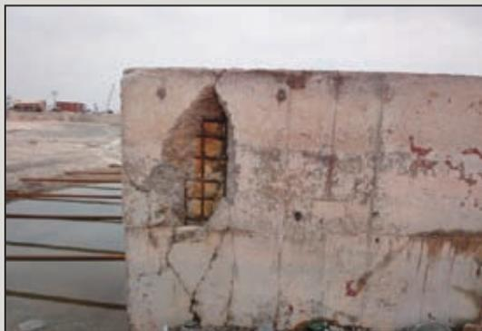
圖31 碼頭胸牆受損、鋼筋外露
