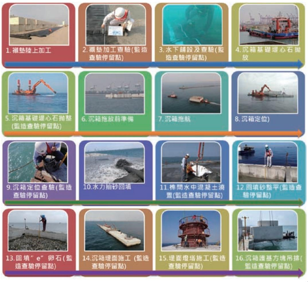
圖4 沉箱堤施工流程
