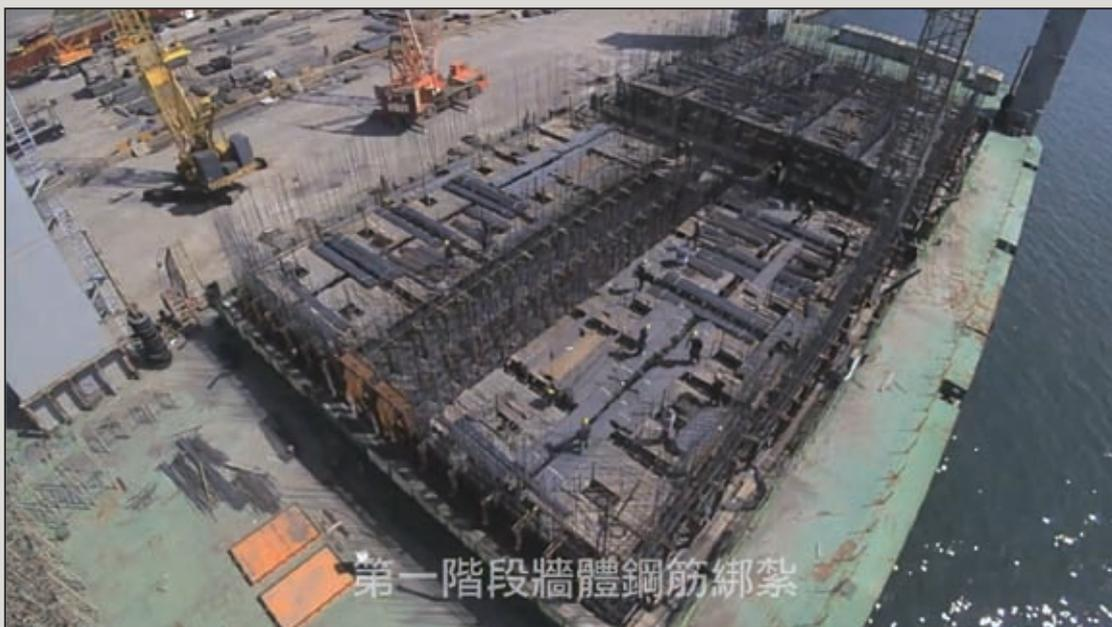
圖17 沉箱製作縮時攝影示意照片
