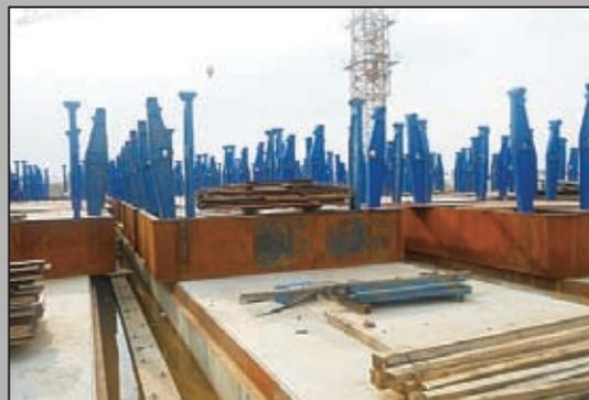
圖10 自動化滑模系統工法施工實景2
