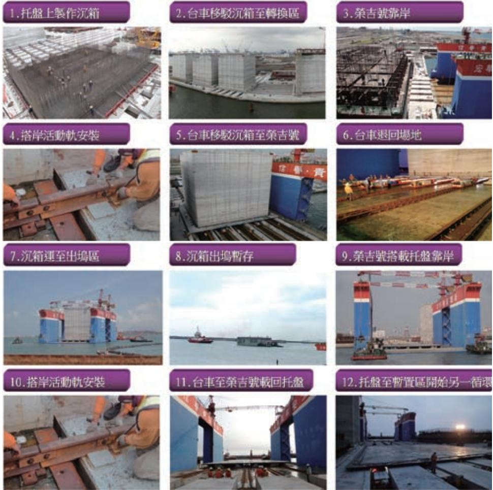
圖19 沉箱移運施工流程圖
