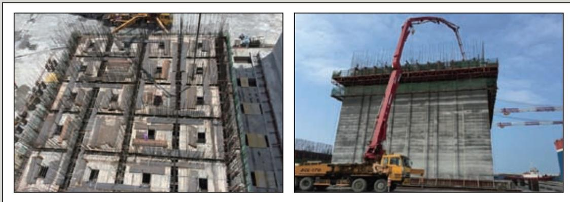
圖10 自動化滑模系統工法施工實景
