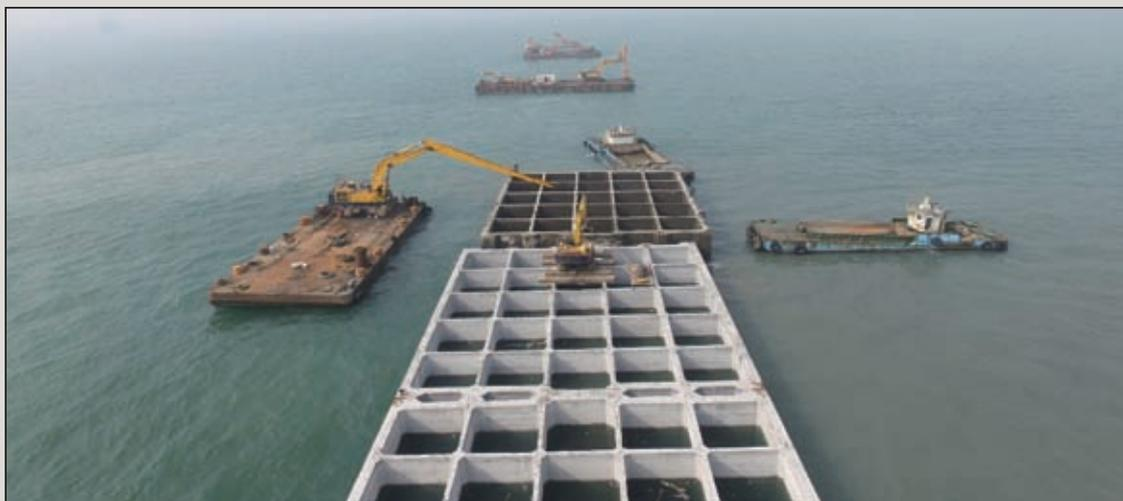
圖19 三組整平船機同時施作以提昇整平效率
