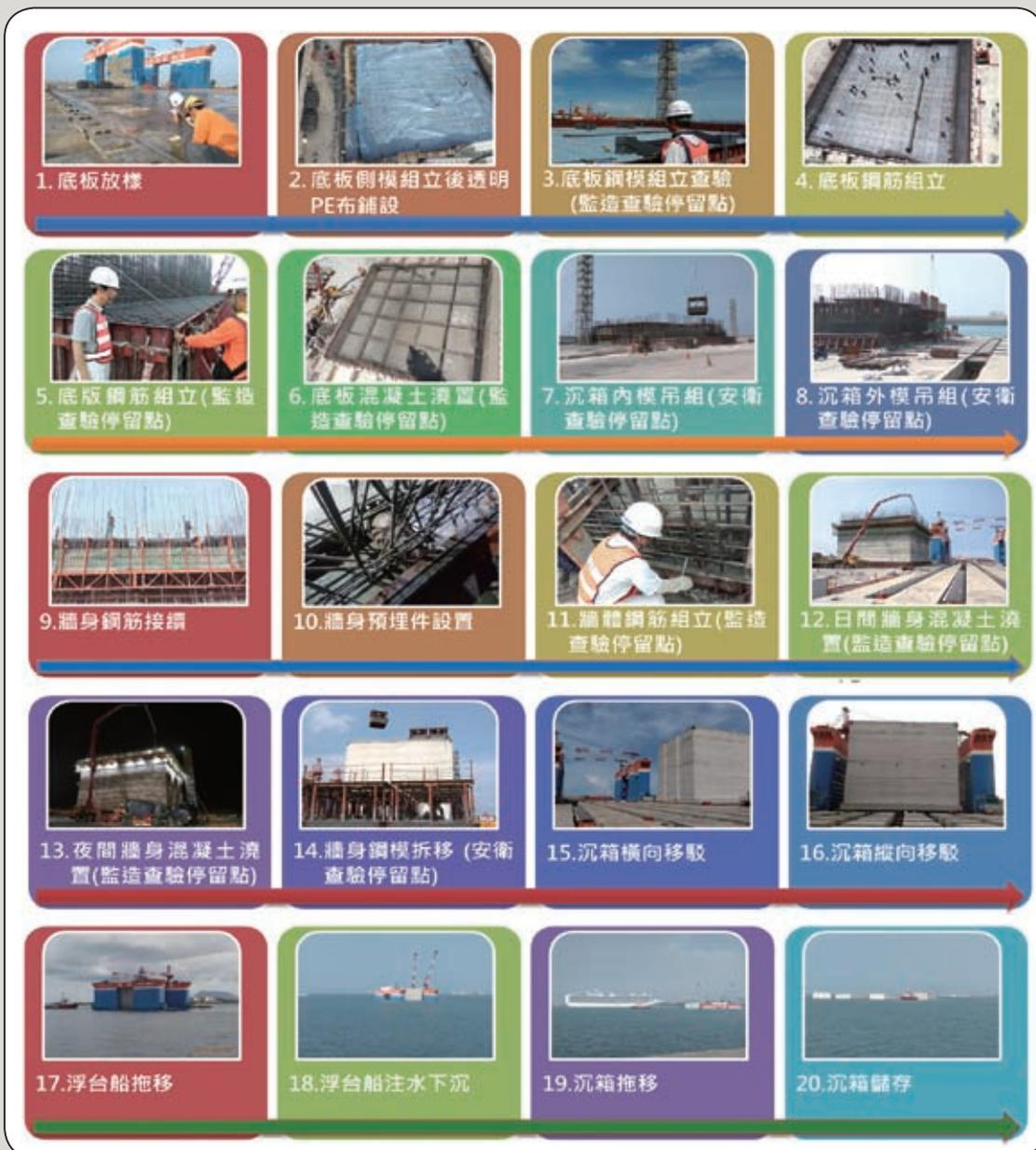
圖6 沉箱製作流程(含監造及安衛查驗停留點)
