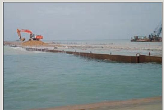
圖30 沉箱回填砂越浪流失
