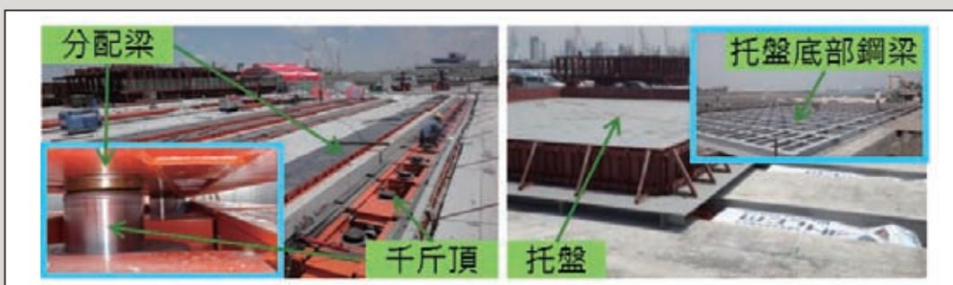
圖18 鋼製承壓托盤，適用不同型式沉箱
