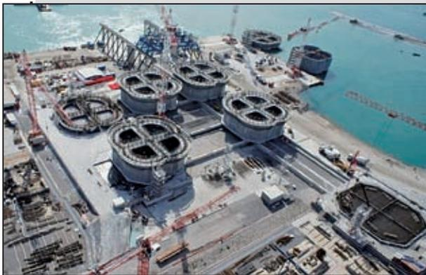
圖6 摩洛哥丹吉爾港軌道工法示意照片
