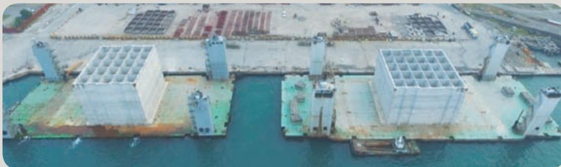
圖2 中工1號、中工3號浮沉台船製作沉箱
