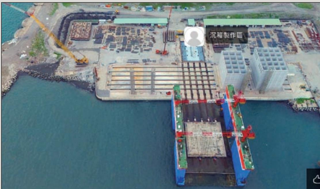
圖21 陸上軌道台車運移工法實景
