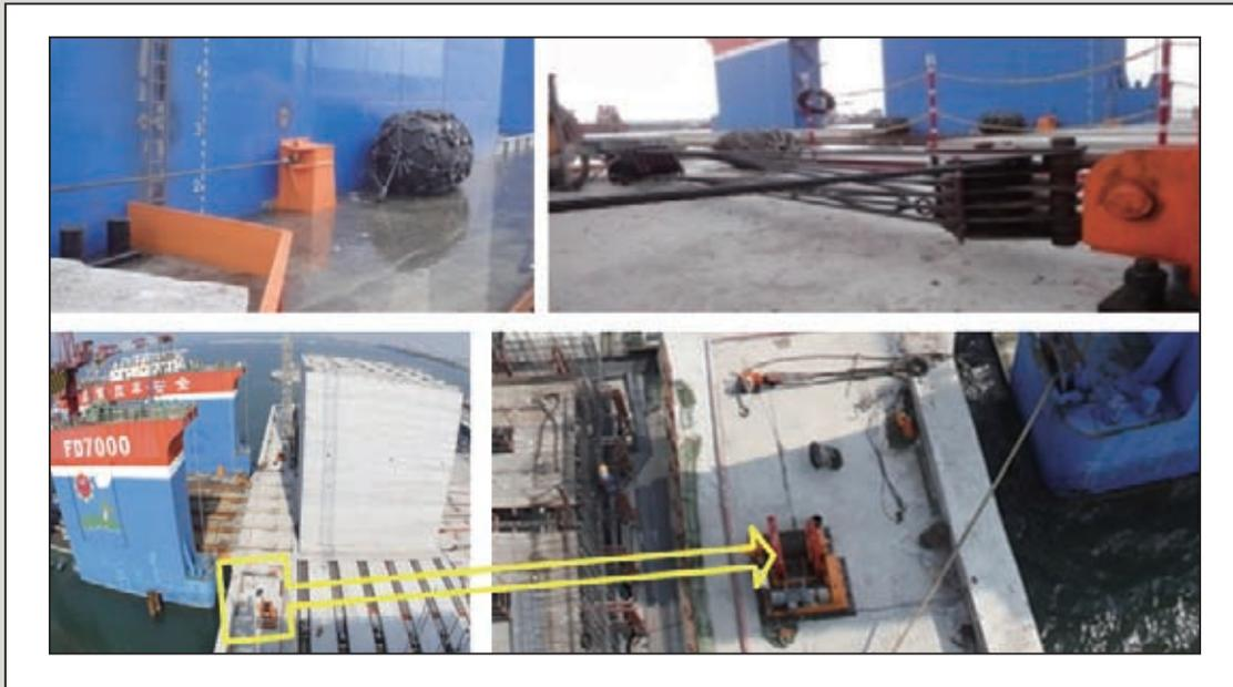
圖24 陸上工法沉箱移運及接駁船水位關係圖
