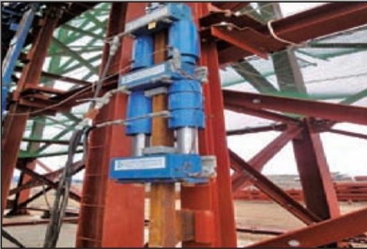
圖9 自動化滑模系統工法施工實景1
