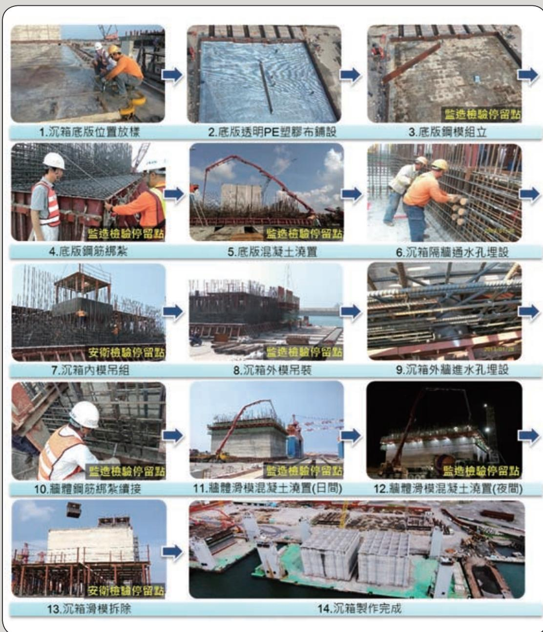
圖3 一次完成工法施工流程
