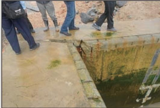
圖27 港勤船渠轉角颱風過後鋼筋外露
