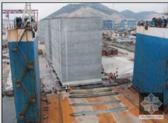
圖4 大陸氣囊工法示意照片
