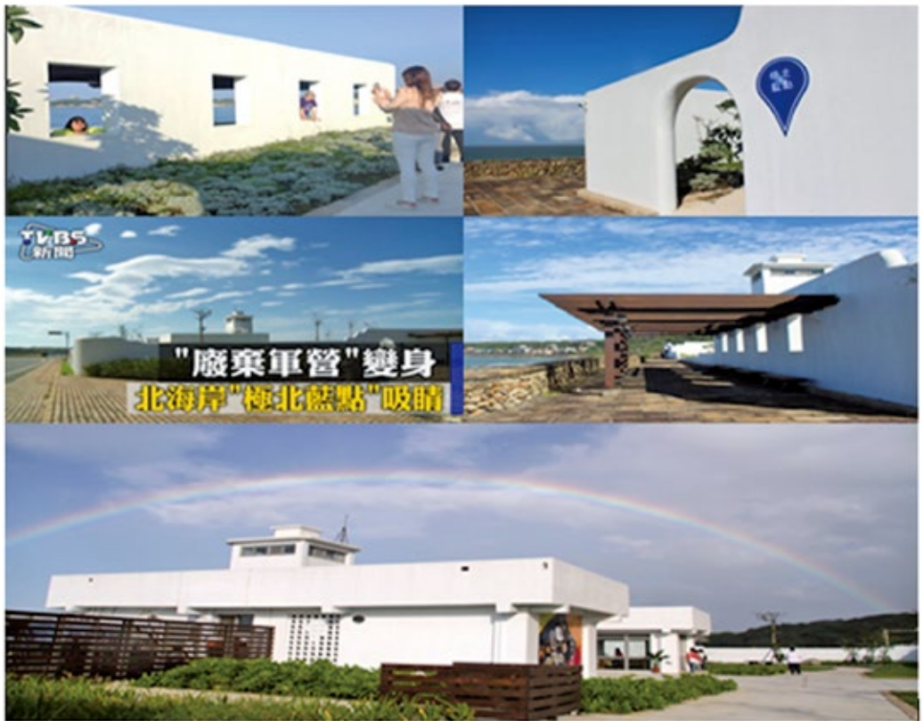
圖13 下員坑廢棄營區改造後之外觀
