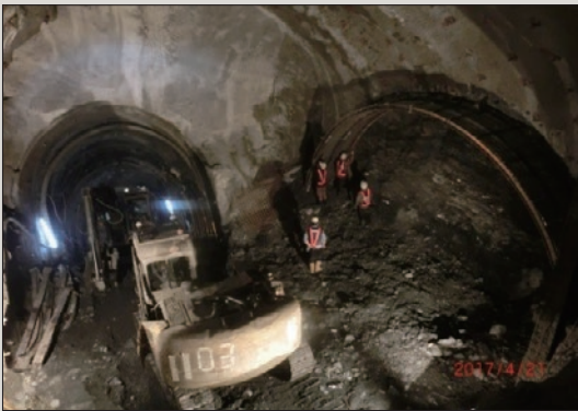
圖 18 7k+890通風管道向北轉彎施工
