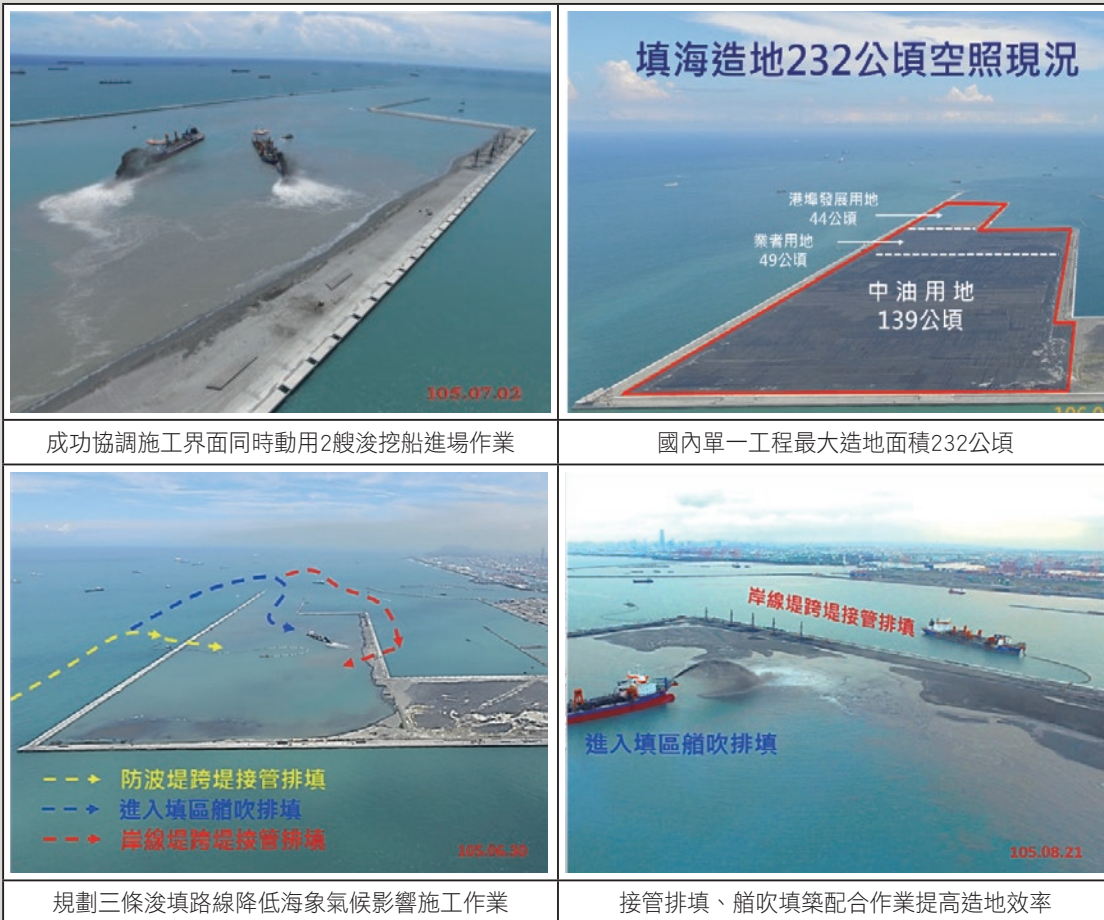
圖2 二艘超大型自航自載耙吸式船機(總泥艙量53,000方)同時作業
