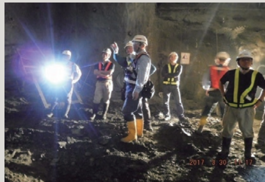
圖17 7k+890通風管道3/30處長現勘
