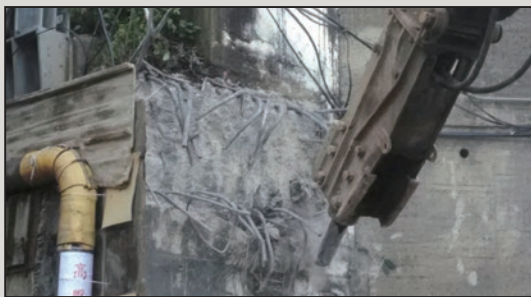
圖17 既有帽梁側邊打除
