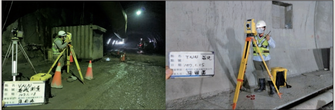
圖4 導線測量現場施作照片
