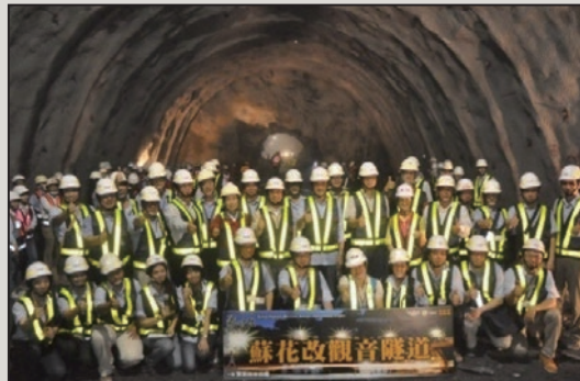
圖10 觀音隧道全線(南下線)貫通相片
