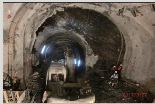
圖16 7k+890通風管道3/27施工正常
