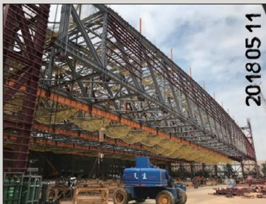
圖11 鋼構提升(第二階段)照片
