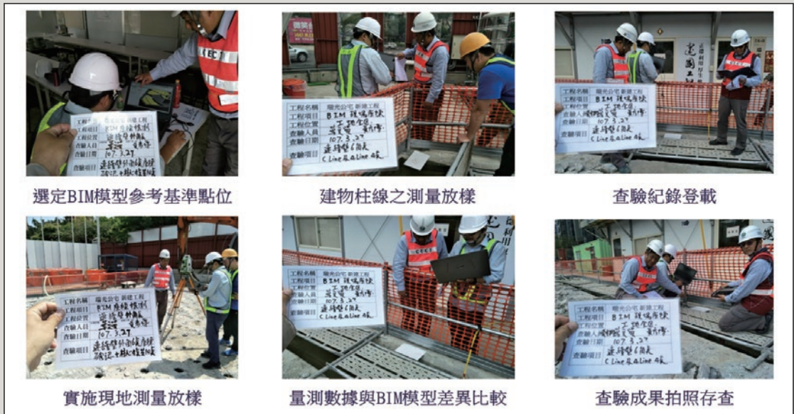
圖14 以BIM模型放樣複校圖例
