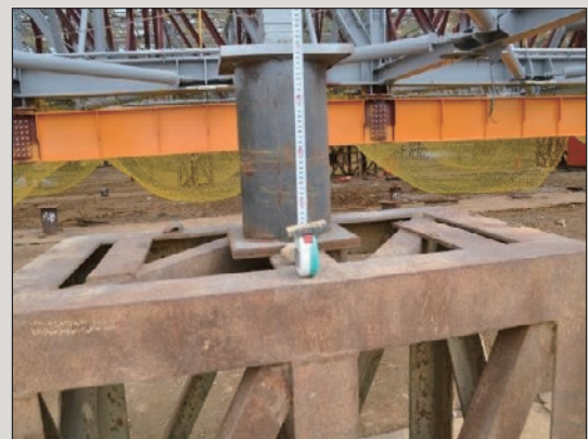
圖12 吊點懸掛鋼尺照片
