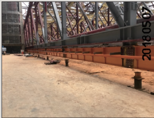
圖9 鋼構桁架提升至1M處(第一階段)照片
