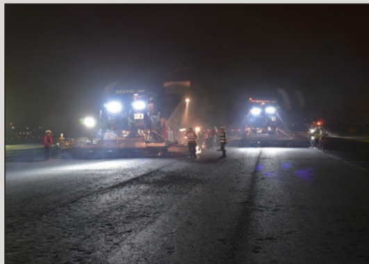
圖2 跑道全斷面瀝青混凝土鋪築
