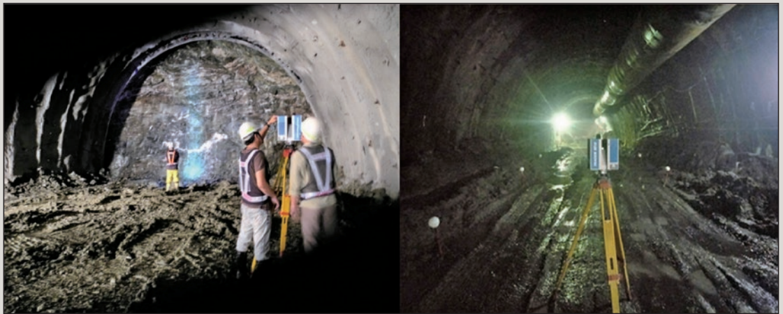
圖9 現場3D掃瞄作業照片
