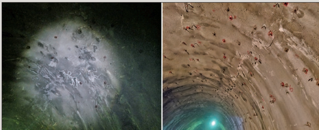
圖14 VNN-T5 16-655輪局部支撐裂縫異狀照片
