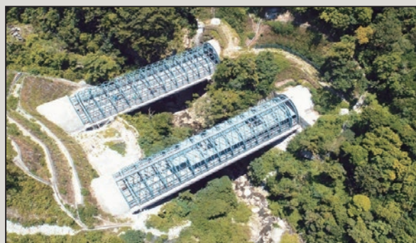
圖2 谷風觀音隧道間鼓音橋施工空拍照
