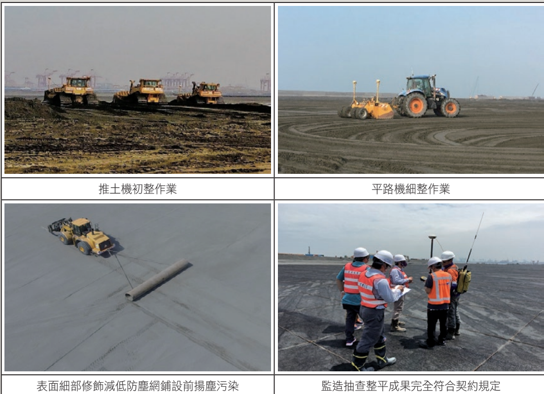
圖10 整平機具配備RTK整平作業流程
