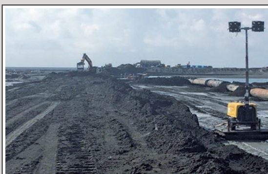
無需測量人員輔助，機具可24小時施工
