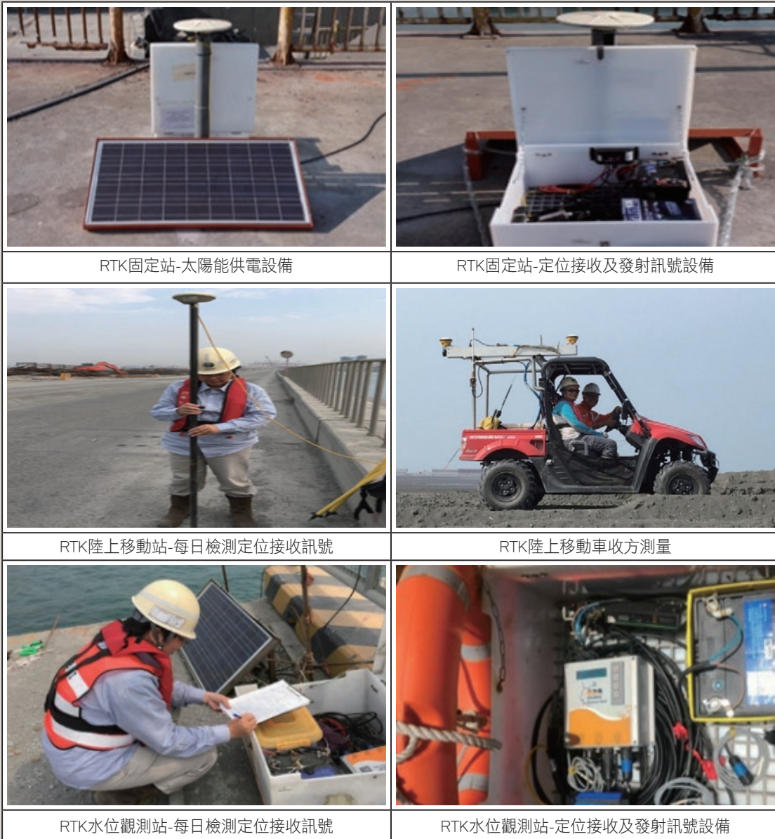
圖6 RTK相關設備設置及控制應用
