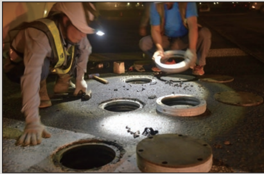
圖3 跑道進場燈昇筒環片安裝
