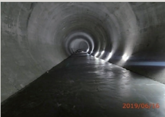
圖 19 7k+890通風管道施工完成
