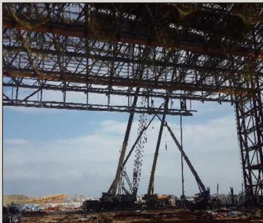
圖21 N軸構件桁架安裝照片
