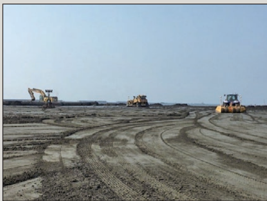
圖4 作業區域內全機械自動化作業
