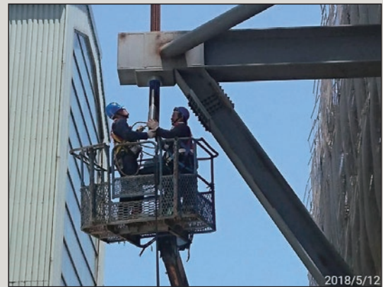
圖10 背拉鋼絞線補施拉預力照片
