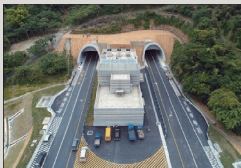
圖3 觀音隧道北洞口施工完成空拍照
