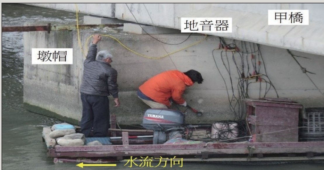
圖8 甲橋超震法檢測照片
