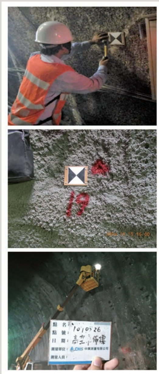
圖3 規標佈設示意照片
