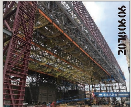
圖22 N軸構件桁架安裝完成照片
