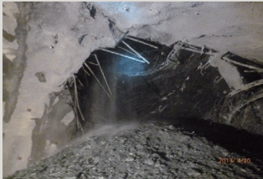
圖13 NS5 T124至T129輪抽坍出水照片
