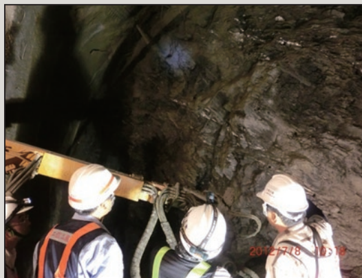
圖7 地質師現場評估與工程處長巡查
