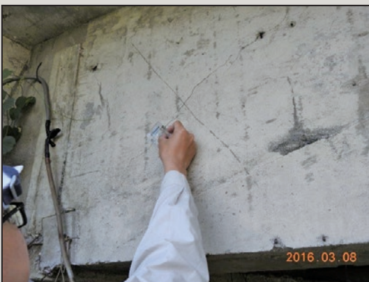
圖14 靠近支承處梁腹板45度斜向裂縫
