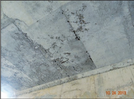
圖29 版梁底面蜂窩、鋼筋外露
