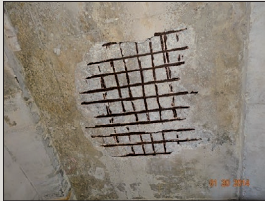
圖3 主梁間橋面板混凝土鋼筋銹蝕所衍生的混凝土裂縫、整片剝離及剝落現象
