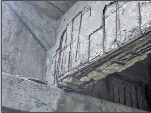
圖16 主梁混凝土剝離、剝落、鋼筋外露銹蝕
