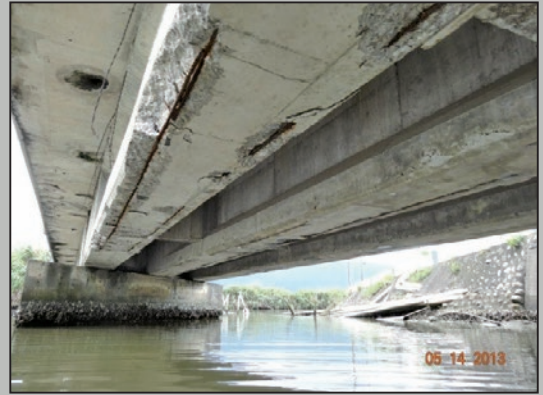
圖17 主梁底部混凝土剝落、鋼筋外露銹蝕
