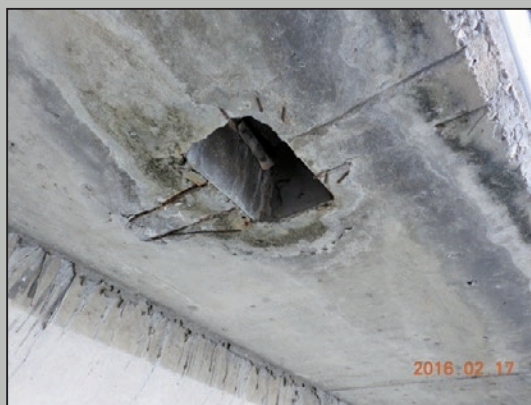
圖4 橋面板洩水孔處周圍鋼筋外露、銹蝕
