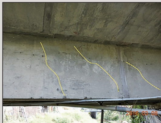
圖15 主梁腹板裂縫
