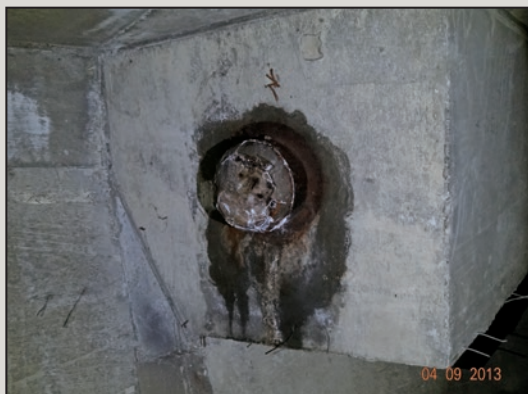
圖24 預力端錨頭銹蝕、水痕
