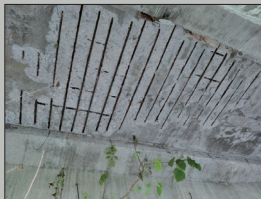
圖7 主梁間橋面板混凝土剝落、鋼筋外露銹蝕
