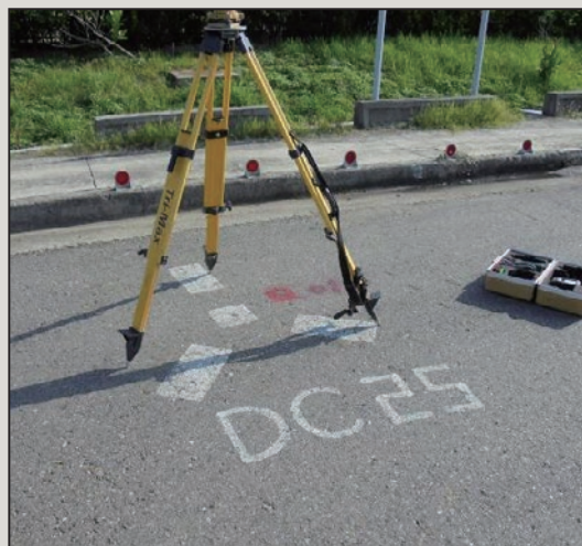
圖10 現場作業及地面航標點
