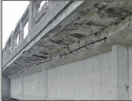
圖21 主梁上翼板鋼筋外露銹蝕
