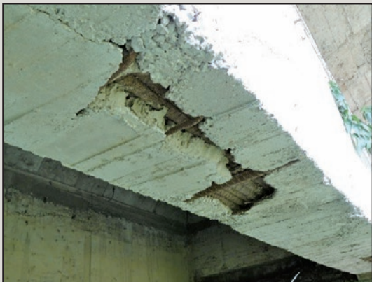
圖26 主梁梁底混凝土蜂窩、空洞（一）
