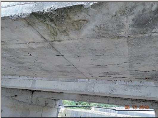
圖1 橋面板混凝土剝離
