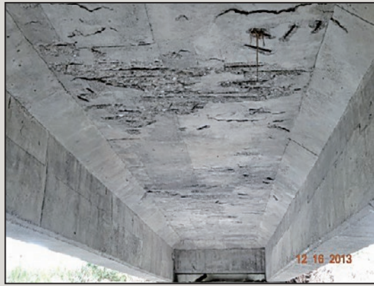
圖2 主梁間橋面板混凝土剝離、剝落、鋼筋外露銹蝕
