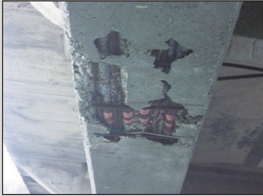
圖25 主梁梁底處因混凝土蜂窩導致鋼筋與鋼筋外露、銹蝕
