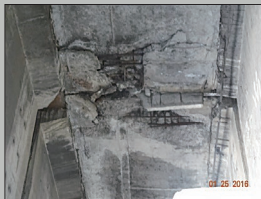
圖5 伸縮縫處橋面板混凝土破碎、鋼筋外露銹蝕
