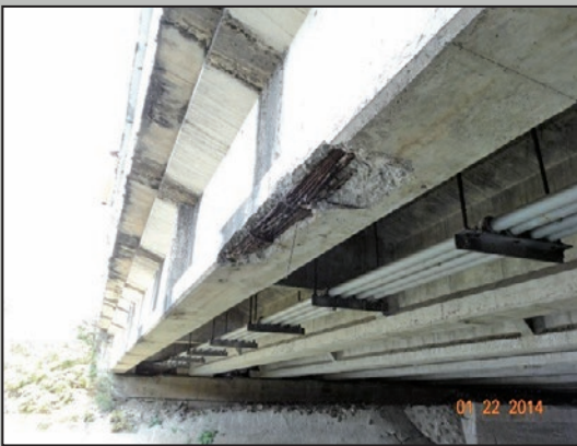
圖22 主梁主筋外露銹蝕
