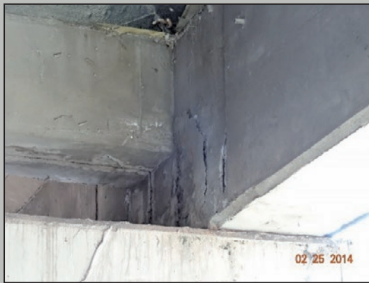
圖18 梁端腹板混凝土剝離
