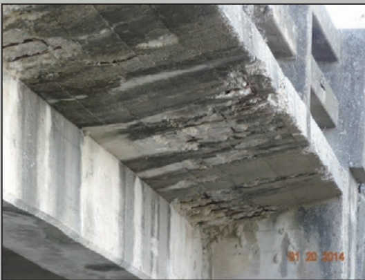
圖8 懸臂板底面混凝土白華、鋼筋銹蝕引致混凝土脫落
