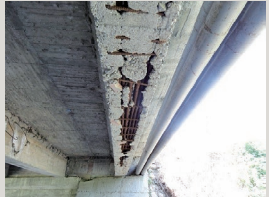
圖27 主梁梁底混凝土蜂窩、空洞（二）
