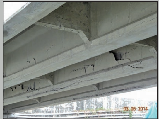
圖19 預力混凝土梁混凝土嚴重剝離、剝落、開裂
