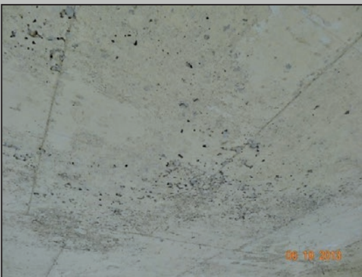
圖10 橋面板混凝土氣孔、蜂窩
