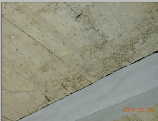
圖11 橋面板混凝土蜂窩、鋼筋外露
