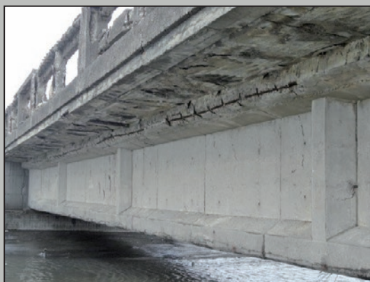
圖6 懸臂板混凝土剝離、剝落、鋼筋外露銹蝕
