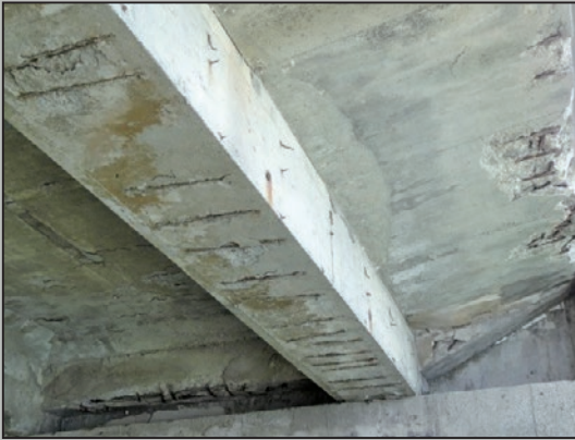
圖20 主梁梁底橫向箍筋外露銹蝕
