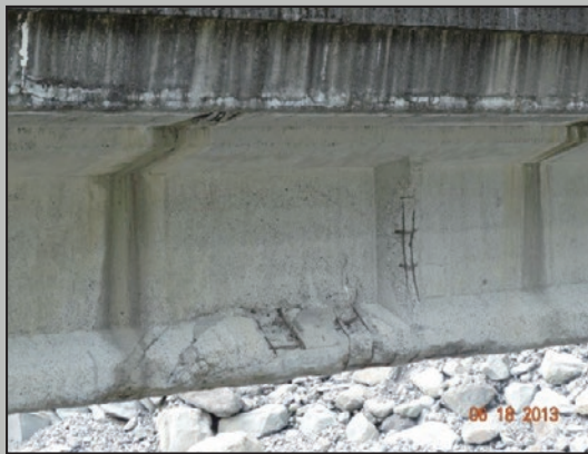
圖23 主梁混凝土磨損、鋼筋外露
