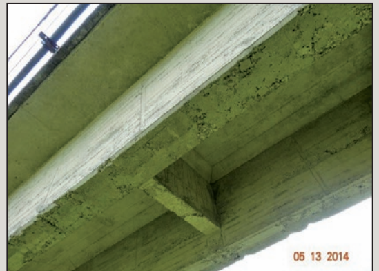
圖28 主梁梁底及腹板混凝土蜂窩
