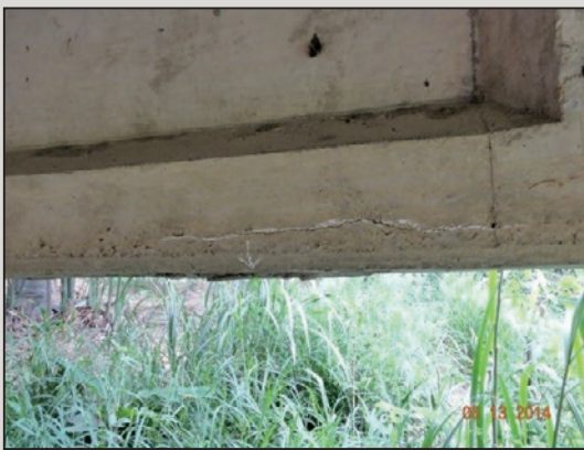
圖12 預力混凝土梁下翼板縱向裂縫
