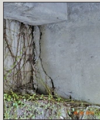
圖13 梁端混凝土開裂
