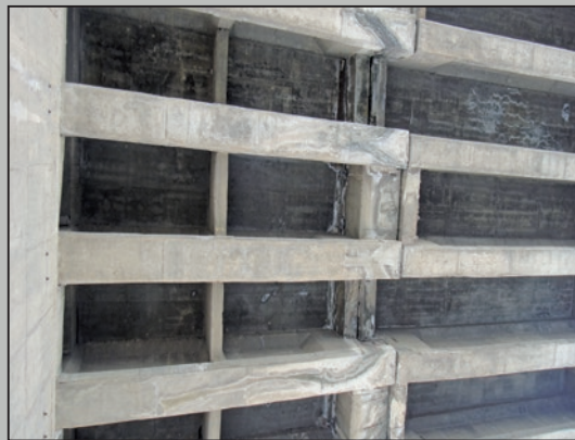
圖9 鄰近伸縮縫之橋面板底面混凝土表面具水痕、白華痕跡
