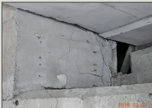
圖19 止震塊裂縫
