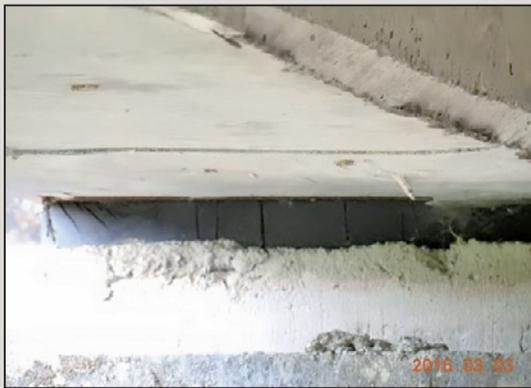
圖11 橡膠支承垂直裂縫
