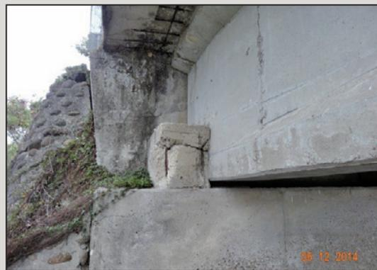
圖22 止震塊混凝土開裂、剝落、鋼筋外露銹蝕
