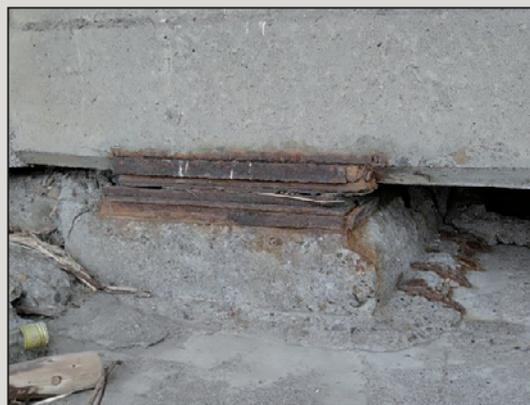
圖9 橡膠支承上下鋼板銹蝕、膨脹，橡膠材料老化
