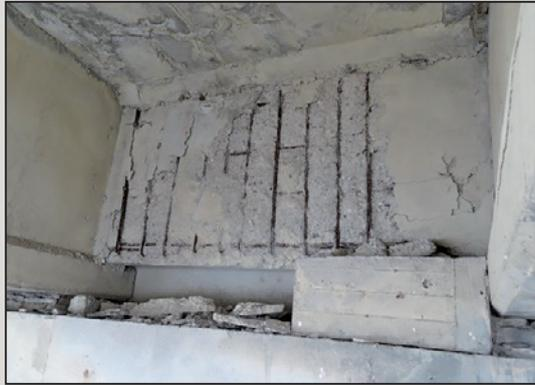
圖6 橫隔梁混凝土剝落、鋼筋外露銹蝕
