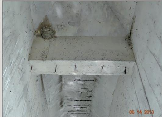
圖3 橫隔梁底板鋼筋外
