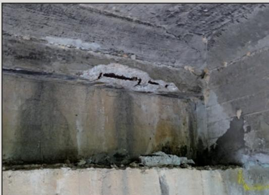
圖2 端隔梁與主梁接縫處混凝土剝離、剝落、鋼筋外
