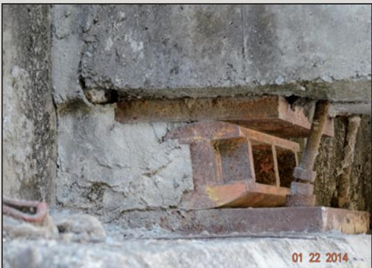
圖18 支承移動不當受限，螺栓彎曲損傷
