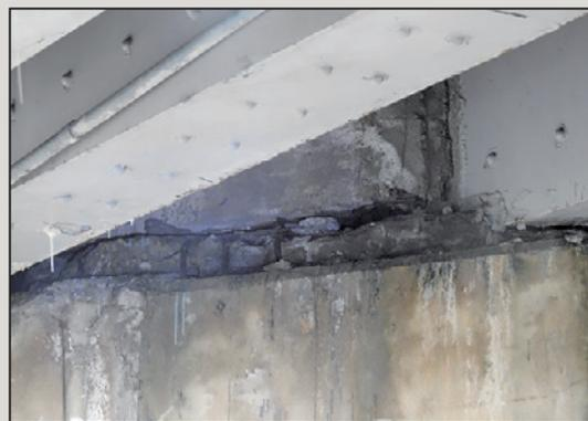
圖23 止震塊破裂、鋼筋外露銹蝕
