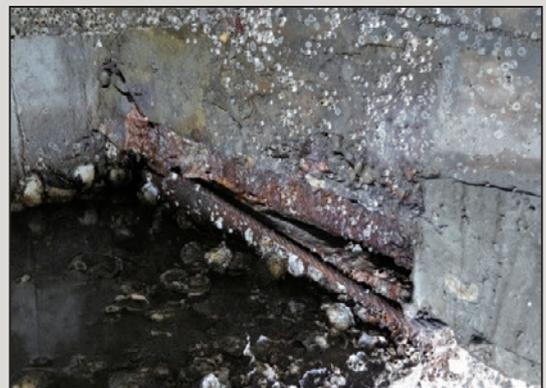
圖14 鈹支承鋼板銹蝕、膨脹
