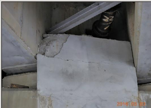
圖20 止震塊破損
