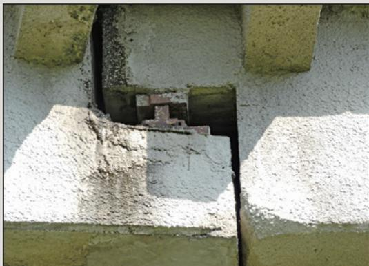
圖17 支承鋼板銹蝕位移
