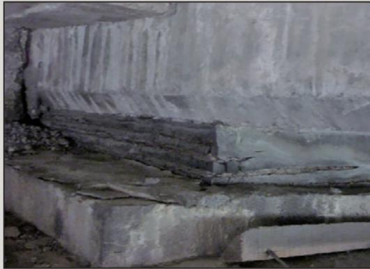
圖10 橡膠支承開裂、內部鋼板銹蝕
