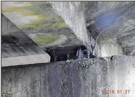
圖15 鑄鋼支承銹蝕、脹裂
