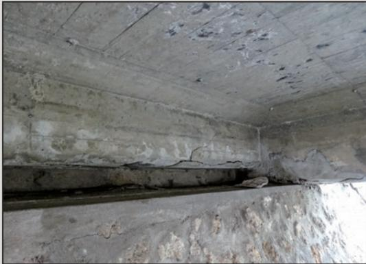
圖1 端隔梁混凝土裂縫與白華
