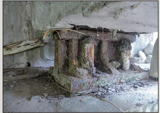
圖13 鑄鋼支承銹蝕、層裂
