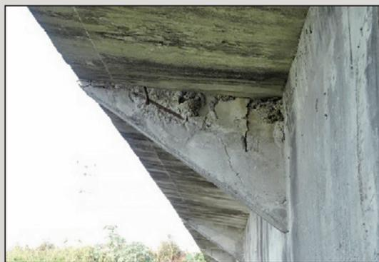
圖5 懸臂板托梁混凝土剝落、鋼筋外
