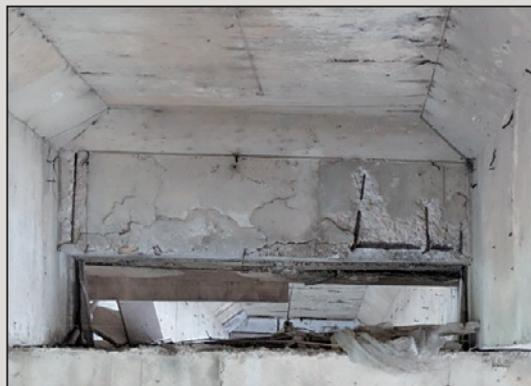
圖4 橫隔梁混凝土裂縫、剝離、剝落、鋼筋外
