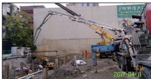
人工擋土柱混凝土澆置
