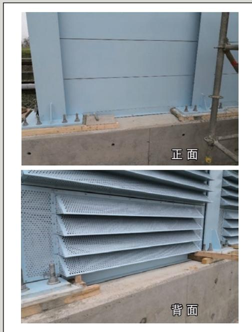
圖13倒 N型吸音板提高隔音牆吸音率
