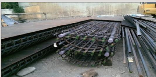
圖10 半圓形人工擋土樁鋼筋籠
