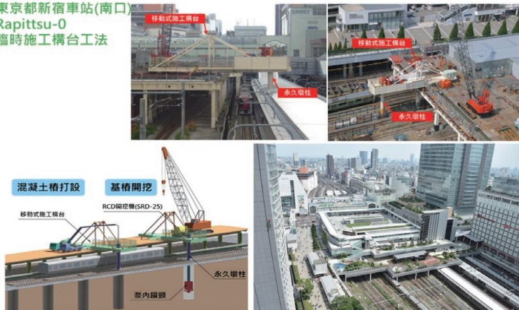
圖5 跨站式平台施工案例示意圖(5)
