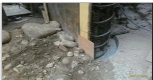
開挖側採原土回填
