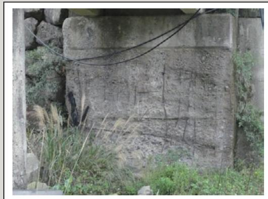
圖6 橋台混凝土磨蝕、鋼筋外露變形
