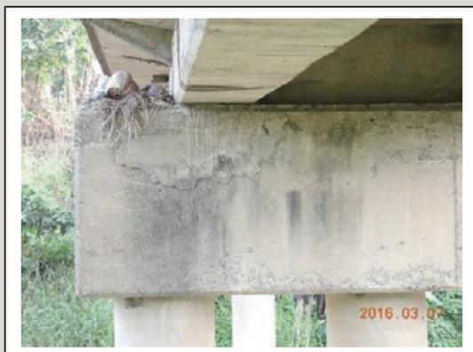
圖19 帽梁支承處混凝土開裂
