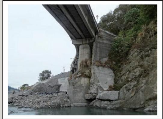
圖37 沉箱基礎裸露、護岸崩塌
