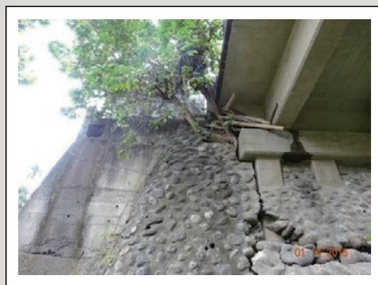
圖14 橋台護坡植物生長、開裂
