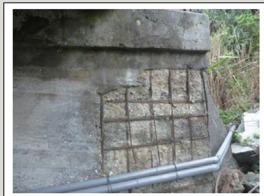
圖7 橋台混凝土剝落、鋼筋外露、嚴重銹蝕且斷裂
