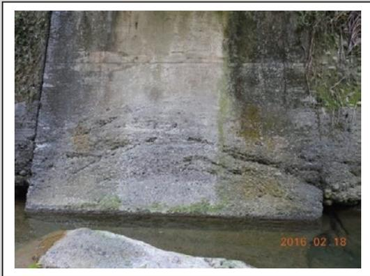
圖8 橋台混凝土磨蝕
