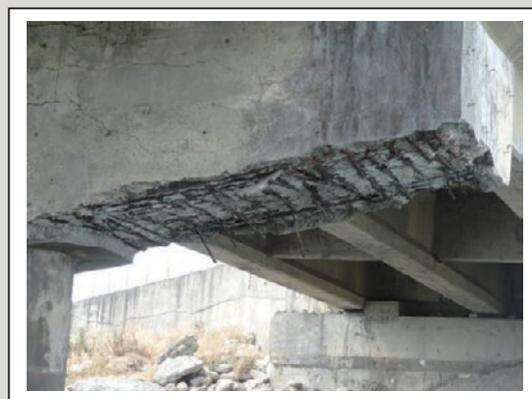
圖20 帽梁底板混凝土整體剝落、鋼筋外露銹蝕，且部分鋼筋斷裂
