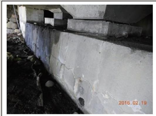
圖4 橋台胸牆塊狀裂縫
