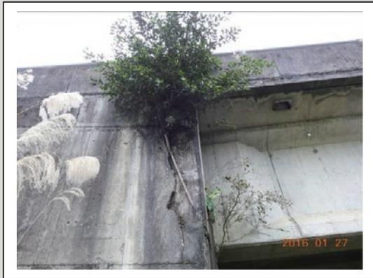
圖16 橋台側牆植物生長、開裂
