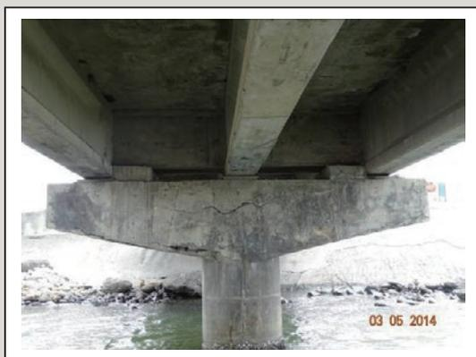
圖17 帽梁混凝土裂縫
