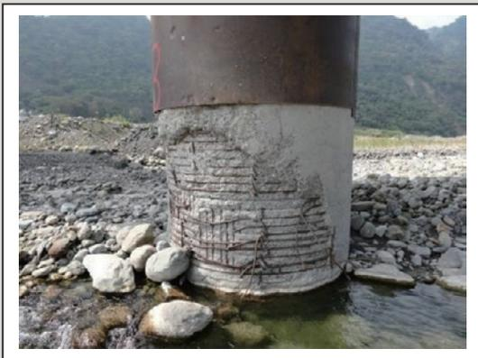
圖22 橋墩墩體混凝土磨蝕，鋼筋外露、變形、斷裂
