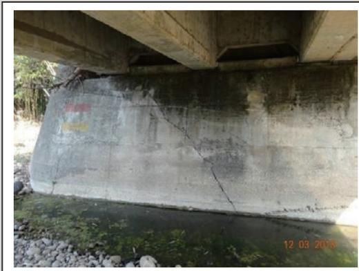
圖2 橋台胸牆斜向開裂
