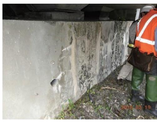
圖11 橋台胸牆混凝土表面具水痕、長青苔、白華痕跡
