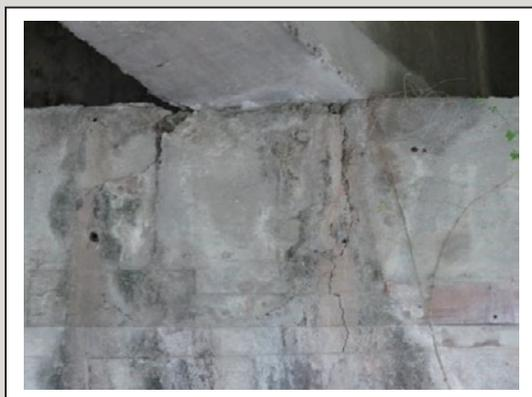
圖18 帽梁支承處混凝土開裂
