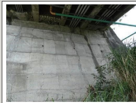
圖3 橋台胸牆垂直裂縫
