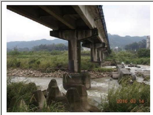
圖35 箱基礎裸露、固床工局部破壞
