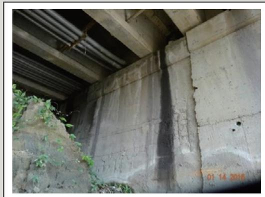
圖5 橋台胸牆混凝土剝落、鋼筋外露銹蝕
