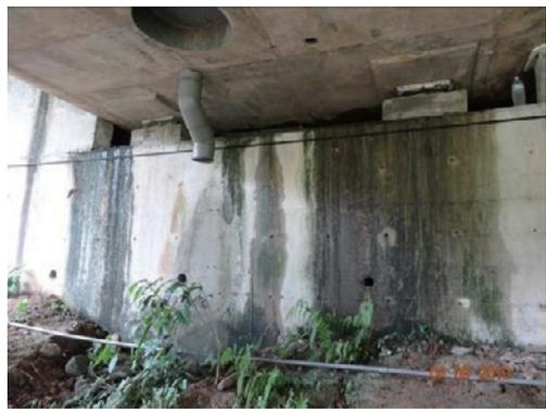
圖10 橋台胸牆混凝土表面具水份入滲、長青苔痕跡
