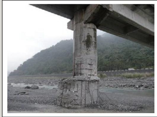
圖25 橋墩混凝土磨蝕、鋼筋外露變形、斷裂
