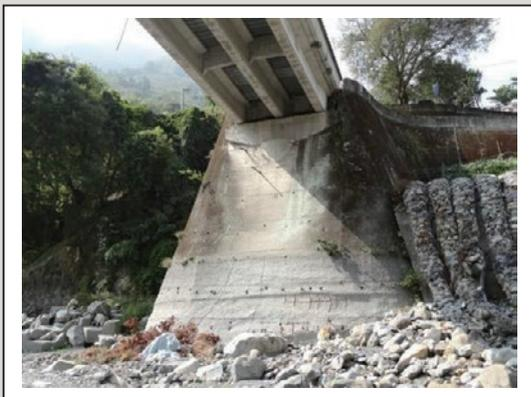
圖9 橋台混凝土磨蝕、鋼筋外露變形
