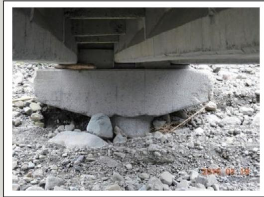
圖24 橋墩墩體及帽梁混凝土磨蝕
