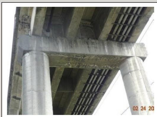
圖27 帽梁底板混凝土白華、鋼筋外露銹蝕
