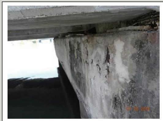
圖21 帽梁混凝土剝離、鋼筋外露銹蝕
