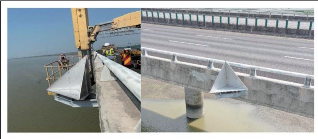
圖16 烏溪1號橋角反射器
