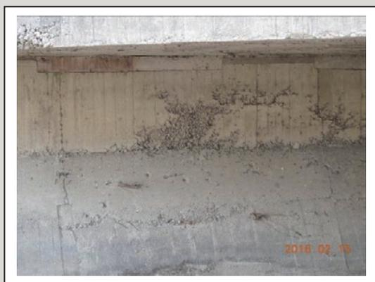
圖12 橋台胸牆混凝土蜂窩
