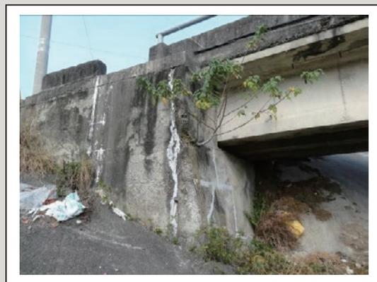
圖15 橋台混凝土蜂窩、裂縫、植物生長
