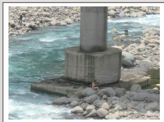
圖39 沉箱基礎保護工鋼筋外露、銹蝕、變形、斷裂
