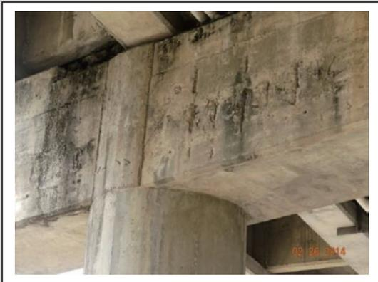
圖23 帽梁混凝土剝落、鋼筋外露銹蝕
