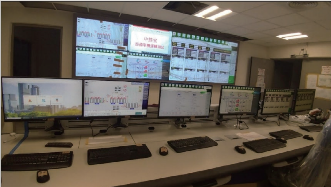
圖23 B1F中央控制室
