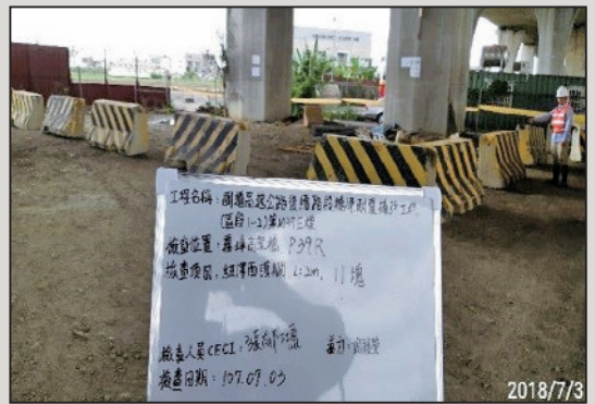
圖18 橋墩基礎周圍使用護欄情形
