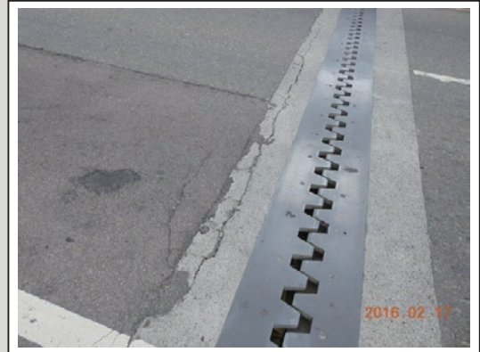
圖6 無收縮混凝土裂縫、破碎(一)
