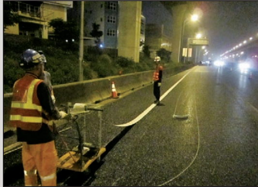
圖6 反光成型標線黏貼施工
