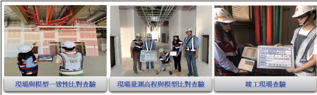
圖14 利用科技產品-平板進行模型現場查驗
