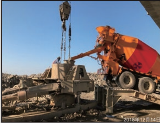
圖15 基樁混凝土澆置
