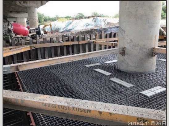
圖16 墩柱基礎SCC澆置
