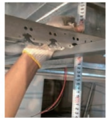
螺桿延伸間距與距離垂直度放樣並採3.2角鐵固定技術施工。
