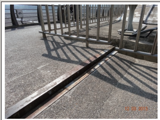
圖14 伸縮縫異常移位及高低差(二)
