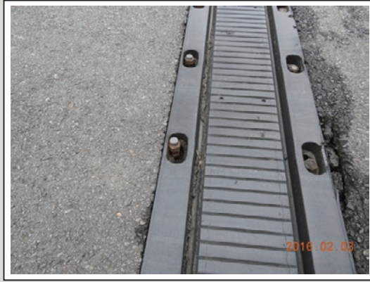
圖3 螺栓銹蝕、鬆動、欠缺(一)
