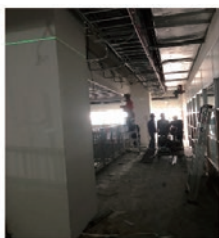
標記各設施高程及C7螺桿間距與距離放樣及標記。
