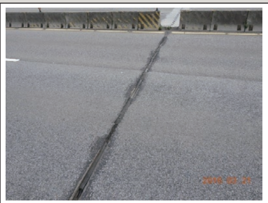
圖10 填縫膠條脫落、局部積土
