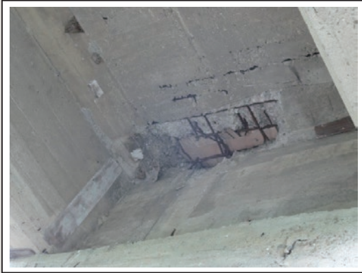
圖17 伸縮縫更換造成橋面版破損、鋼筋外露
