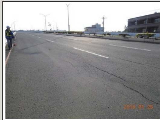
圖25 車道中央車轍、裂縫
