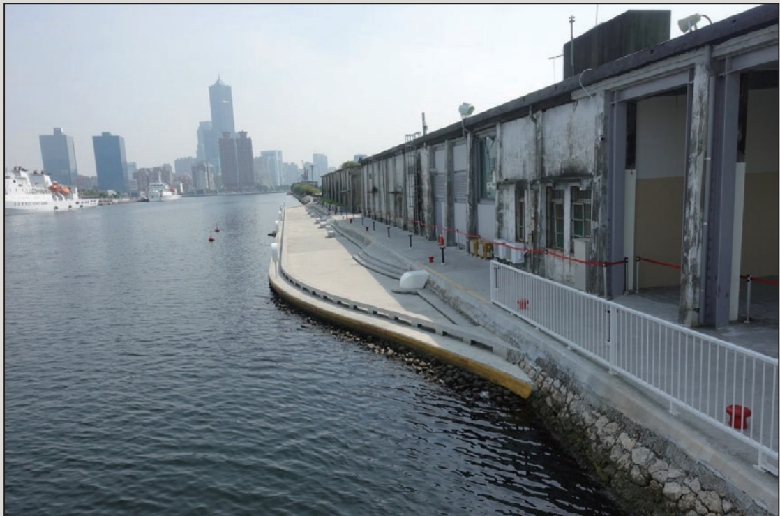
圖24 保留既有咕啞石護岸結合親水平台
