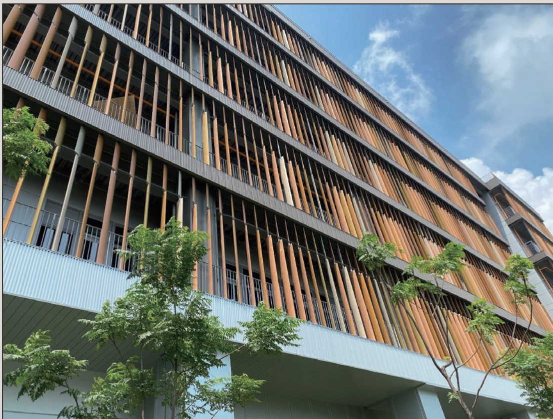
圖 19 外牆塑木格柵完成實景
