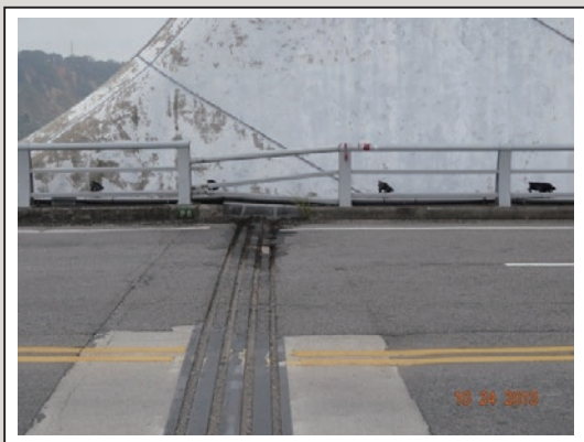
圖13 伸縮縫異常移位及高低差(一)
