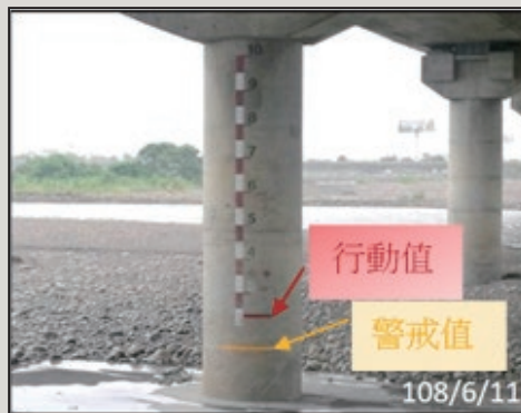
圖22 第三道防線工區水位監測尺
