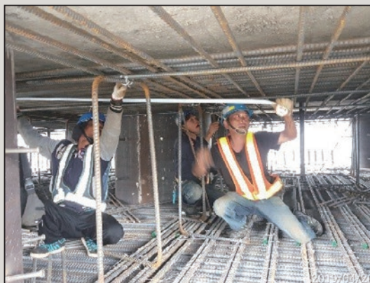
圖28 鋼筋施工現況
