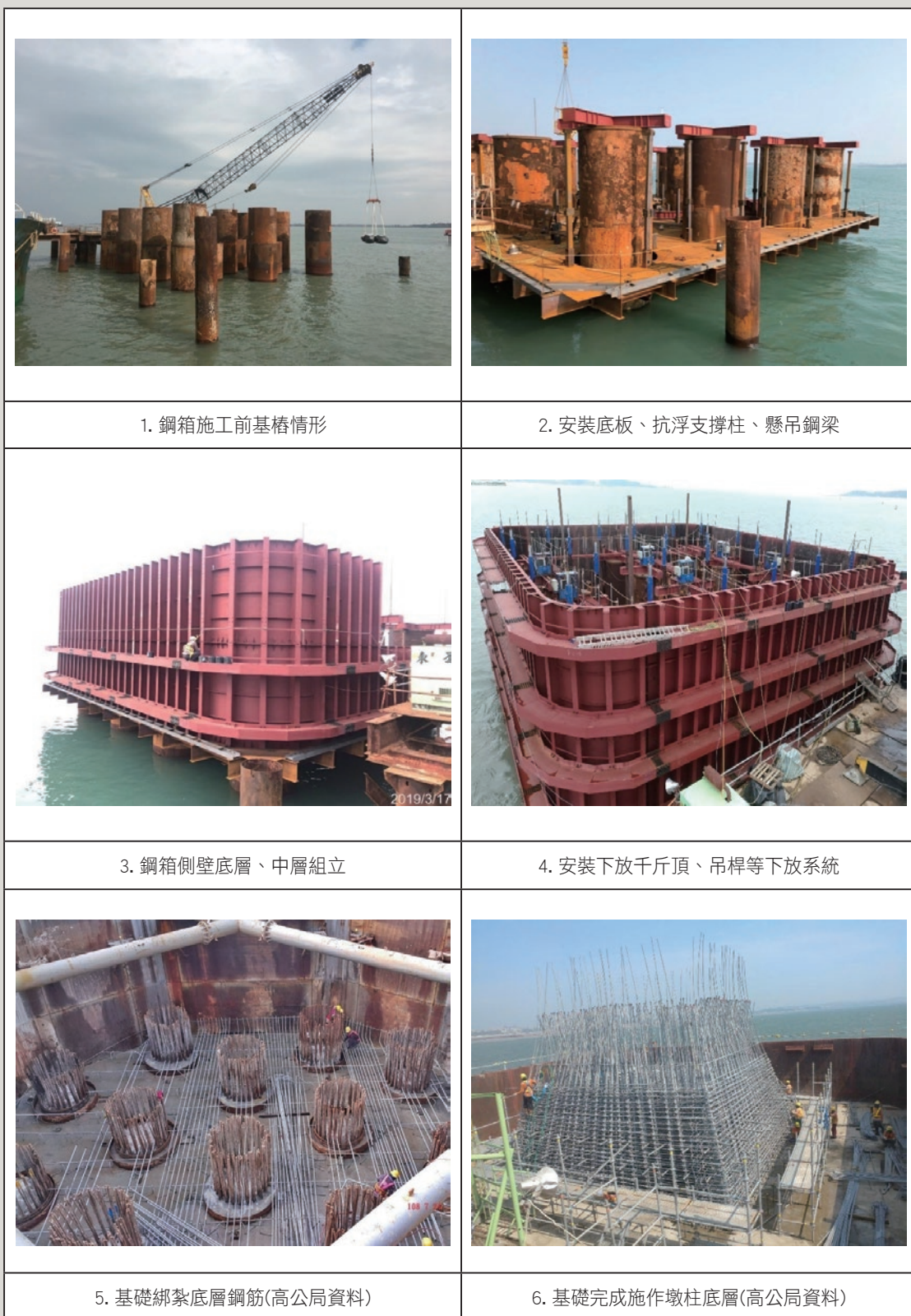
圖8 鋼箱施工照片
