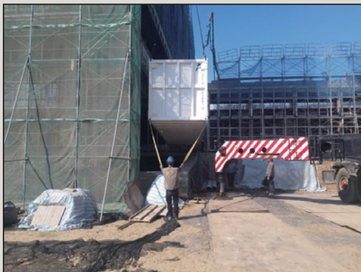
圖 17 全鈦氧化還原液流電池儲能系統由維修孔吊置
