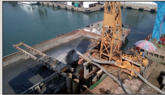
圖8 基樁施工受泥船配合收置棄土、廢水照片
