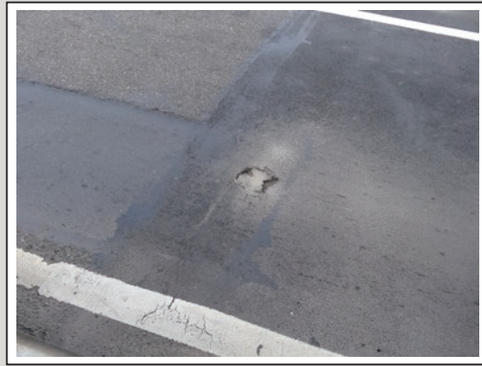
圖24 鋪面坑洞及噴泥現象
