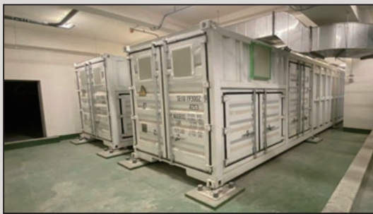
圖 16 全鈦氧化還原液流電池儲能系統
