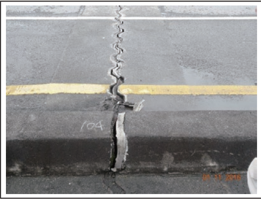
圖8 填縫膠條老化、脫落
