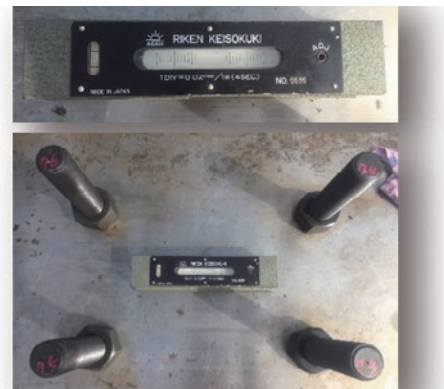
圖11 千分規水平尺控制軸承承座安裝精度
