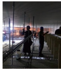
暗架天花FFL高程與螺桿間距與距離垂直度放樣，並實施暗架封板施工及螺桿孔開孔螺桿延伸。
