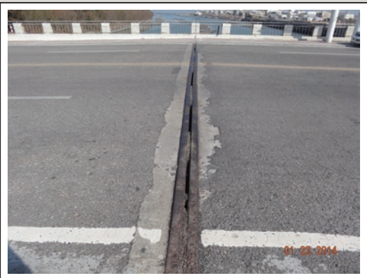
圖9 填縫膠條老化、局部脫落
