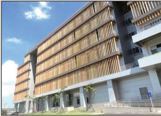
圖7外牆塑木遮陽格柵
