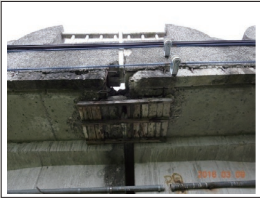
圖16 修復後模板未拆除、局部懸臂板破損
