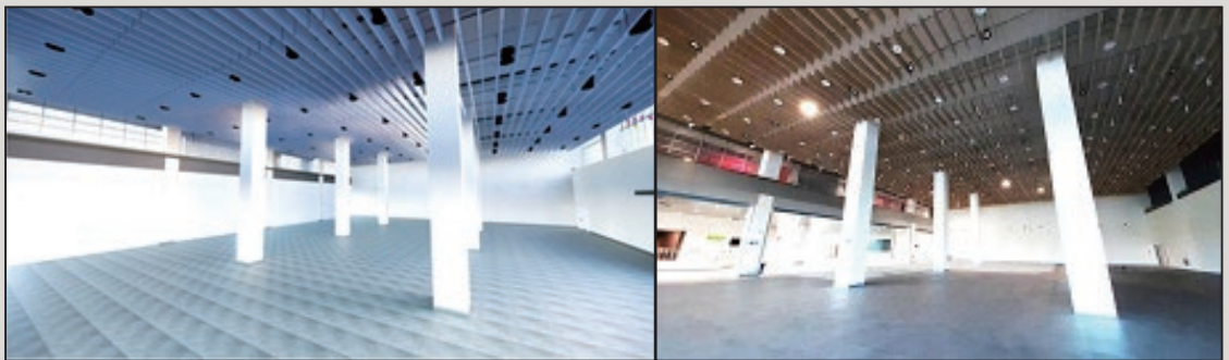
圖21 BIM模型檢討模擬圖及施工完成實景
