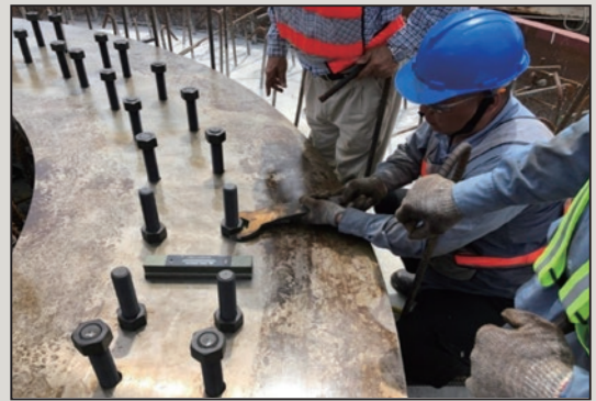
圖10 軸承基座施工照片
