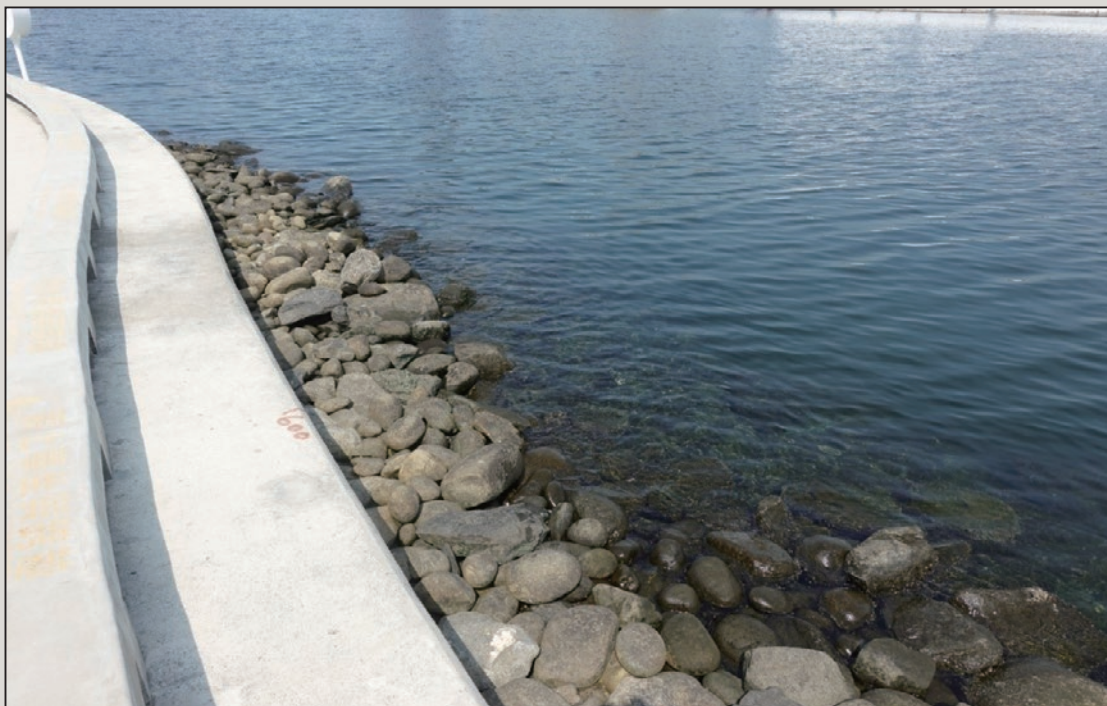
圖25 景觀護岸平台採用多孔隙之塊石施工
