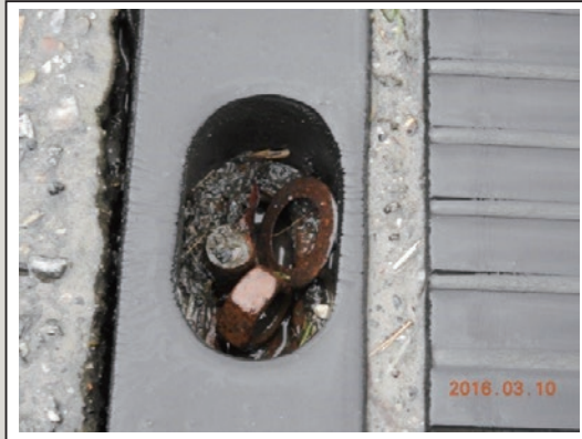
圖4 螺栓銹蝕、鬆動、欠缺(二)
