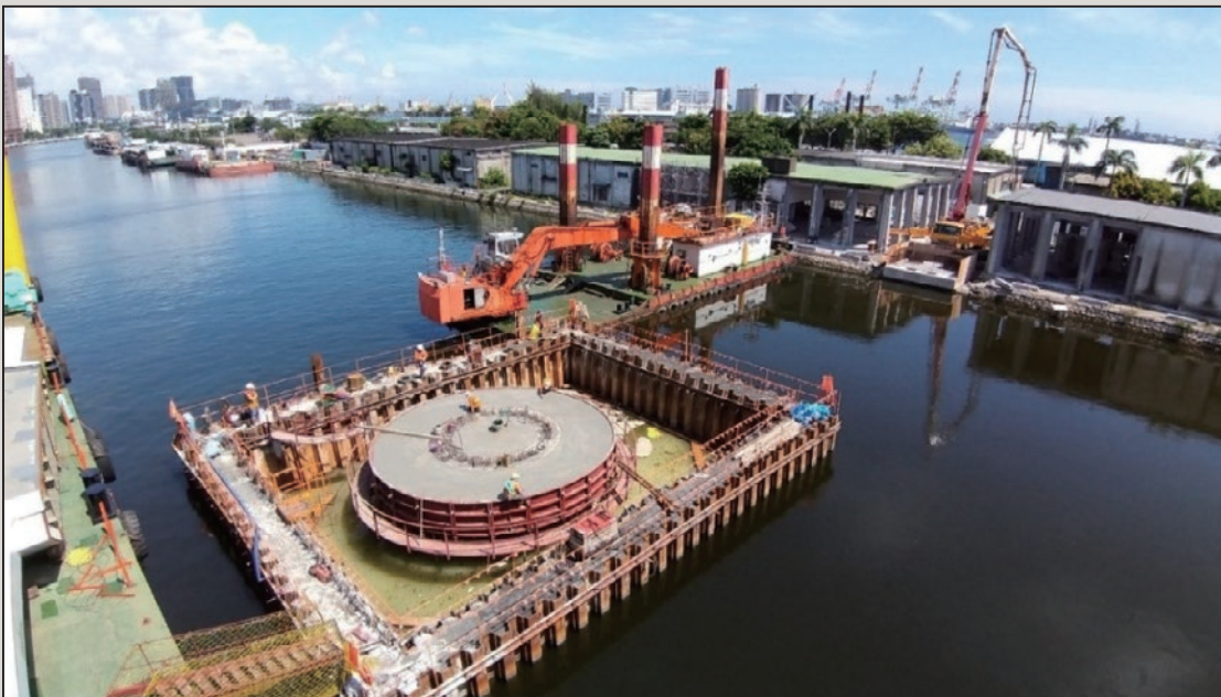
圖12 P2橋墩帽梁澆置完成照片
