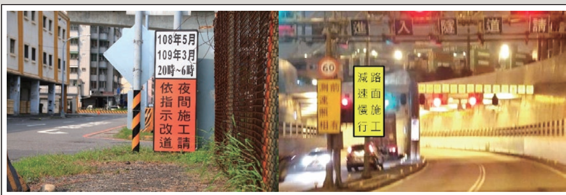
圖15 重要路口機動增設警示牌面
