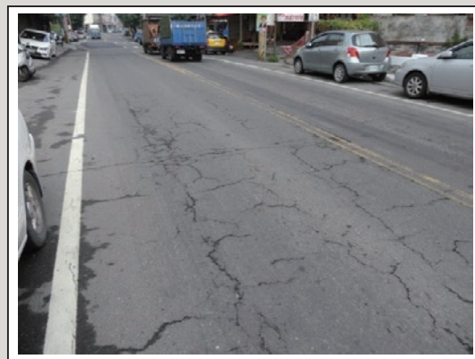
圖20 鋪面網狀裂縫(一)
