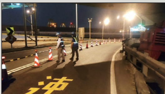
圖25 每日監造單位檢查交維設施
