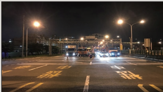
圖23 交維改道時保全人員管制隧道兩端
