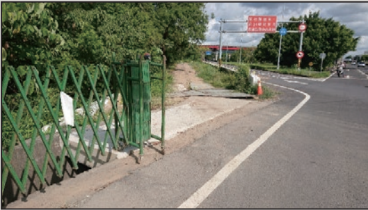
圖37 P107施工便道入口實景圖
