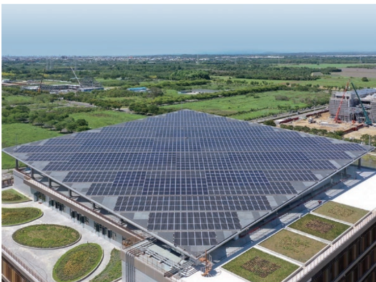
圖3 太陽能板屋頂
