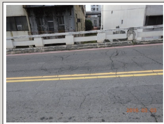
圖22 鋪面網狀裂縫(二)
