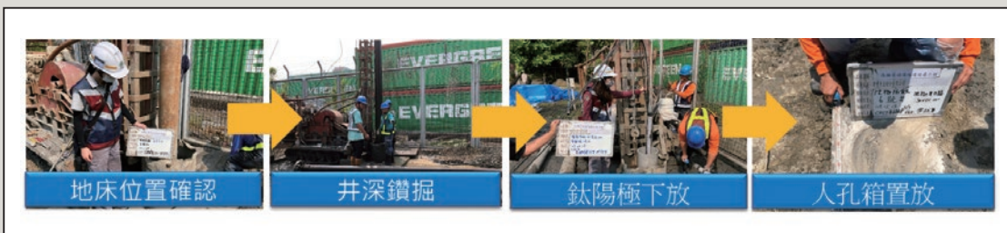
圖14 陰極防蝕系統建置
