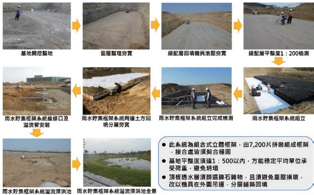
圖25 水撲滿(雨水貯集框架系統)施工流程
