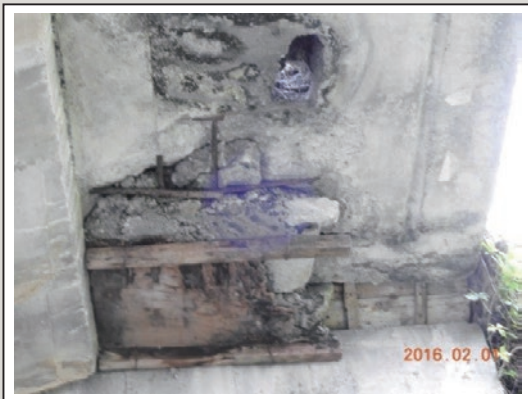
圖18 修復後模板未拆除、局部懸臂板破損
