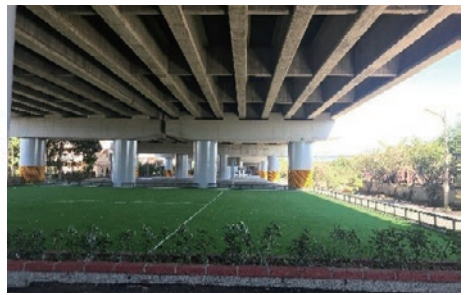
圖5 墩柱鋼板包覆、帽梁施工前、後
