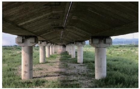
圖5 墩柱鋼板包覆、帽梁施工前、後
