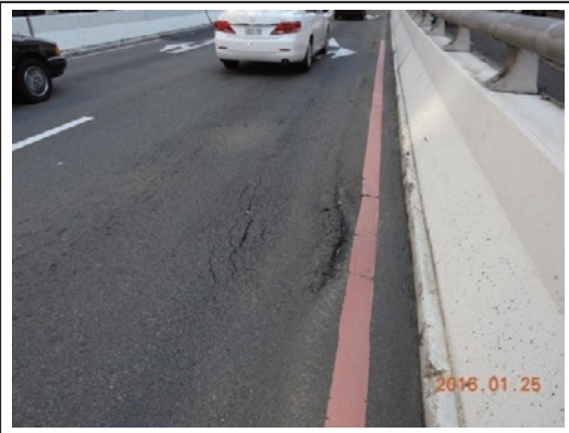
圖26 靠近護欄處鋪面車轍、凹陷
