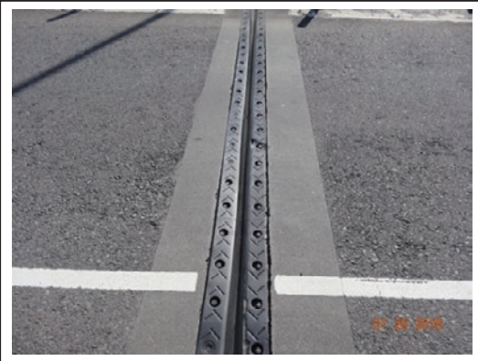
圖5 橡膠伸縮縫螺栓孔蓋套脫落
