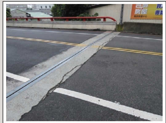
圖7 無收縮混凝土裂縫、破碎(二)
