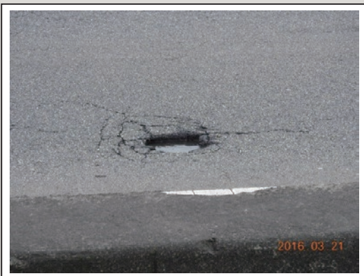
圖23 鋪面破碎、坑洞及積水
