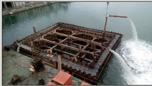
圖9 圍堰完成架設照片
