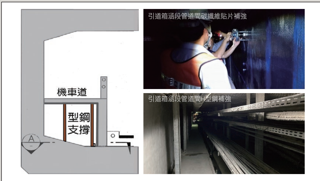
圖8 引道箱涵段管道間補強示意圖
