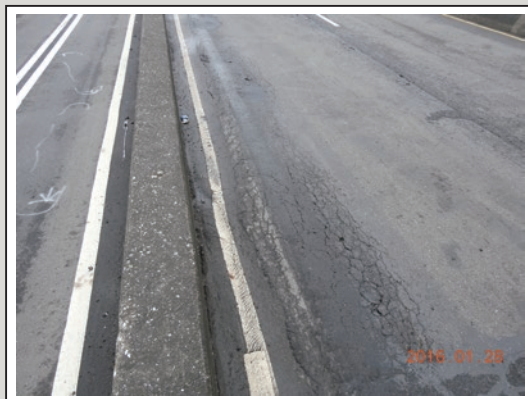
圖28 鋪面車轍與碎裂
