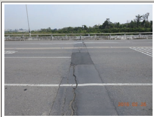
圖21 鋪面橫向開裂
