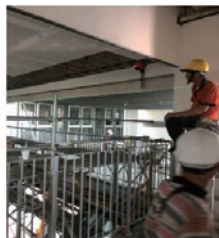
C7螺桿間距與距離垂直度放樣及橫向縱向標記。
