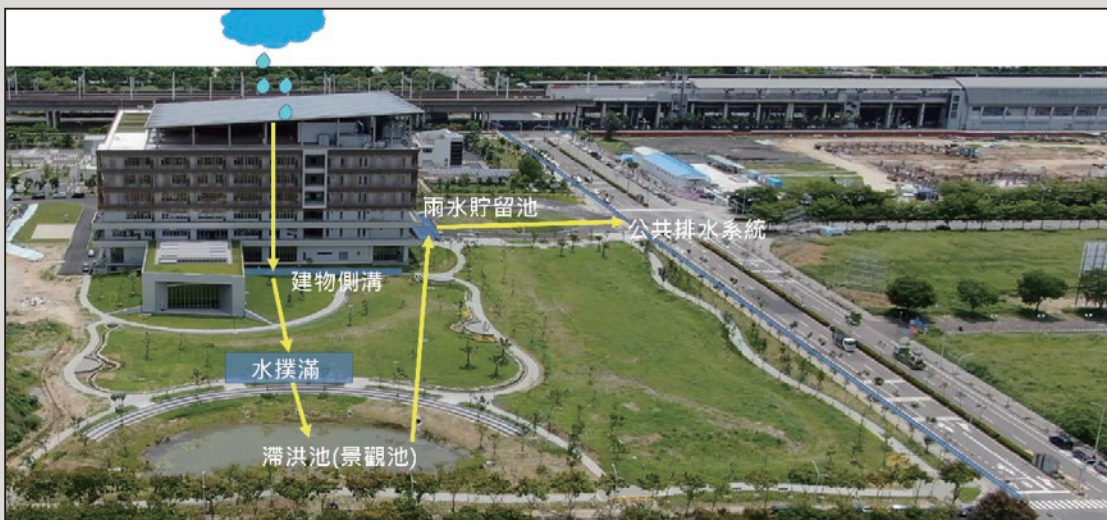
圖24 雨水貯留再利用系統
