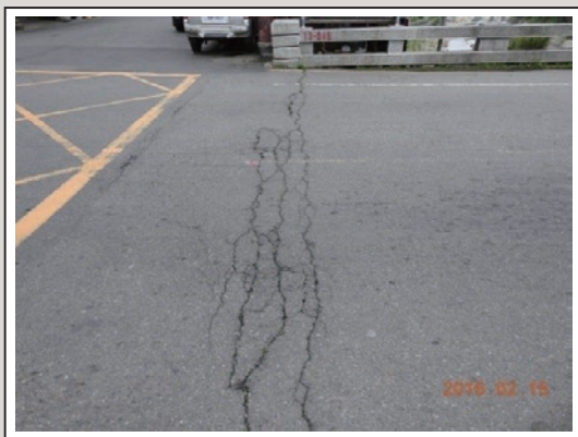
圖19 鋪面橫向裂縫
