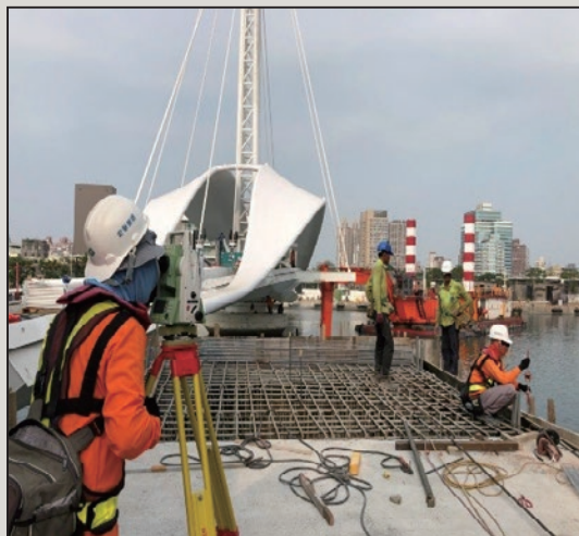
圖14 橋台施工
