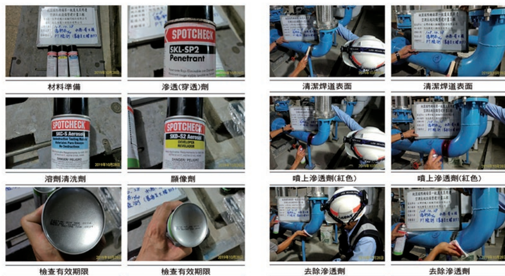
圖8 抽檢進行PT焊道染色滲透檢驗，確保管路焊道品質
