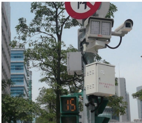
圖9 現場設備保護管線實際安裝圖
