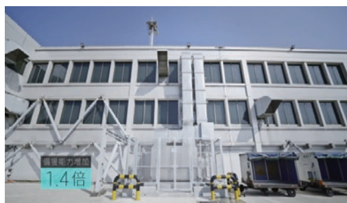
增設戶外空調箱及保護設施
