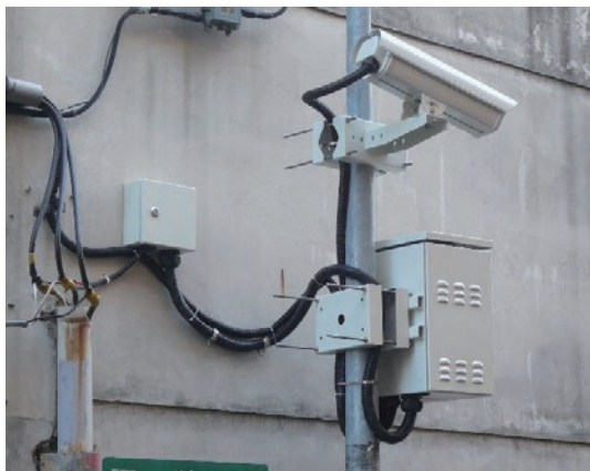
圖9 現場設備保護管線實際安裝圖
