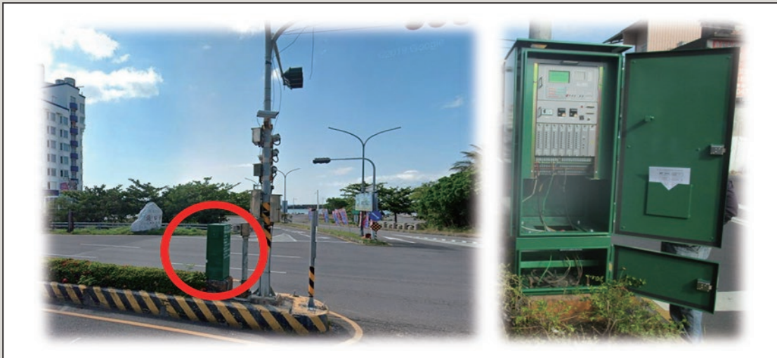
圖10 號誌控制器設備安裝圖
