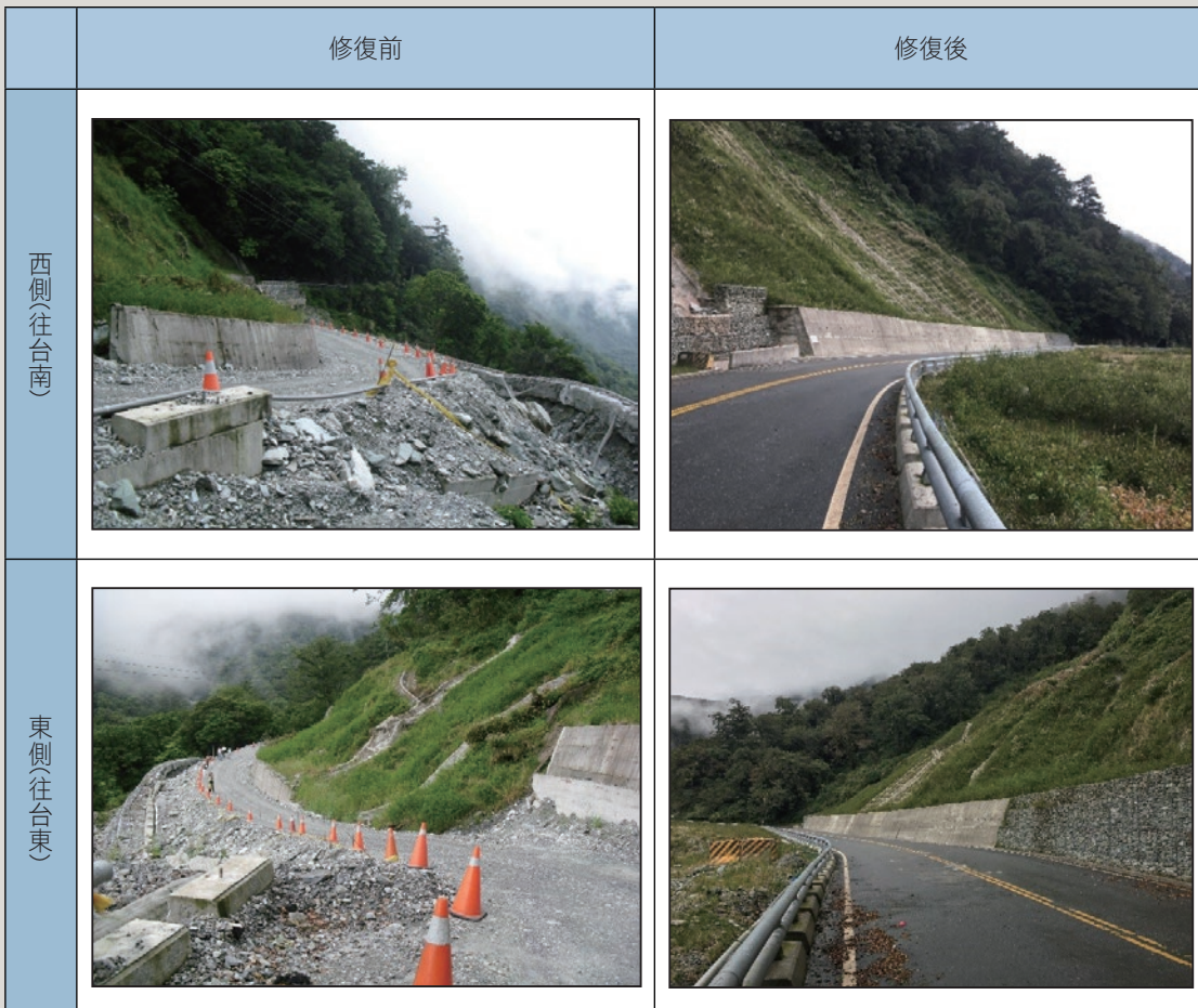
圖15 台20線157k+600路工災害整治前後現況圖
