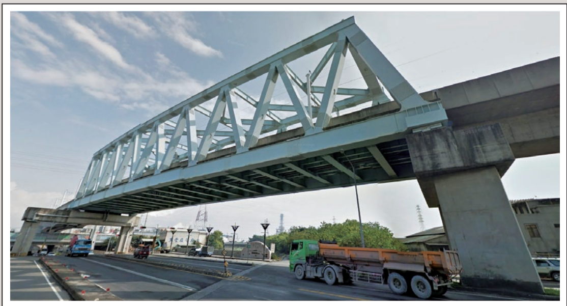
圖6 鋼桁架簡支梁橋
