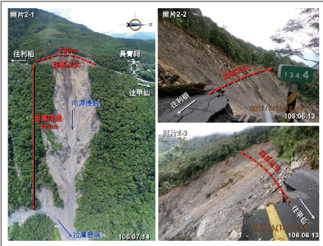
圖4 台20線134.2K邊坡災損空拍圖
