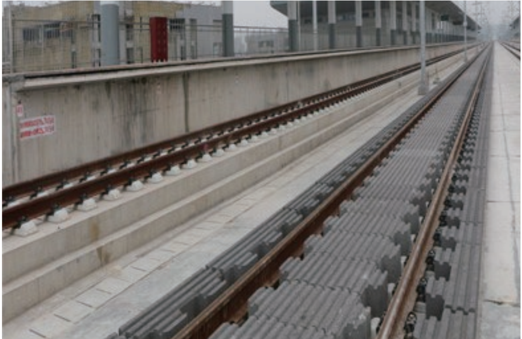
圖30 鐵路高架橋於軌道區裝設吸音材案例
