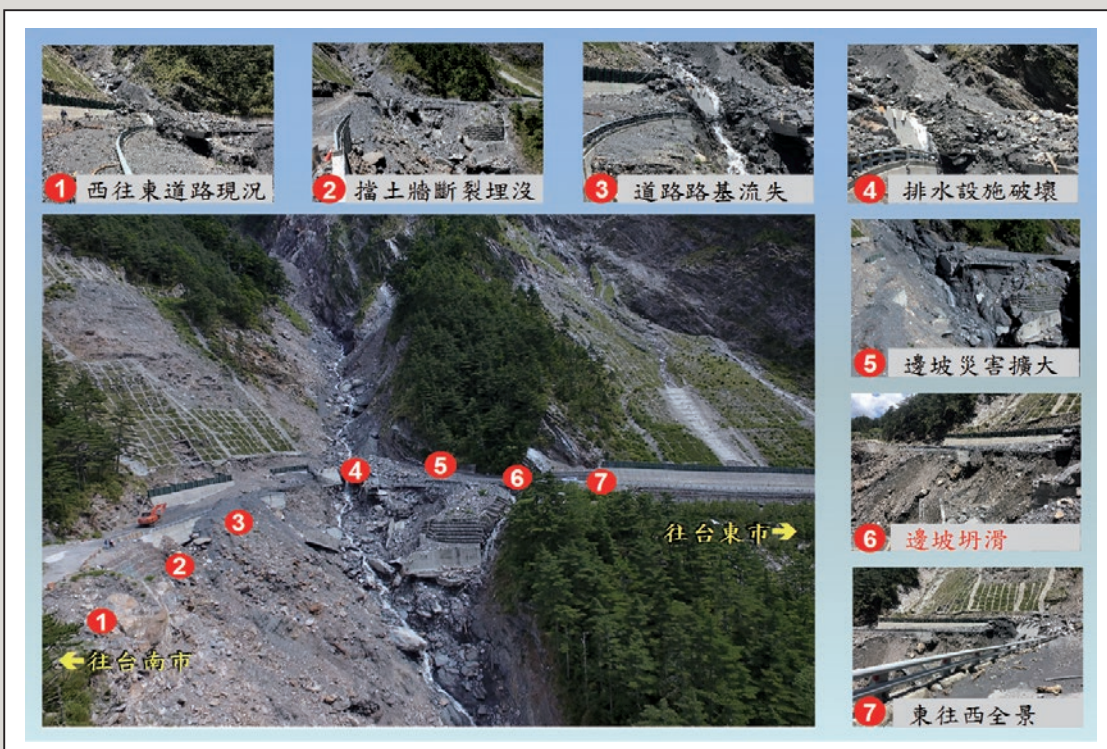
圖19 台20線147K+800工區現況圖
