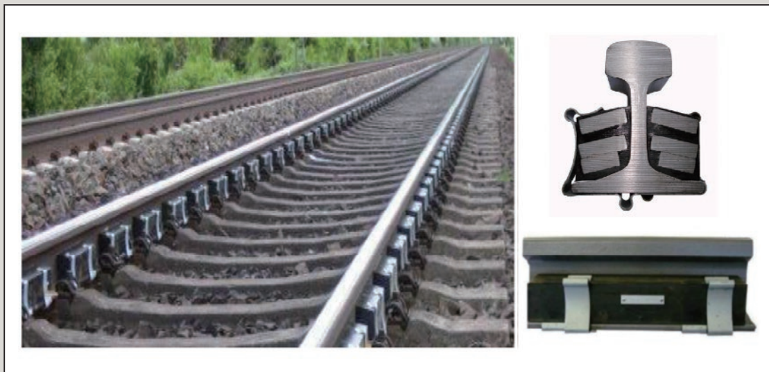
圖29 軌道區鋪設鋼軌減振材案例
