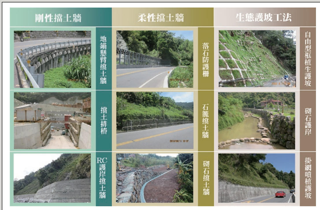
圖8 邊坡修復工程可採取之相關設施
