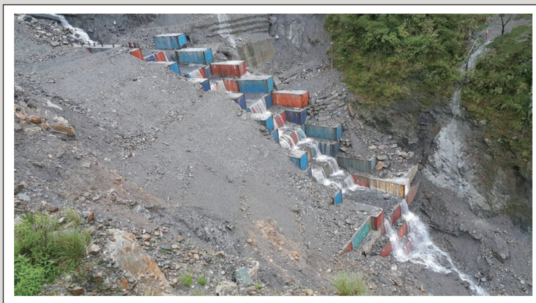
圖23 台20線143K+800復建工程現況圖
