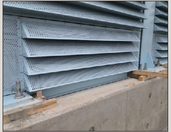
圖26 倒N型吸音板裝設完成案例
