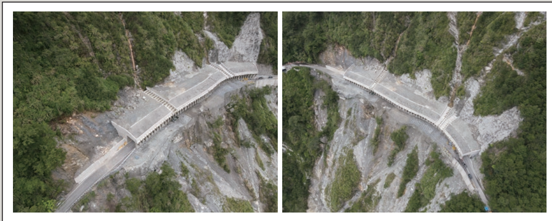
圖18 施工中之明隧道現況圖
