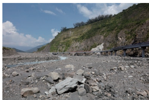
由下游往上游觀查明霸克露橋
