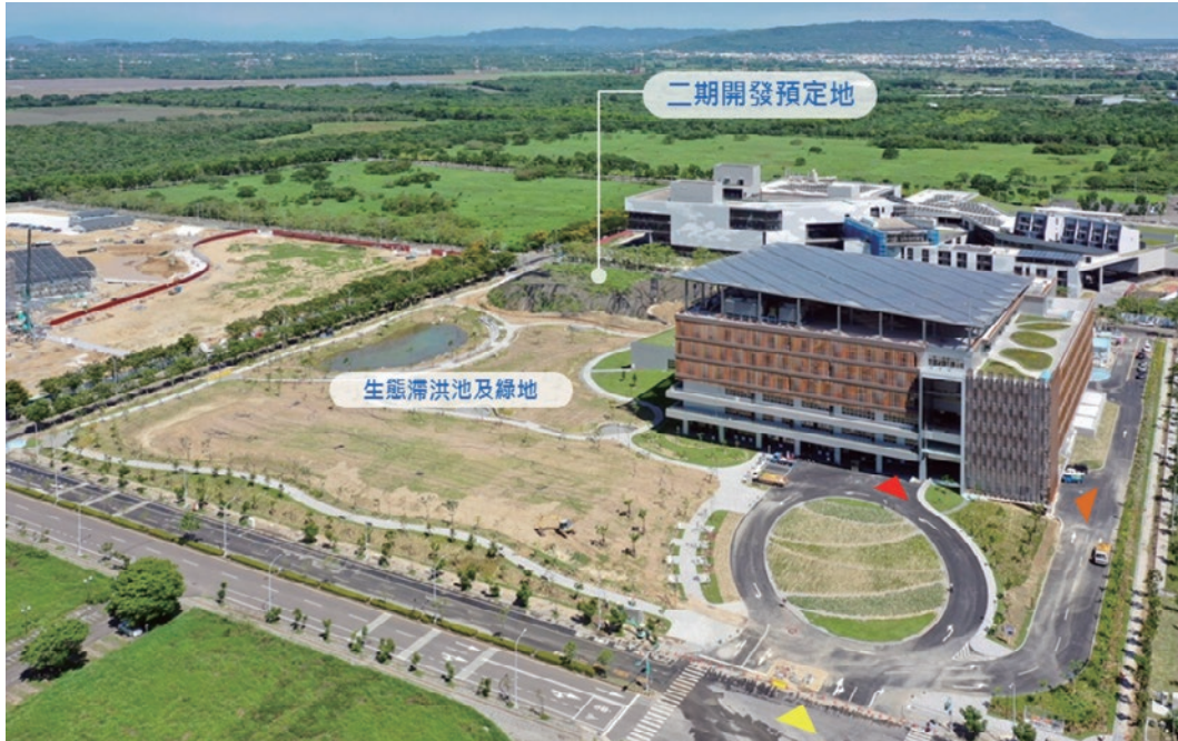
▲ 園區主入口 ▲ 建築主入口 ▲ 地下室停車入口
