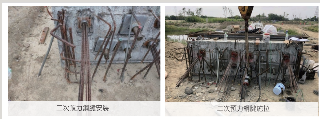
圖18 二次預力鋼腱的安裝及施拉
