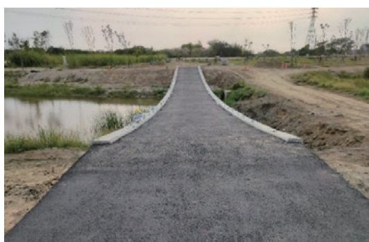
瀝青混凝土鋪設施工
