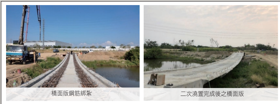
圖17 橋面板二次施工
