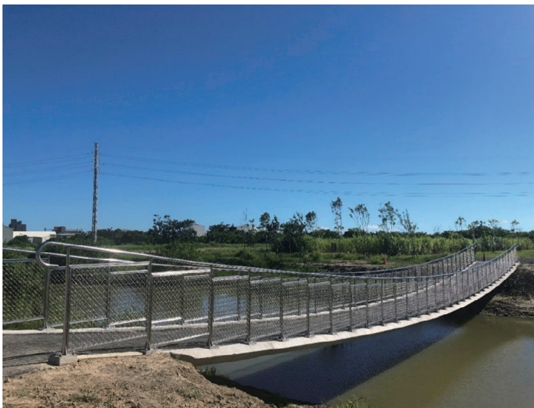
圖12 直路式預力吊床版橋完工照片
