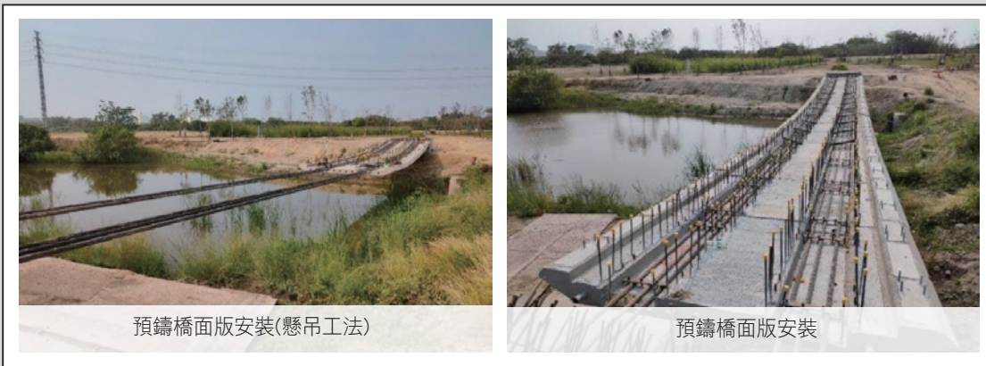
圖16 橋面板懸吊工法施築
