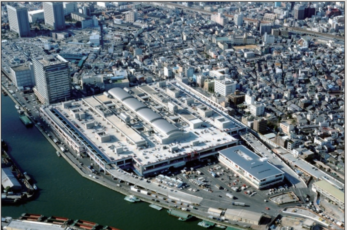
圖5 大阪中央批發市場完工照片(圖片由安井建築師事務所提供)
