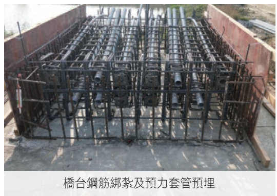
圖13 吊床版橋之橋台施工
