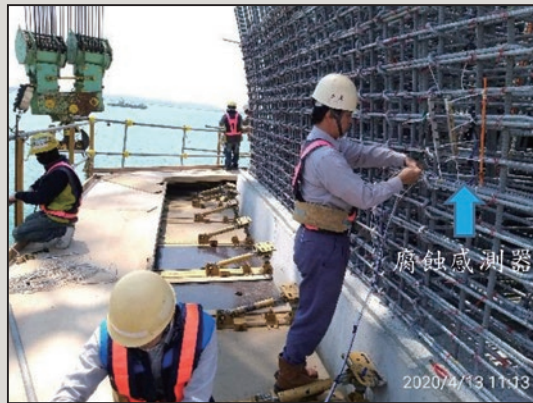
圖9 鋼筋腐蝕感測器埋設
