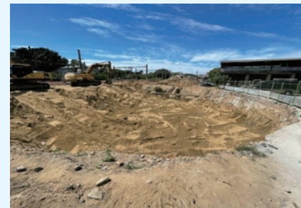
(8)北轉車台遺構移置完成
