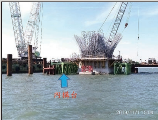
圖5 樁帽頂部內構台設置
