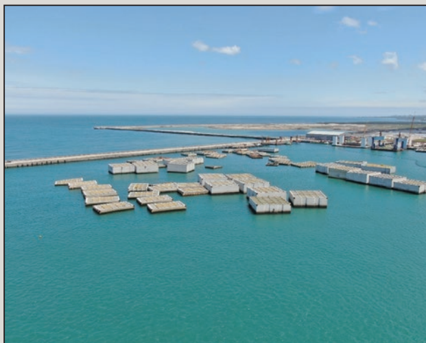
圖12 臺北港北外堤沉箱儲存區
