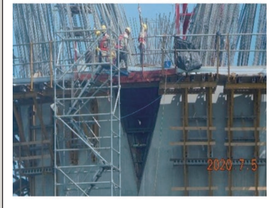
圖24 墩柱搭配鋼模造型位置
