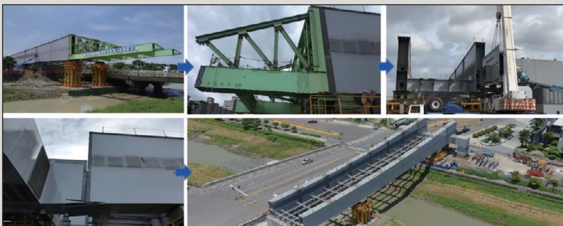
圖7 頂昇滑移現場施工情形
