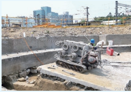
(5)外牆及軌道平臺切割
