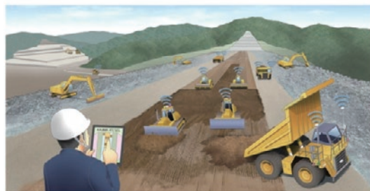
圖2 A^4CSEL®のダム堤体での施工イメージ
