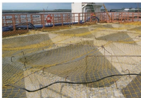
模具拆除完成並加設防墜網蓋板
