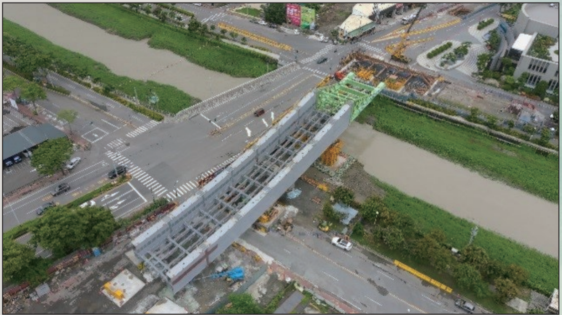
圖13 空拍攝影定期紀錄施工歷程
