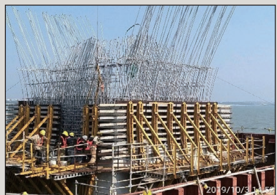
圖12 EFCO系統模板現場組立
