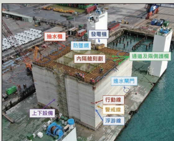
圖11 沉箱出塢前安全衛生設施
