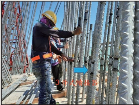
圖6 墩柱主筋3件式續接器對鎖施工
