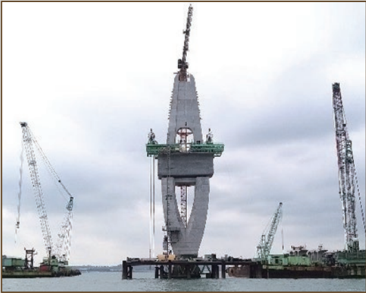
圖26 橋塔完成情形
