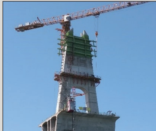
圖 16 橋塔鋼模組裝情形
