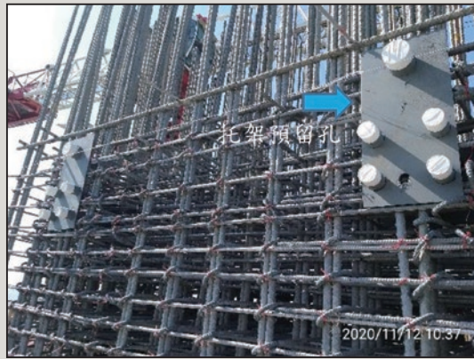
圖8 柱頭節塊施工托架預留孔埋設
