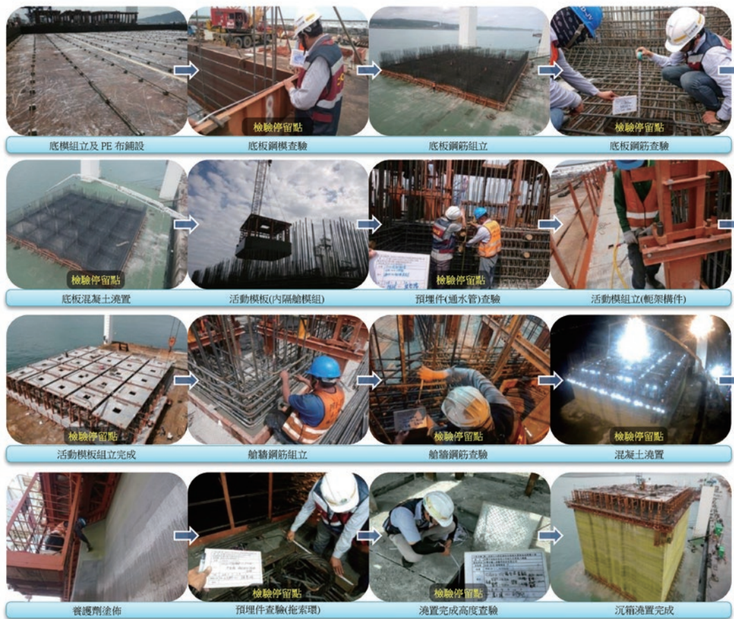
圖6 沉箱製作流程
