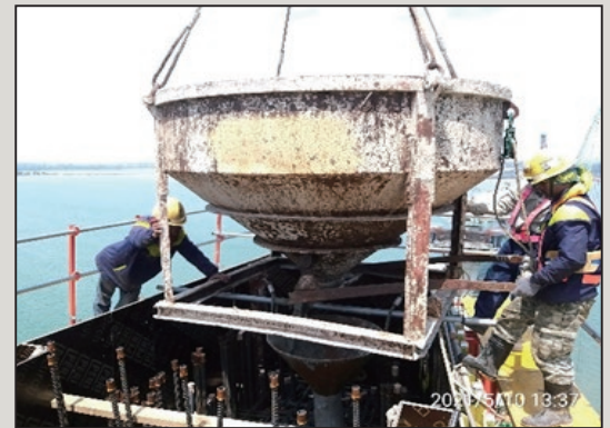
圖19 橋塔昇層混凝土澆置
