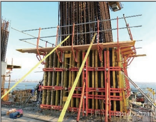
圖 14 橋塔PERI系統模板組裝情形
