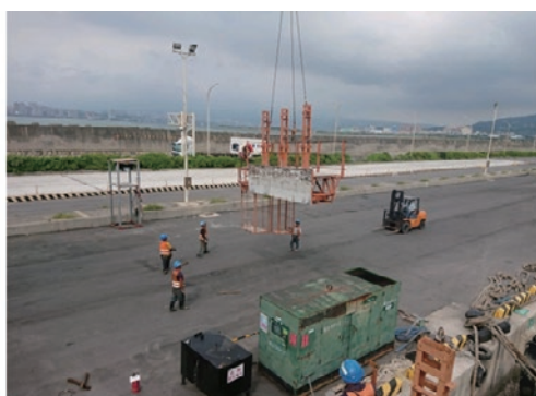
外箱樑鋼模拆除
