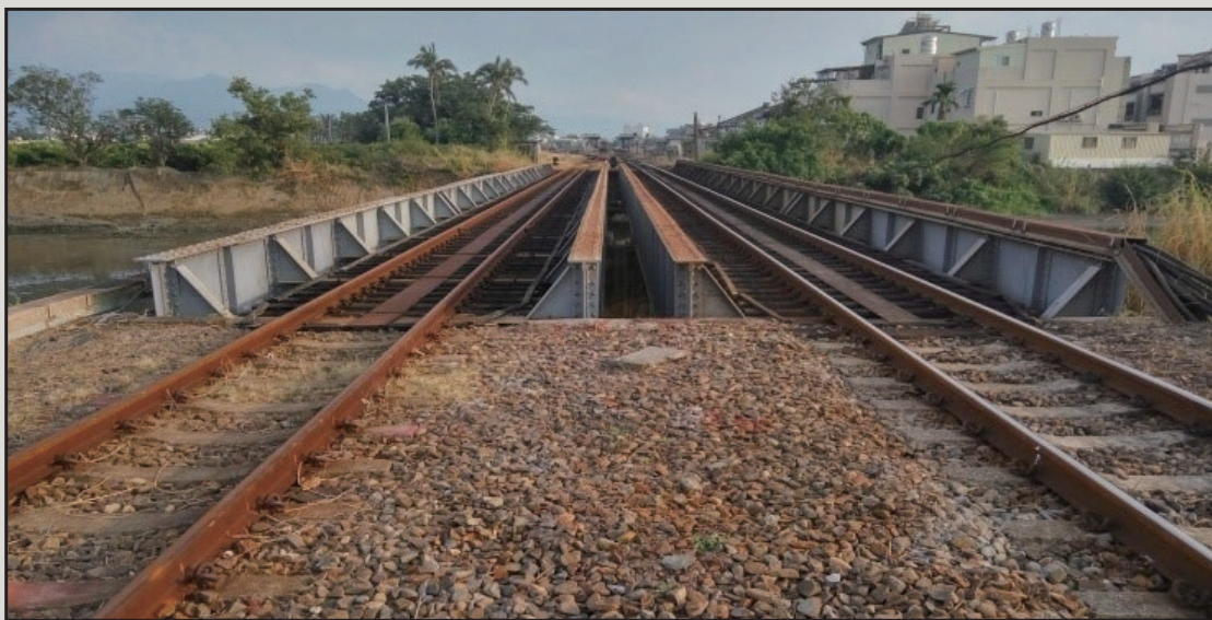
圖1 北勢溪舊鋼橋(下路式鋼板梁橋)
