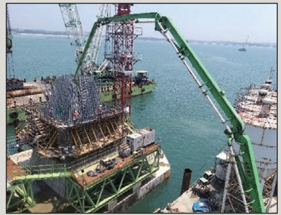
圖18 墩柱昇層拌和船澆置
