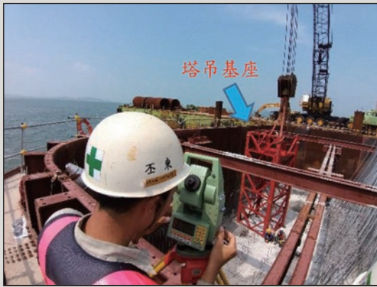
圖4 樁帽基礎預埋塔吊基座
