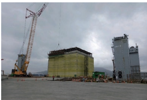
內隔艙鋼模拆除
