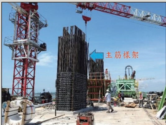
圖7 橋塔鋼筋施工
