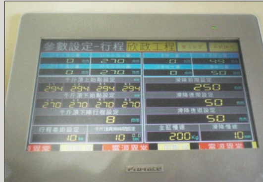
圖11 同步千斤頂電腦控制設備
