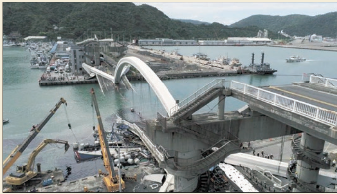
南方澳大橋斷裂情形 (一)
