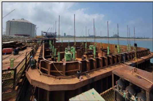
圖18 本工程樁帽圍堰施工照片
