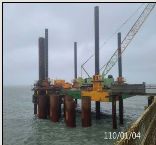
圖 16 本工程外套鋼管及全套管基樁施工照片
