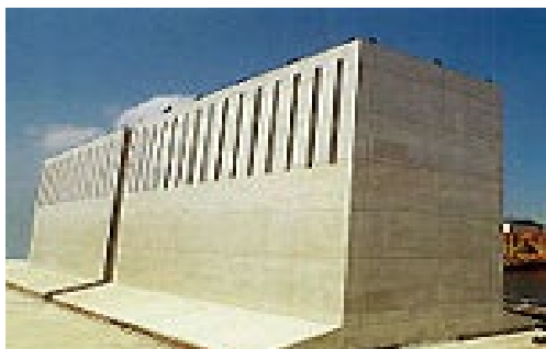
註：橫濱市港灣局南本牧埋立工事
