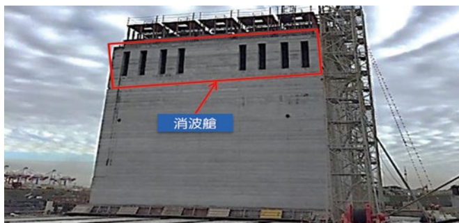
圖4 高雄港洲際貨櫃中心第二期消波沉箱構造案例
