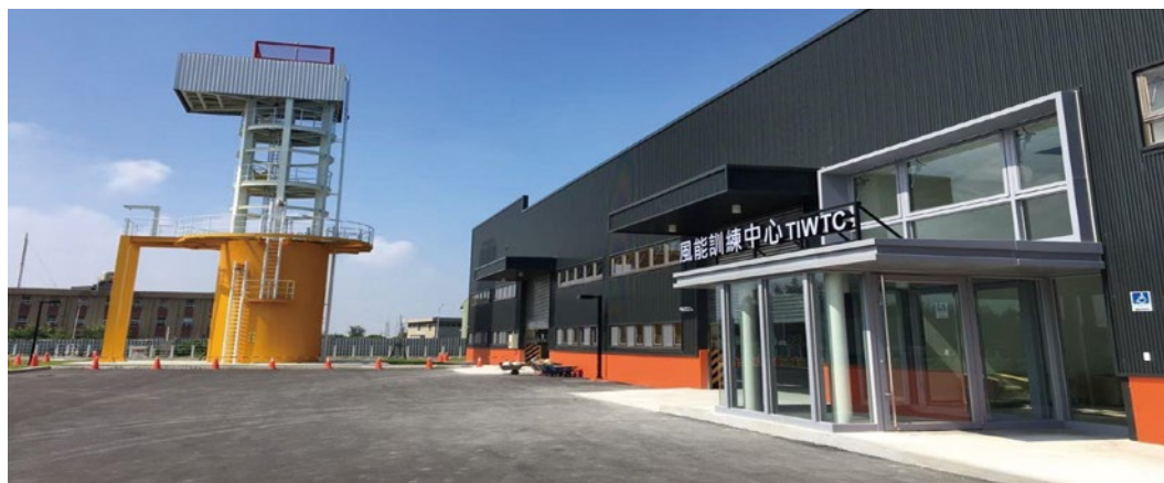
圖12 臺中港風能訓練中心
