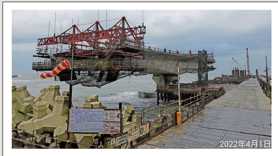
圖21 本案懸臂工法施工照片
