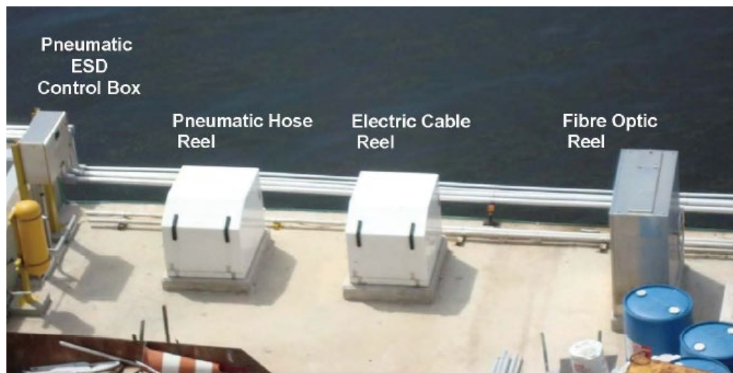
圖15 SSL系統(光纖聯結、電聯結與氣動聯結系統)硬體設備示意圖
