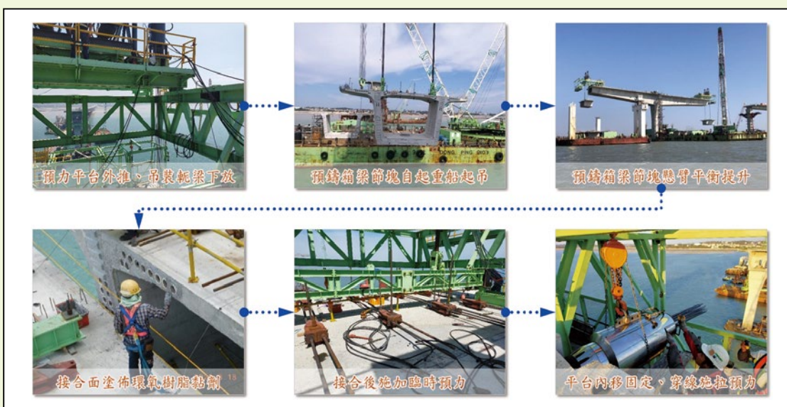
圖28 預鑄節塊懸臂吊裝施工循環
