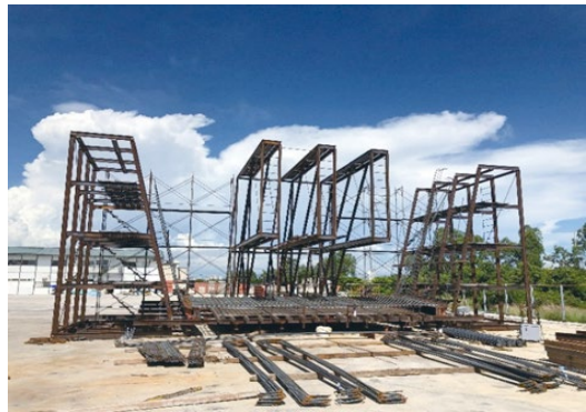
圖14 模組化模板及鋼筋樣架
