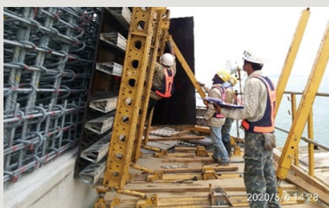
圖47 系統模板工作平台
