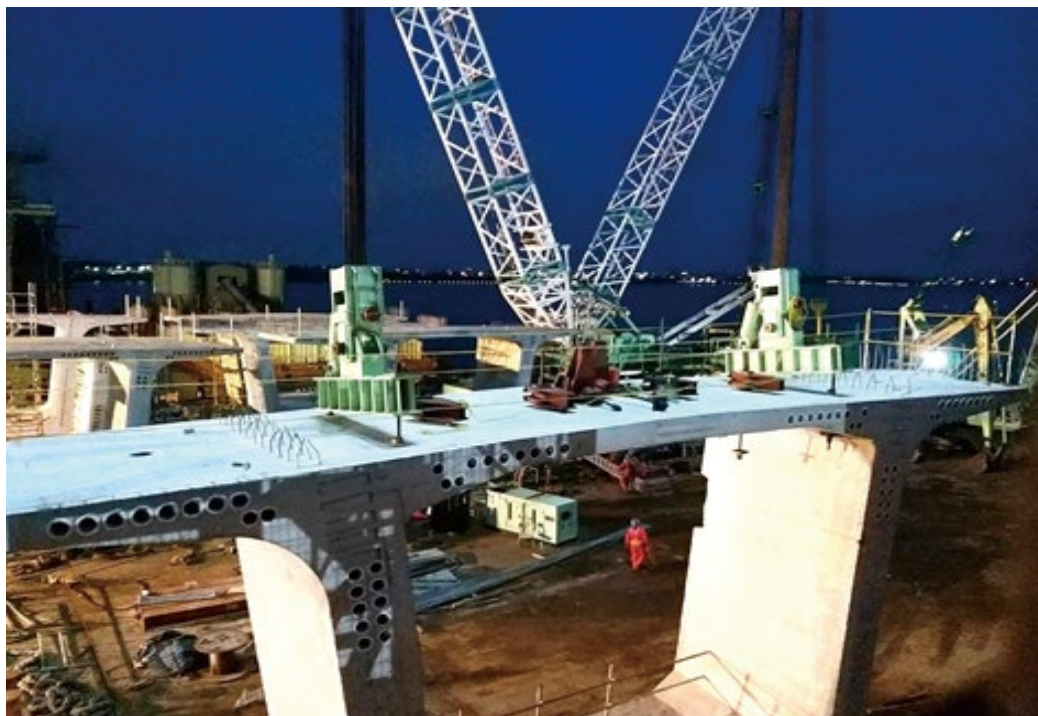
圖24 裝設吊具及鋼靴
