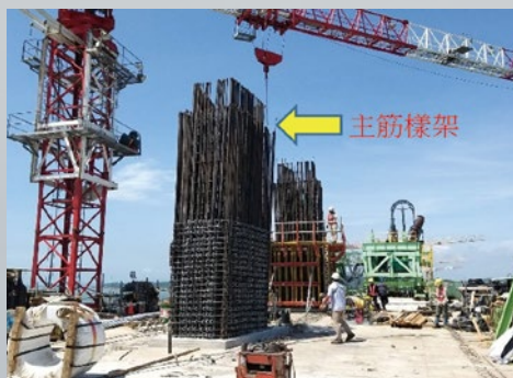
圖38 橋塔鋼筋施工
