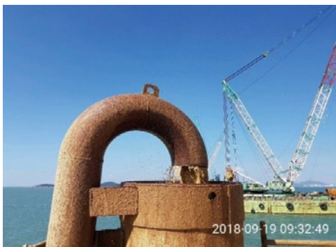
圖8 基樁出渣水色黃濁(高度及完全風化岩盤)
