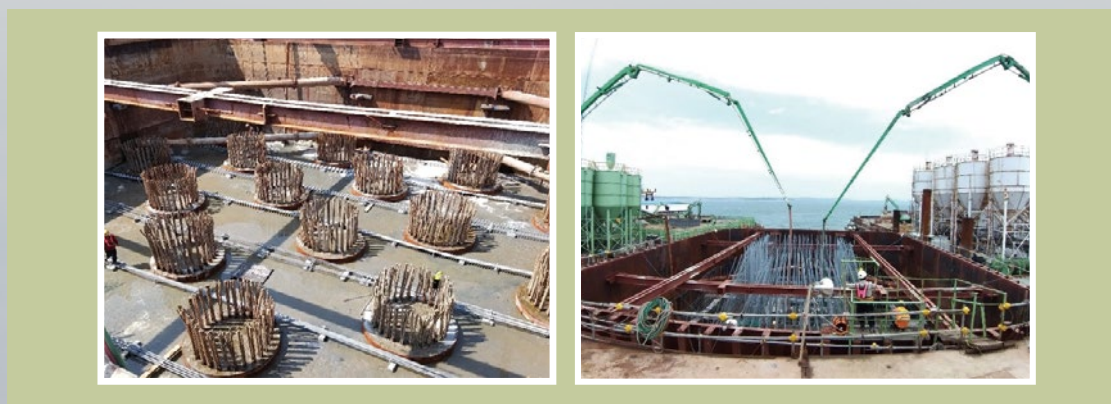
圖23 樁頭處理及樁帽混凝土澆置
