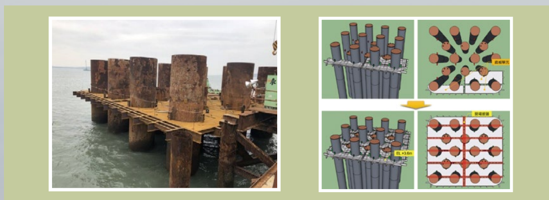
圖15 鋼箱底板施工
