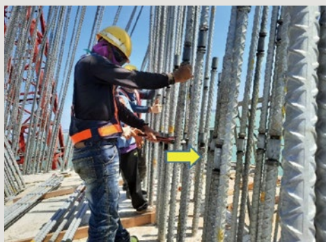
圖37 主筋3件式續接器對鎖施工
