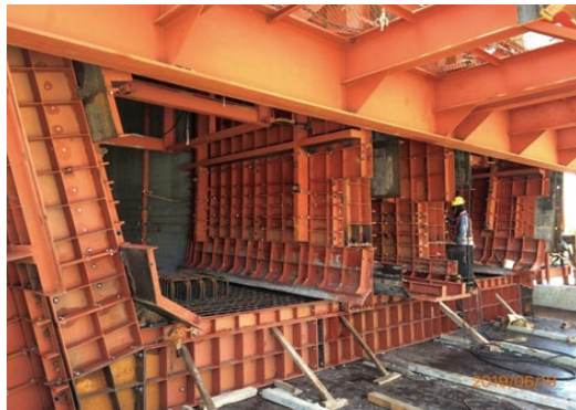
圖14 模組化模板及鋼筋樣架
