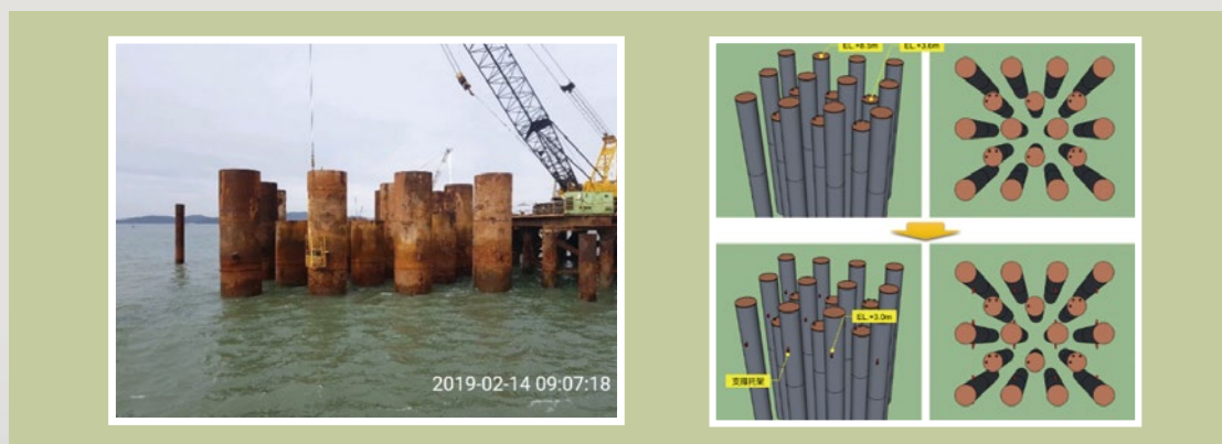
圖14 基樁外套鋼管加高作業
