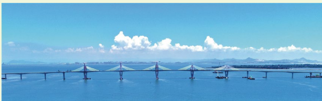
圖43 主、邊橋完成照片
