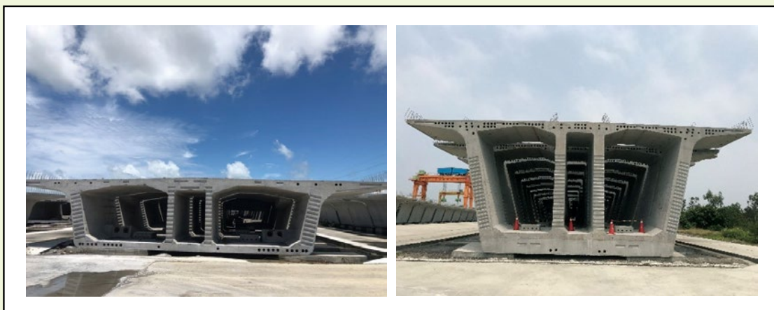
圖8 主橋單元斷面變化照片
