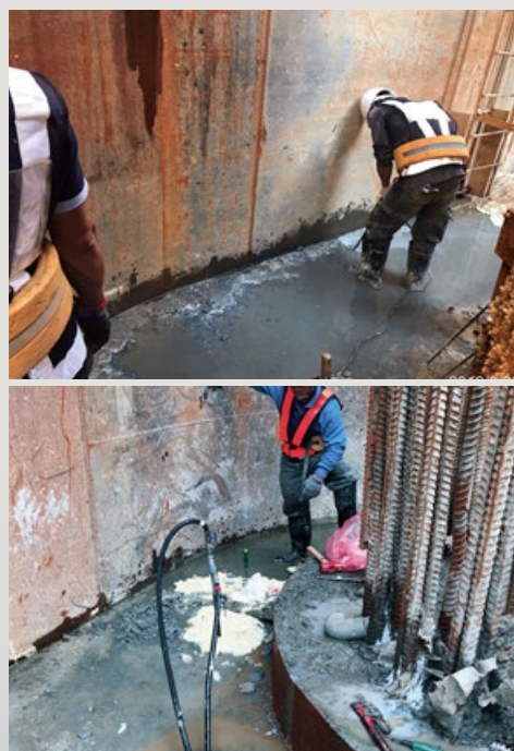
圖30 止漏灌漿情形
