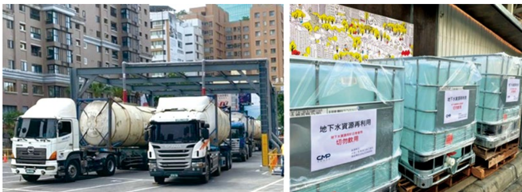
圖12 工地設置給水站及取水口供台積電及民眾取用
