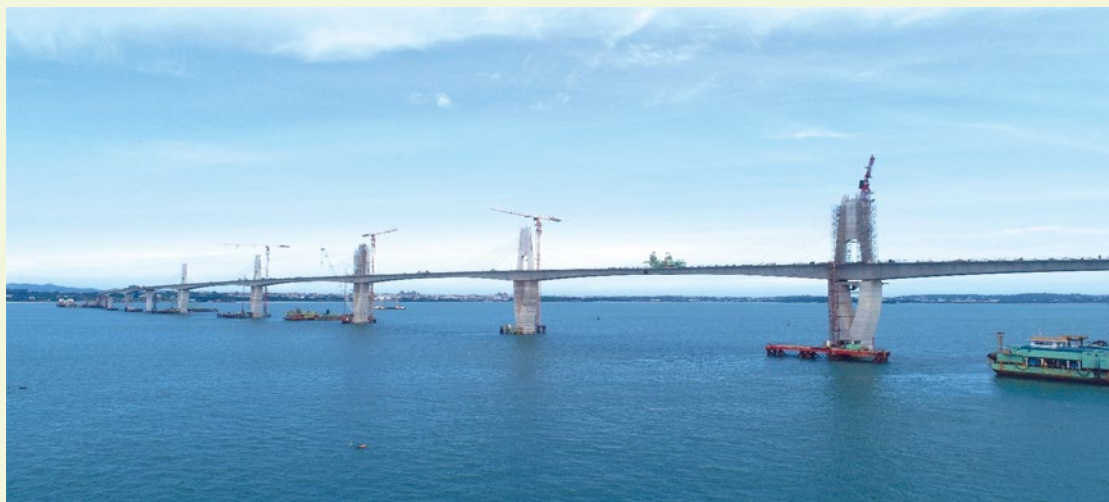
圖42 主橋段單元節塊吊裝完成情形
