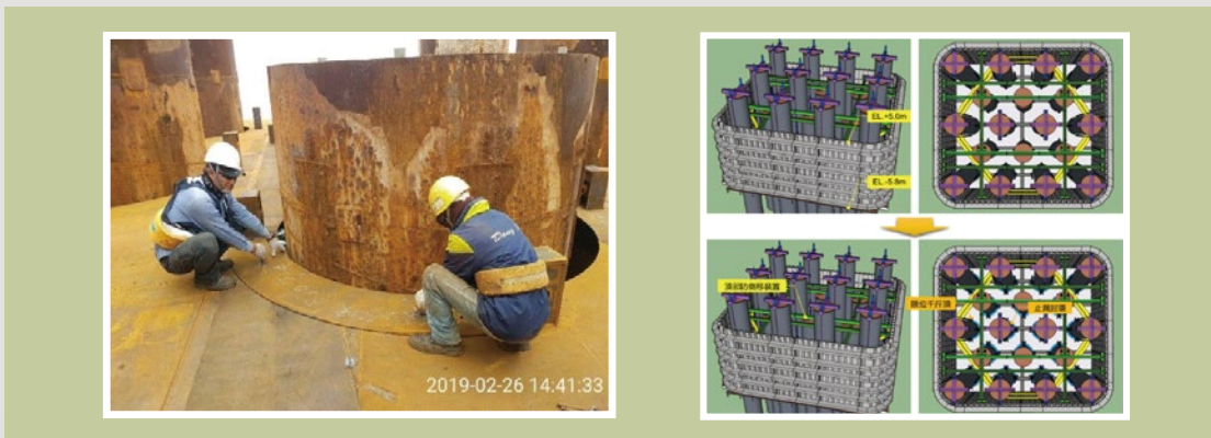
圖20 止漏封板預組及第二次下放鋼箱
