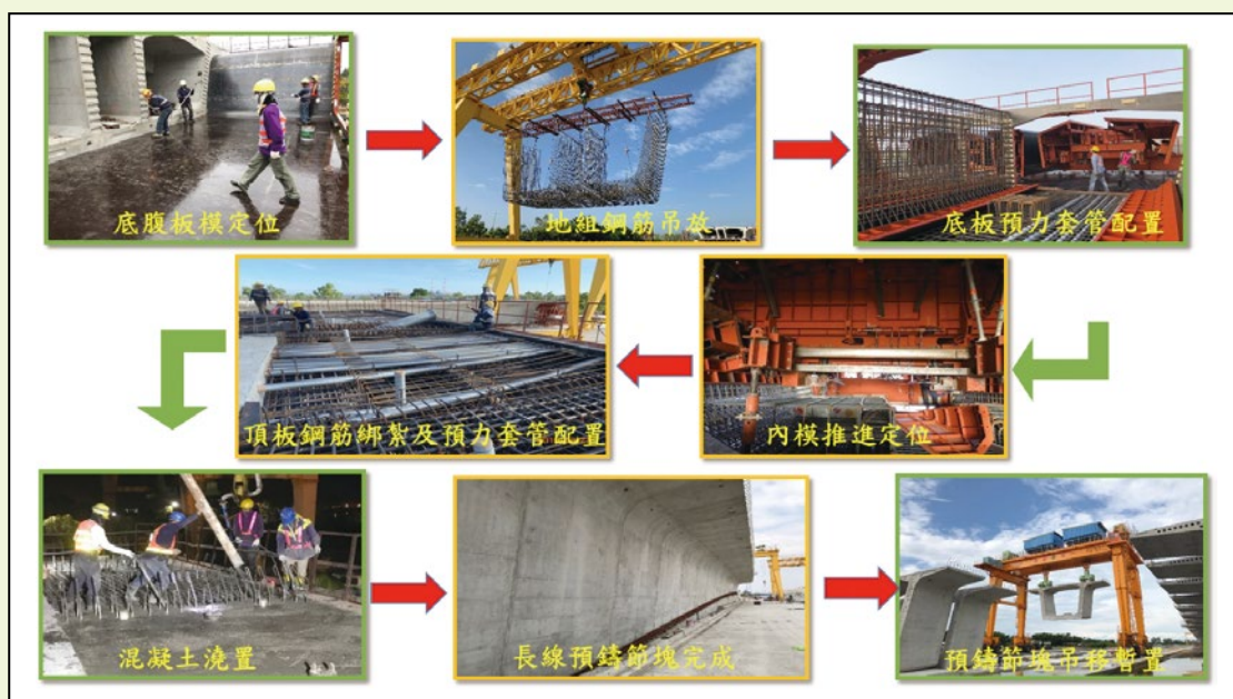
圖12 節塊產製流程
