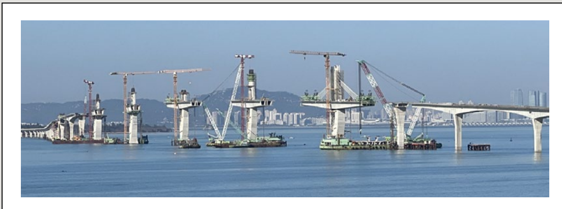
圖25 主橋橋塔塔吊設備
