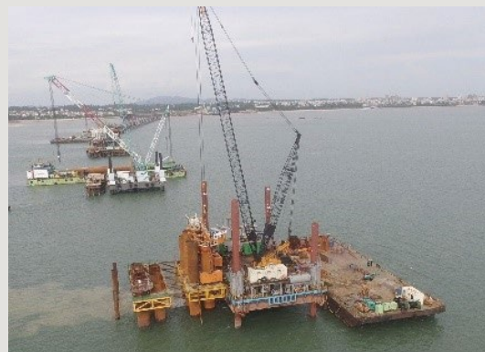
圖6 頂昇式平台船基樁鑽掘
