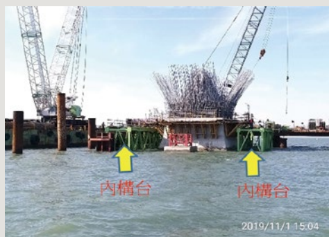
圖36 樁帽頂部內構台設置
