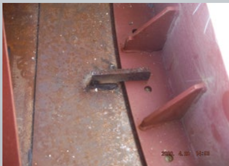
圖29 底板與側板增設角鋼及填縫膠、於鋼箱外側加設擋板
