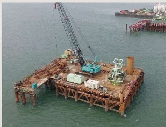
圖5 海上構台基樁鑽掘
