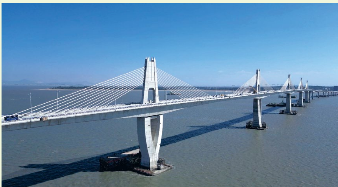
圖3 主橋單元完成照片
