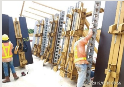
圖40 EFCO系統模板陸域端地組圖
