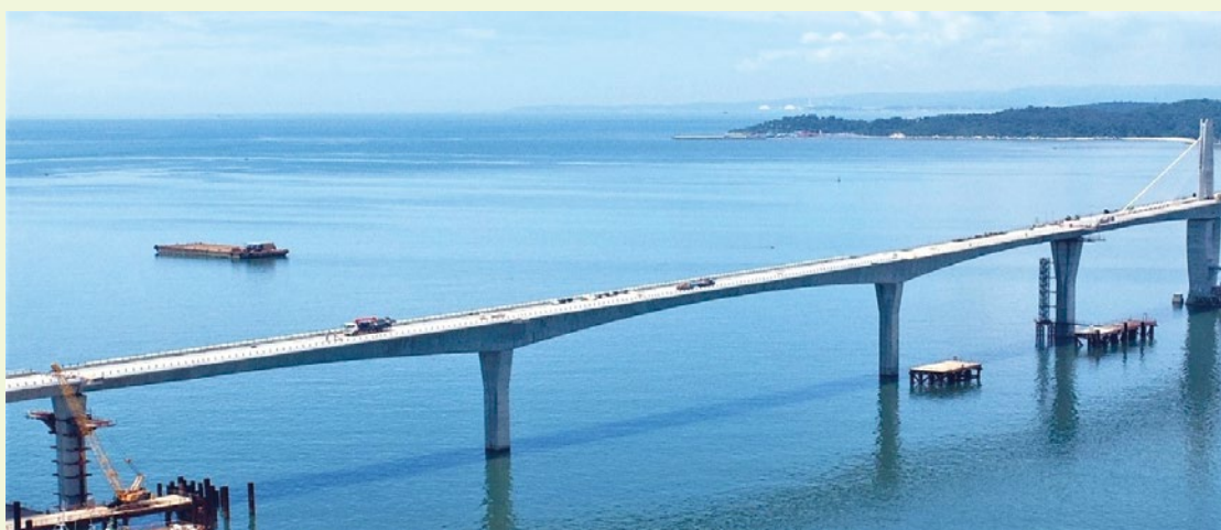
圖41 大金邊橋單元節塊吊裝完成情形
