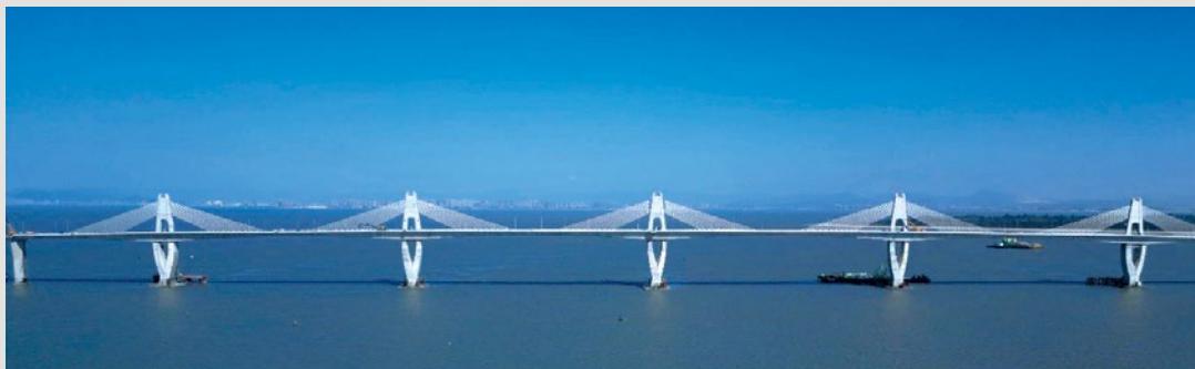
圖49 五塔高梁穗心造型墩柱完成情形
