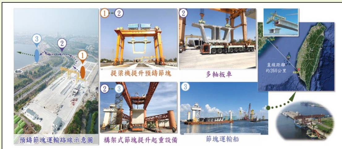
圖20 預鑄節塊運輸設備及路徑
