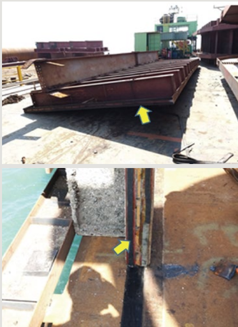
圖31 鋼接合面使用膠條緊密接合
