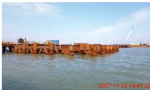
構台處漲潮狀況
