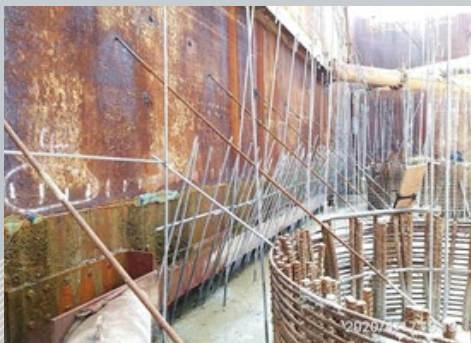
圖32 第一層樁帽基礎澆置前增設拉桿
