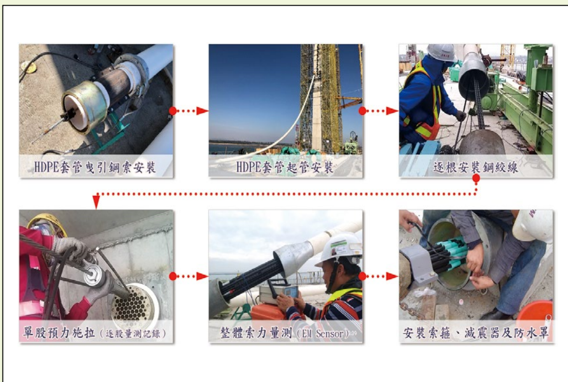
圖39 主橋外置預力施工流程
