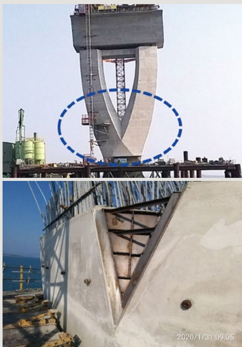
圖48 墩柱搭配鋼模造型位置
