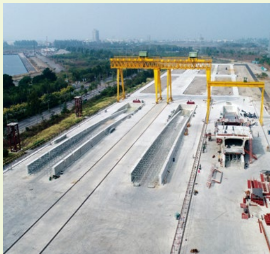
圖5 預鑄節塊生產梁床空拍(左2為生產主橋節塊、右1為生產邊橋節塊)
