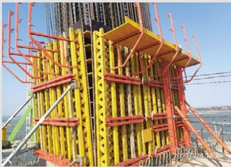
圖43 橋塔PERI系統模板組裝情形
