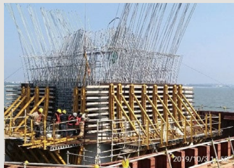
圖41 EFCO系統模板現場組立
