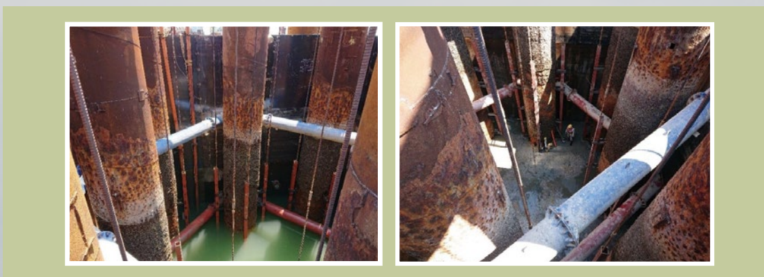
圖21 逐階抽水及設置臨時抗浮支撐直至抗浮機制轉換完成
