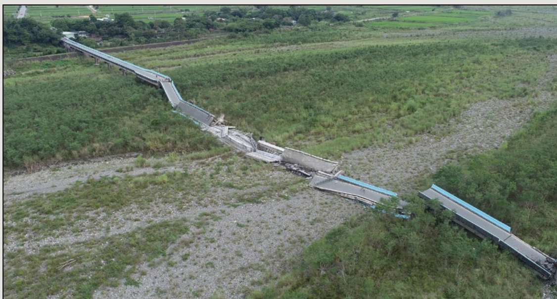
圖23 崙天大橋無人機空拍影像：跨河段鳥瞰遠景
