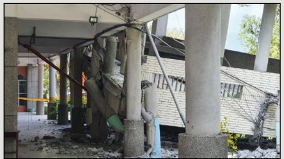
圖2 春日國小無人機空拍影像：走廊倒塌遠景
