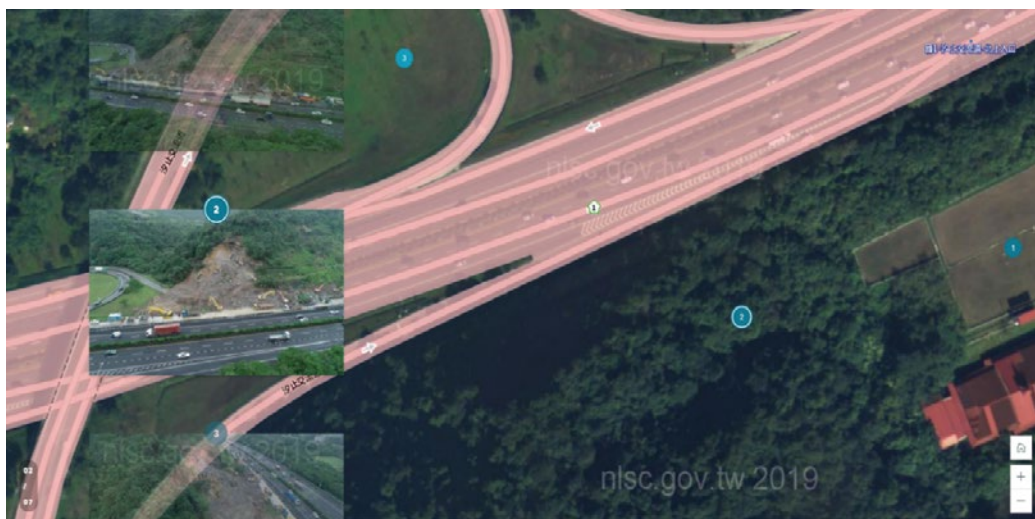
圖30 國道1號汐止交流道邊坡崩塌現勘照片點位記錄
