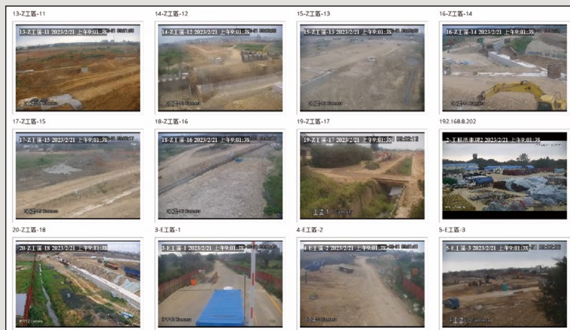
圖8 即時監控(CCTV)畫面
