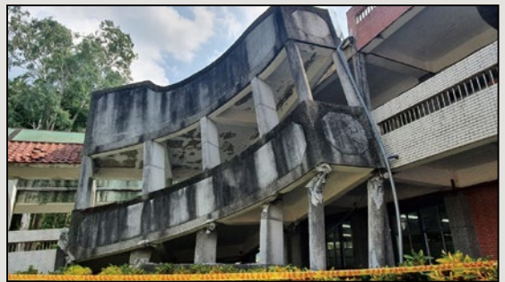
圖3 春日國小地面拍攝影像：走廊梁柱斷裂
