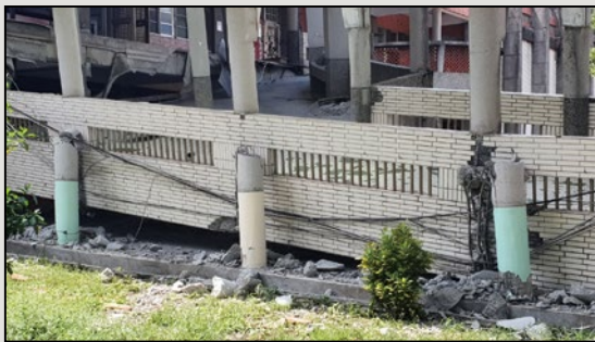
圖3 春日國小地面拍攝影像：走廊梁柱斷裂
