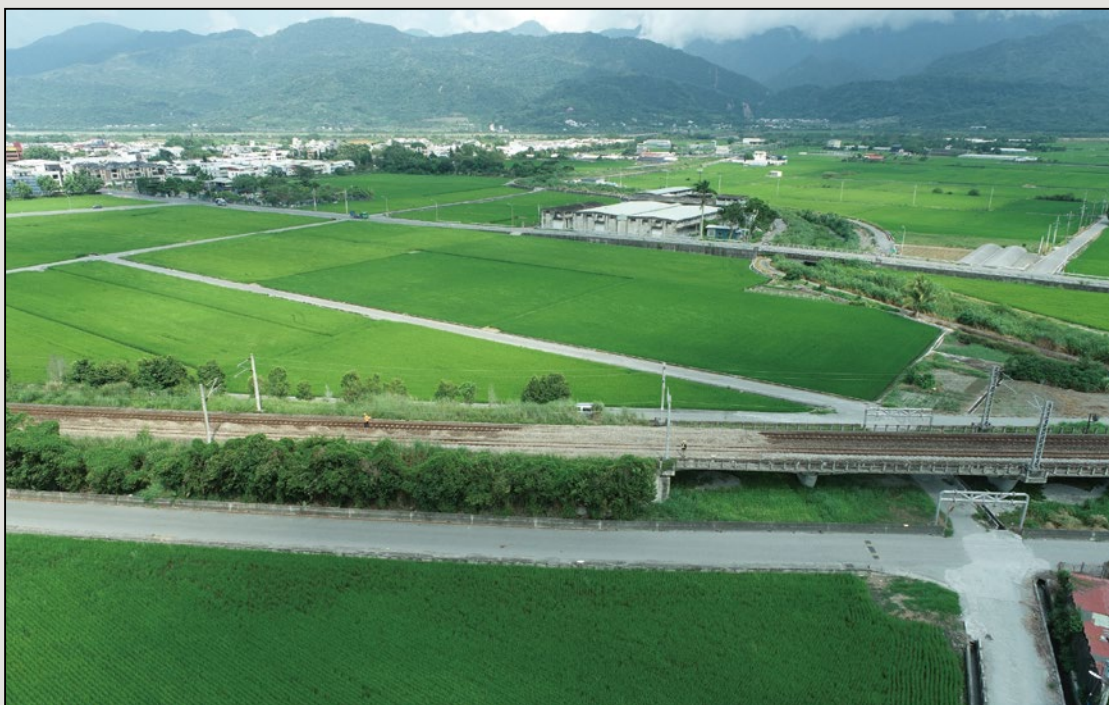
圖12 臺鐵客城橋無人機空拍影像：鐵軌已重新鋪設路段
