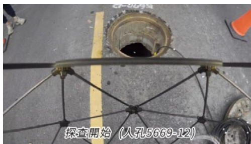
圖4 防撞無人機拍攝下水道人孔外部及涵管內部影像
