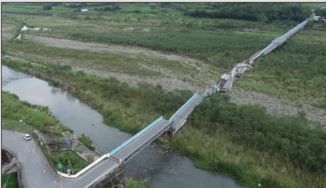
圖20 崙天大橋無人機空拍影像：鳥瞰遠景
