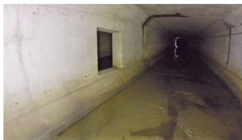
圖4 防撞無人機拍攝下水道人孔外部及涵管內部影像
