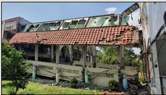
圖2 春日國小無人機空拍影像：走廊倒塌遠景
