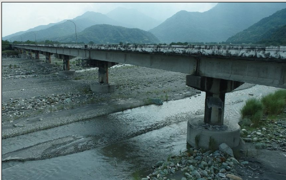
圖13 玉長大橋無人機空拍影像：鳥瞰遠景
