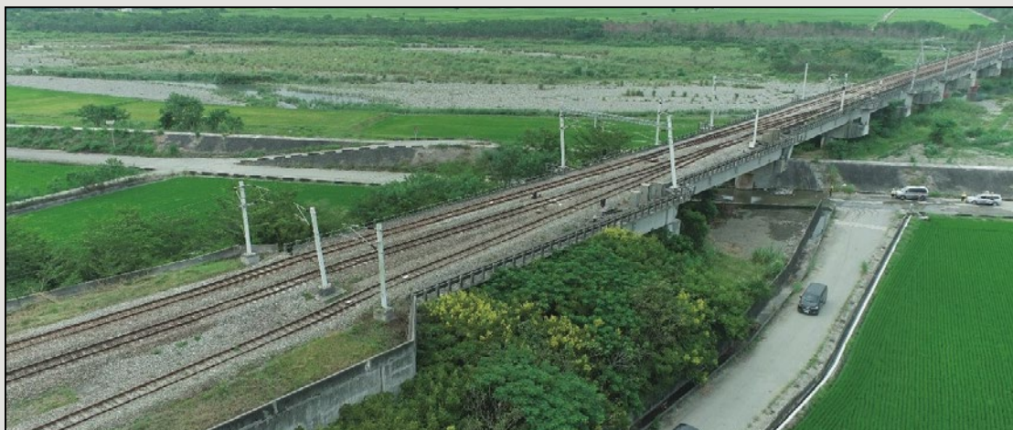
圖17 臺鐵新秀姑巒溪橋無人機空拍影像：鳥瞰遠景
