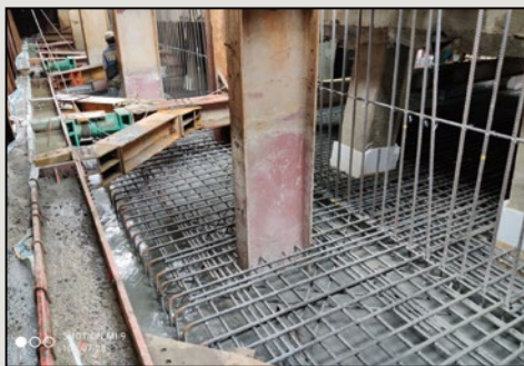
圖27 墩柱P10第一層基礎混凝土澆注施工
