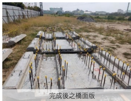
圖17 橋面版預鑄施工
