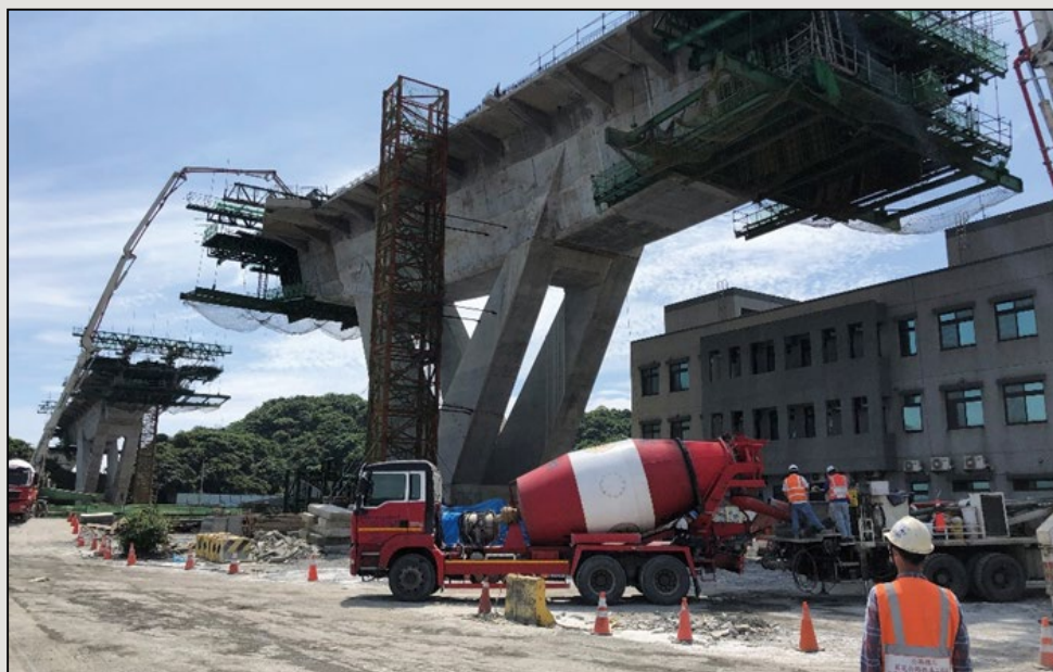
圖6 懸臂工法施工照片
