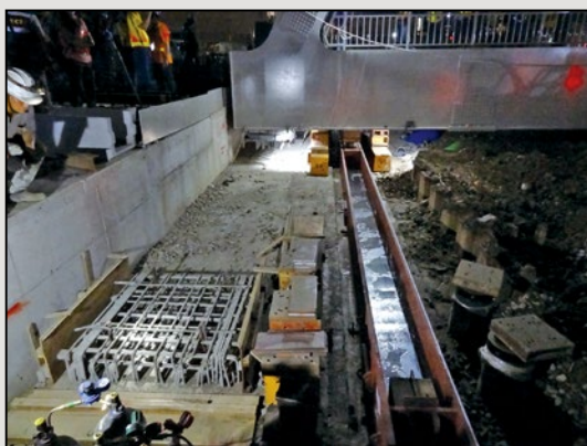
圖6 支承先安裝固定於鋼桁架橋下方同步側推
