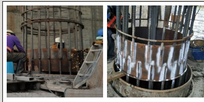
圖17 基樁鋼筋搭接施工相片
