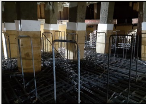
圖24 墩柱P10第一層基礎底層鋼筋施工
