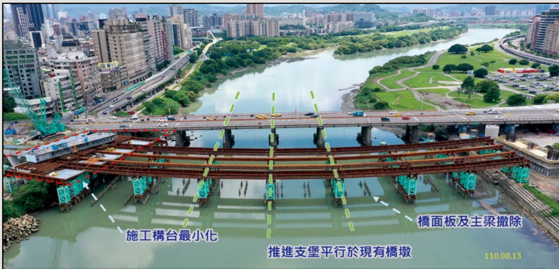
圖12 中正橋施工階段之水力分析挑戰
