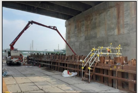
圖30 P10第二層基礎基礎混凝土澆注
