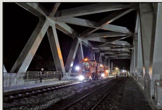
圖13 軌道銜接作業完成後進行砸道作業
