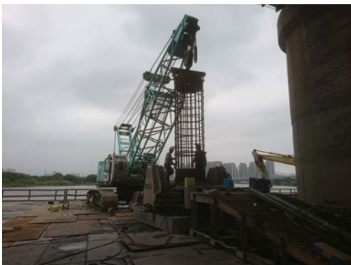
淨高受限之鋼筋籠搭接施工
