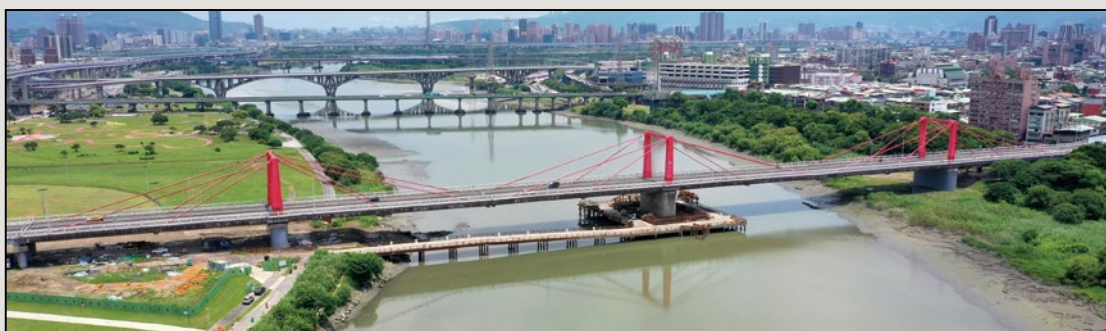
圖14 墩柱基樁補強現場
