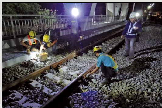
圖16 軌道鋪設完成後進行軌旁號誌設備安裝作業
