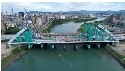
場撐段拱肋吊裝
