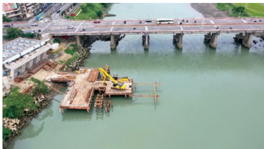
施工便橋架設
