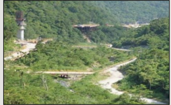
圖6 既有溪谷旁新建施工便橋
