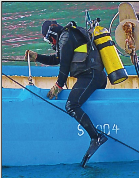
圖2 橋梁水下潛水檢測作業
