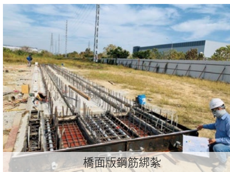
圖17 橋面版預鑄施工
