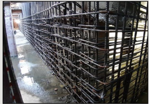
圖28墩柱P10第二層基礎鋼筋施工
