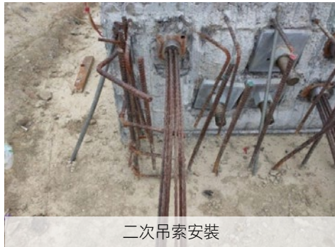
圖21 第二組鋼鍵安裝及預力施拉
