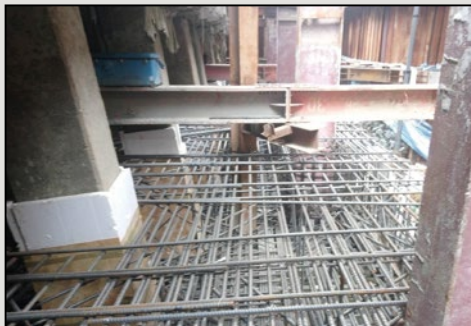
圖25 墩柱P10第一層基礎上層鋼筋施工
