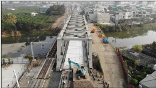
圖4 舊橋旁空地施作臨時橋台及架設鋼桁架橋
