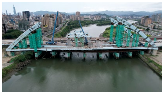
場撐段拱肋及提升段拱肋吊裝(構件A11-A13)
