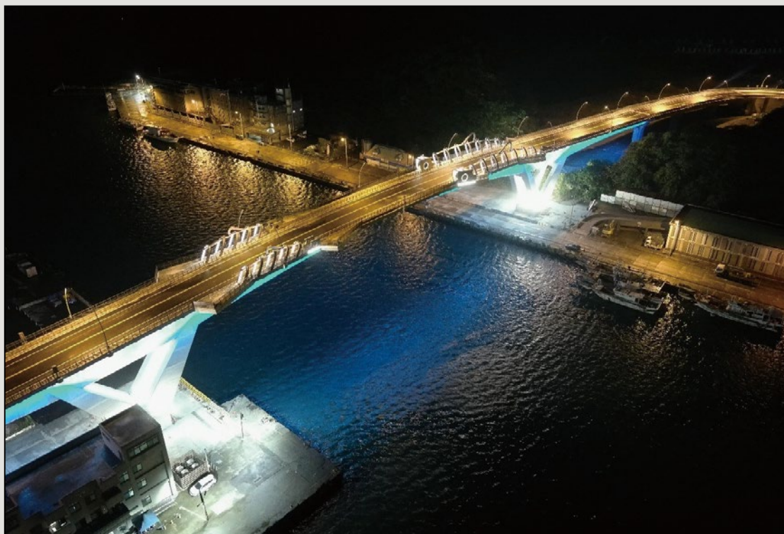
圖24 南方澳跨港大橋完工照片(四)
