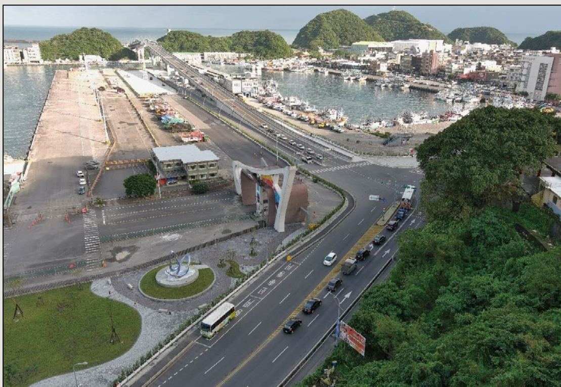
圖23 南方澳跨港大橋完工照片(三)
