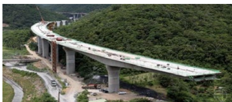
跨越山谷或地質敏感區，採用大跨徑之平衡式懸臂工法
