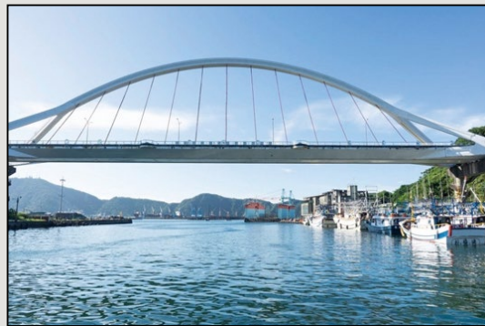
圖4 舊南方澳大橋照片
