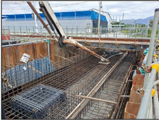
圖3 利用托軌工法於原路線下方施作永久橋台基礎及牆體
