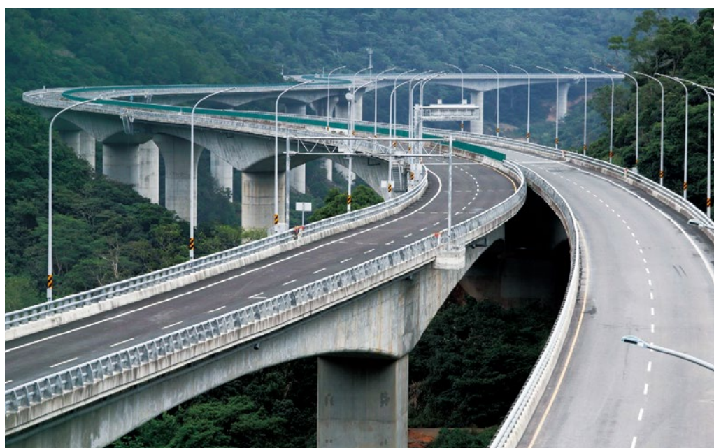
圖14 以高強度混凝土減少箱型梁量體
