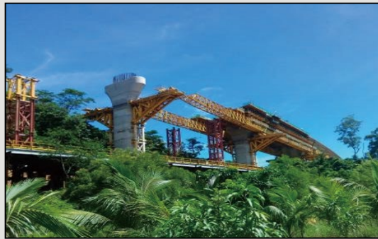
圖11 橋梁上部結構採用支撐先進工法
