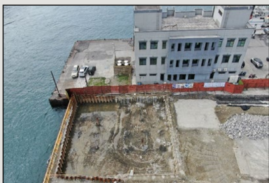
圖15 P6橋墩基礎擋土支撐照片
