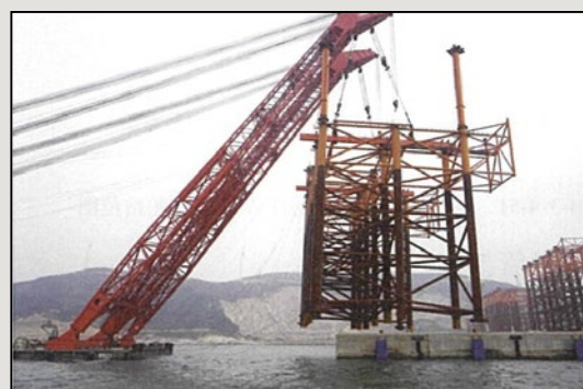
圖17 平潭大橋施工構台單元運輸及安裝過程
