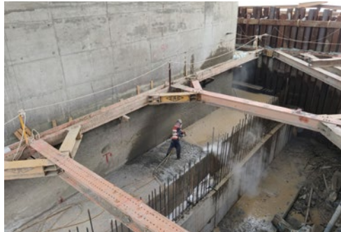
圖32 墩柱P10水刀清洗作業施工
