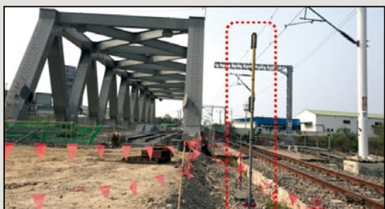
圖21 鐵路營運軌旁設置紅外線感知器
