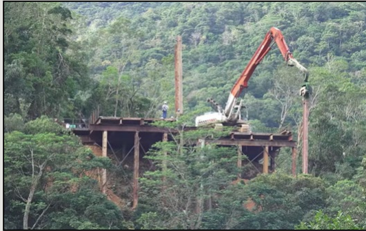
圖5 既有高邊坡處新建施工便橋
