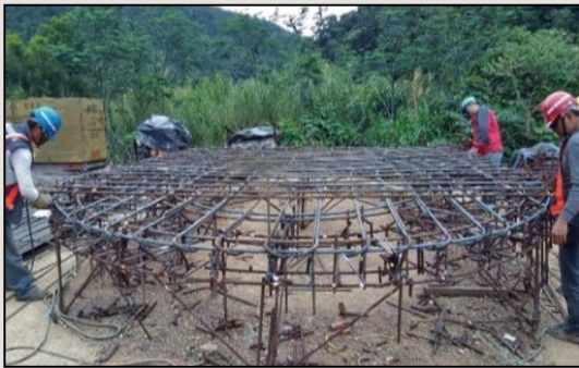
圖10 墩柱鋼筋採鋼筋籠模組化預組施工
