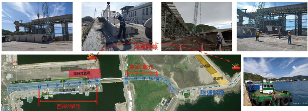
圖12 拆橋規劃與施工照片
