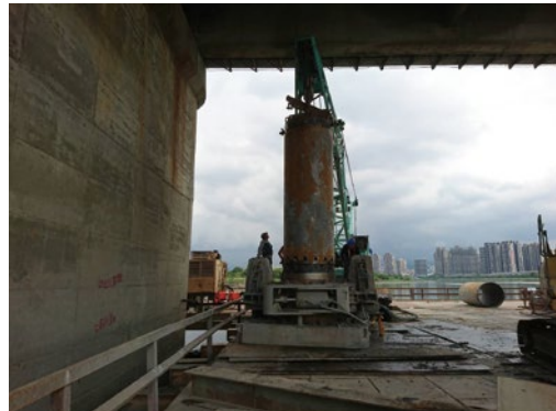
淨高受限下之基樁套管接合施工
