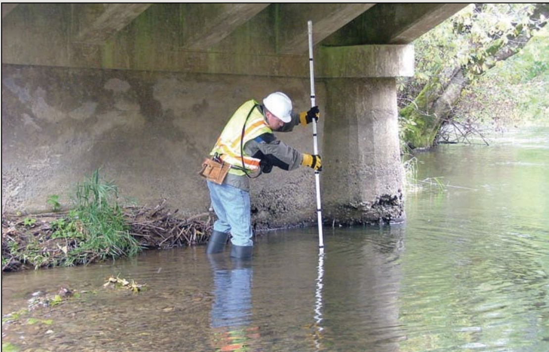
圖1 橋梁涉水作業[3]
