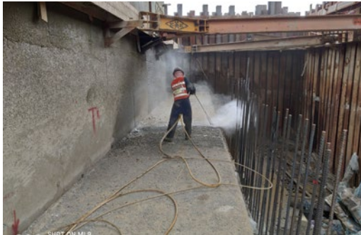
圖32 墩柱P10水刀清洗作業施工
