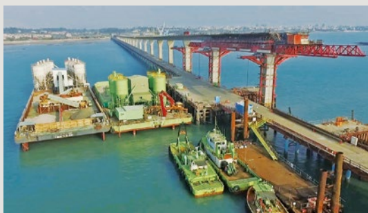
圖12 金門大橋施工整備場地、施工便橋及碼頭
