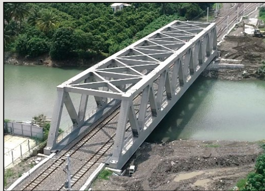
圖2 北勢溪新橋(下路式鋼桁架橋)
