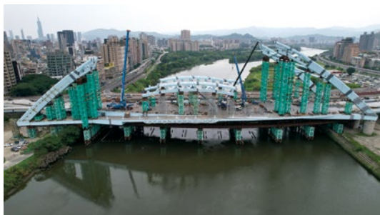
場撐段拱肋及提升段拱肋吊裝(構件A10-A15)
