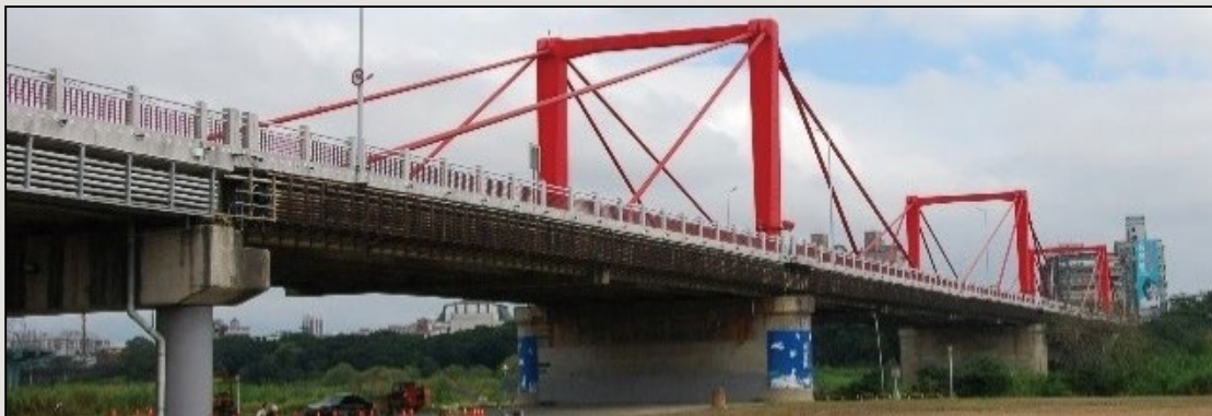
圖2 光復大橋現況相片
