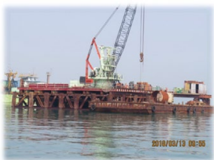
海上施工構台
