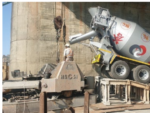
淨高受限下之基樁灌注混凝土作業
