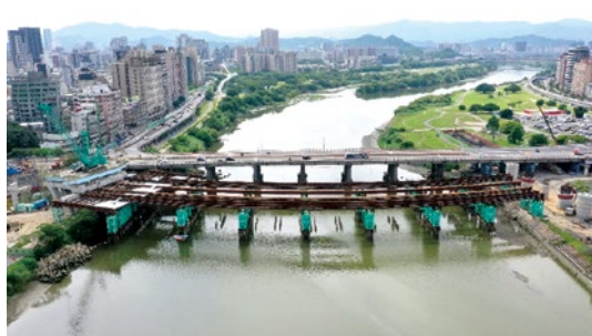
構件組裝平台架設完成
