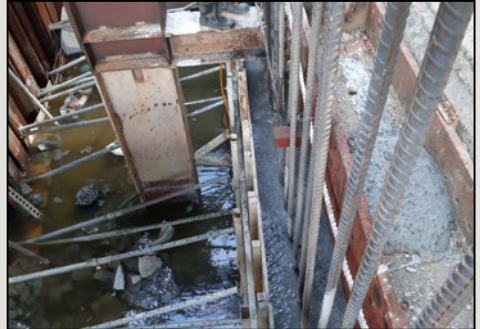
圖31 墩柱P10第二層基礎養護
