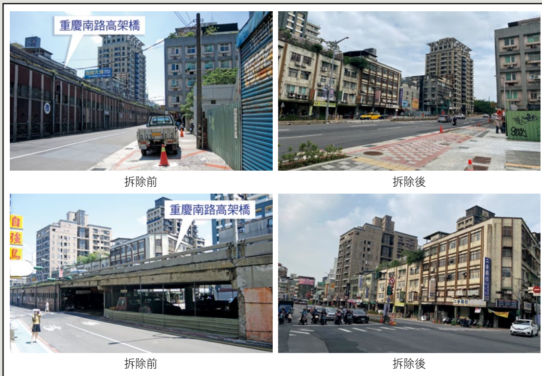
圖11 重慶南路高架橋拆除前及拆除後之照片
