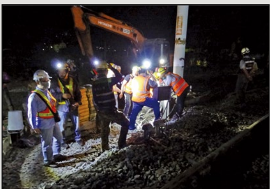
圖15 側推定位後進行號誌系統復原作業
