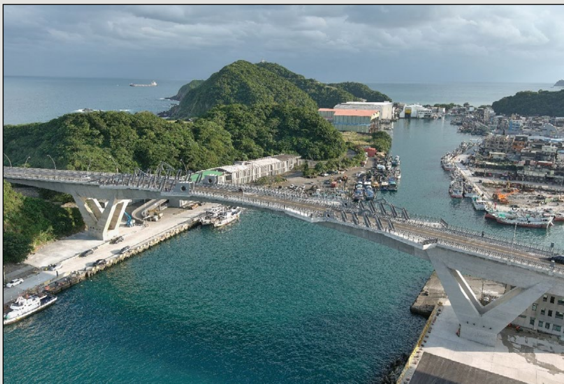
圖22 南方澳跨港大橋完工照片(二)
