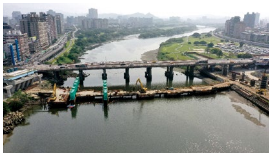
施工便橋及支堡架設
