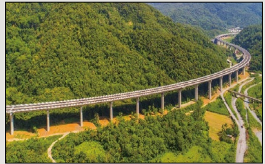
圖8 邊坡採用中跨徑橋梁布設
