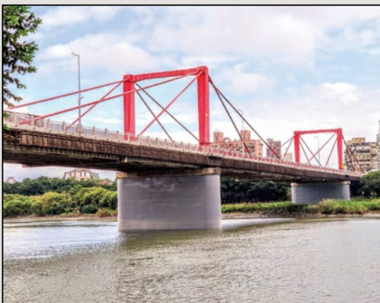
圖33 光復大橋完工相片
