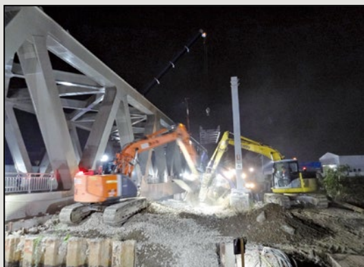
圖9 側推前置作業拆舊橋、吊離托軌梁及拆除障礙物
