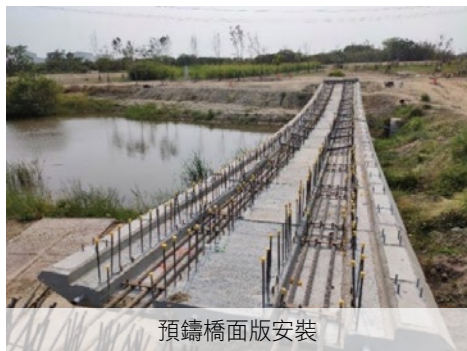
圖19 橋面版懸吊工法施築
