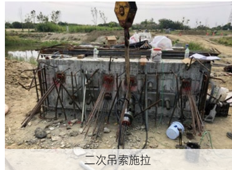
圖21 第二組鋼鍵安裝及預力施拉
