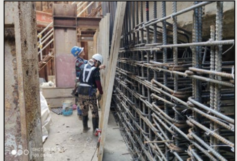
圖29 墩柱P10第二層基礎組模
