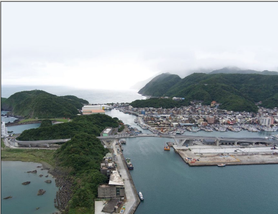
圖21 南方澳跨港大橋完工照片(一)
