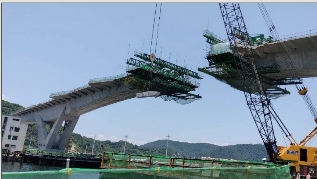
圖20 節塊打除作業(二)
