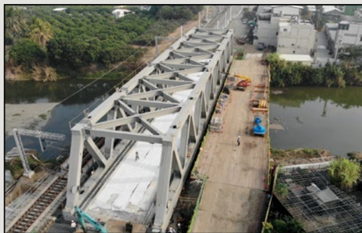
圖19 北勢溪橋改建工程施工期間空拍圖
