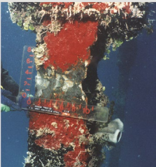
圖3 第二級檢測清理H型鋼樁與量測缺陷尺寸[4]
