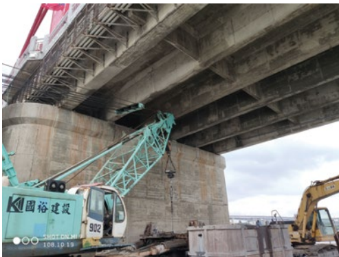
淨高受限之基樁挖掘施工作業
