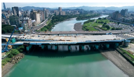
節塊組裝推進完成
