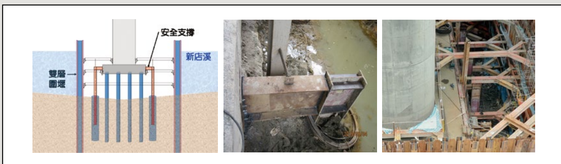
圖20 墩柱安全支撐示意圖及施工相片
