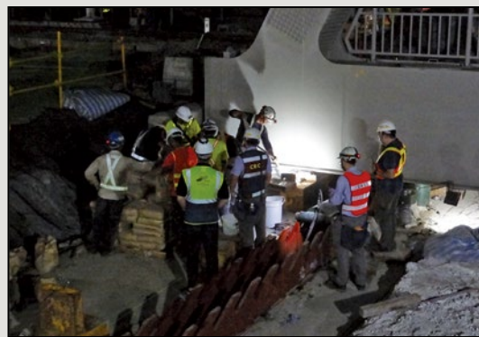
圖11 側推定位後設置臨時支承及永久支承墊灌漿
