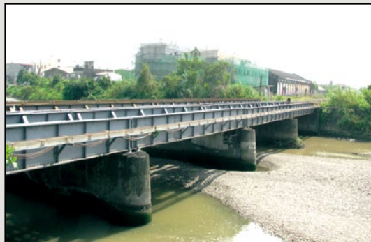
圖1 北勢溪舊橋(下路式鋼I型梁橋)
