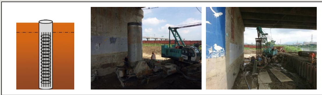
圖18 墩柱P9及P11基樁施工示意圖及相片
