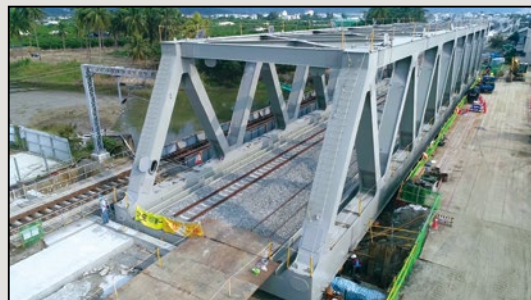
圖5 鋪設橋上軌道、安裝側推工法設備及進行側推測試
