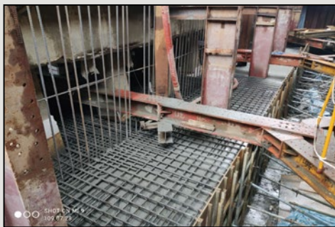
圖26 墩柱P10第一層基礎組模施工
