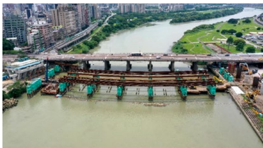
支堡及推進軌道梁架設
