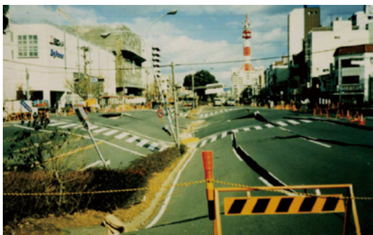
圖3 大開地下車站於1995年阪神大地震後崩塌情形〔37〕
