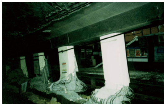
圖3 大開地下車站於1995年阪神大地震後崩塌情形〔37〕
