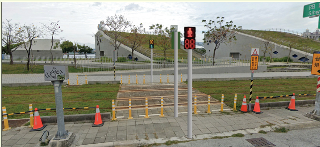
圖21 撞軌道區穿越道上之行人及自行車之行人穿越道增設號誌改善示意圖——海邊路／四維四路北側行穿
