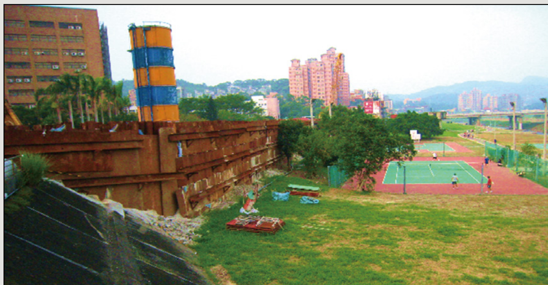
圖10 原本新陸橋拆除河堤之雙層圍堰
