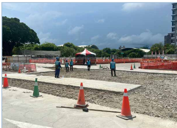
圖 11 車行路徑 100% 混凝土鋪面
