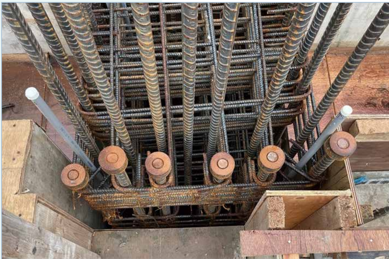
圖 22 模矩化配筋工法梁柱接頭實際案例
