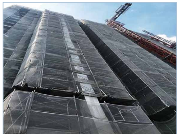
圖 17 設置防塵網(布)抑制粉塵
