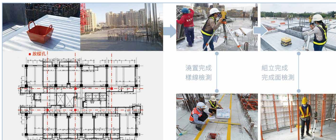
圖 11 鋁模放樣施工
