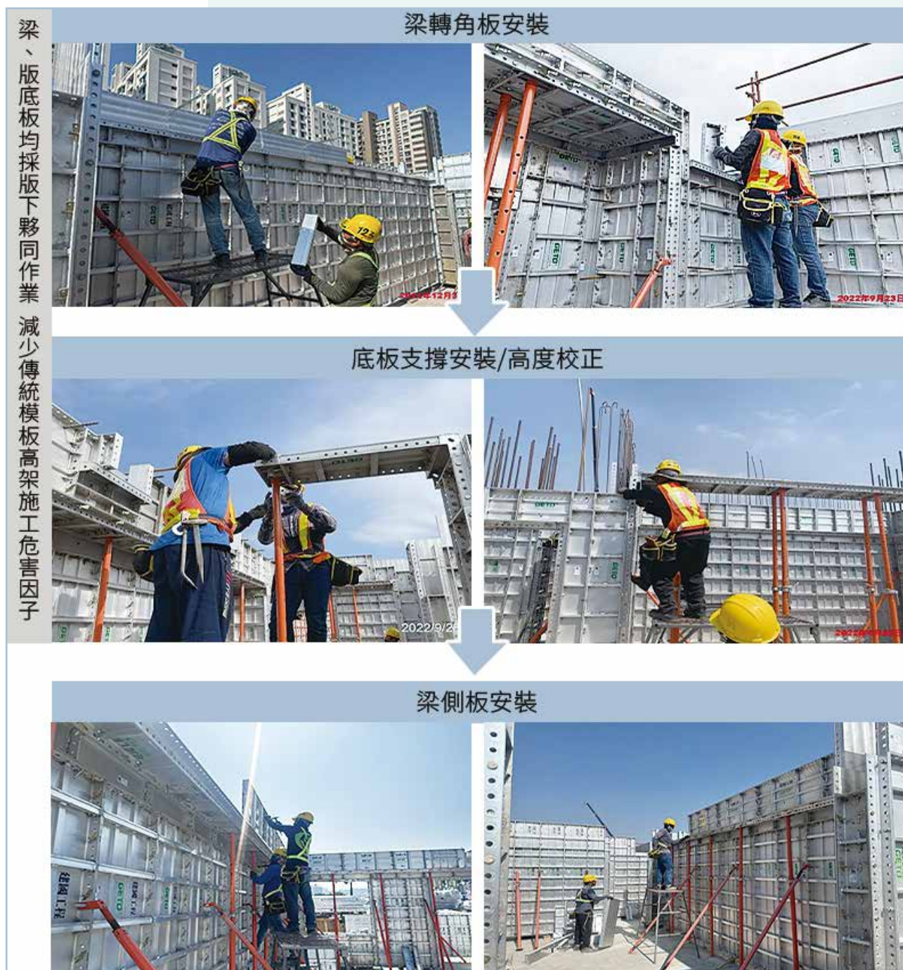
圖 14 梁牆接合鋁模施工
