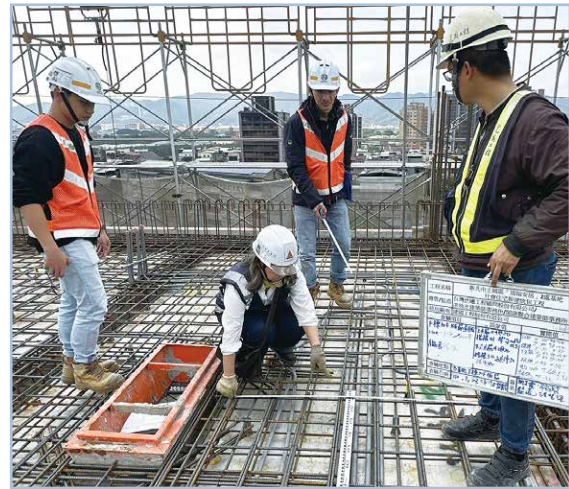
圖 23 模矩化配筋工法版配筋實際案例
