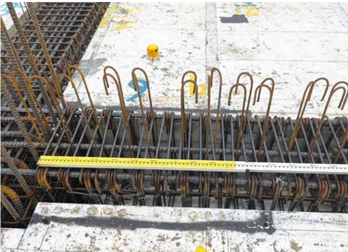
圖 4(a) 模矩化配筋工法梁配筋
