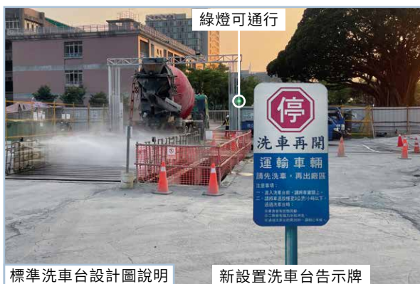
圖 13 智能洗車台跳動鋼板式
