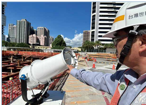
圖 12 固定型霧砲機抑制揚塵
