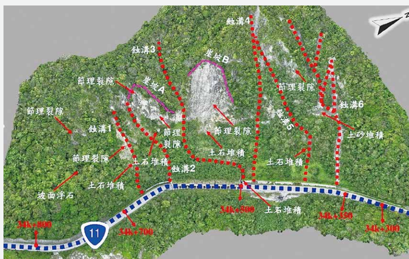
利用 UAV 檢視坡面現況 (台 11 線 34k+155 ~ 34k+822)
