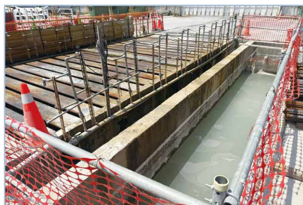
圖 14 沉砂池／廢水收集坑
