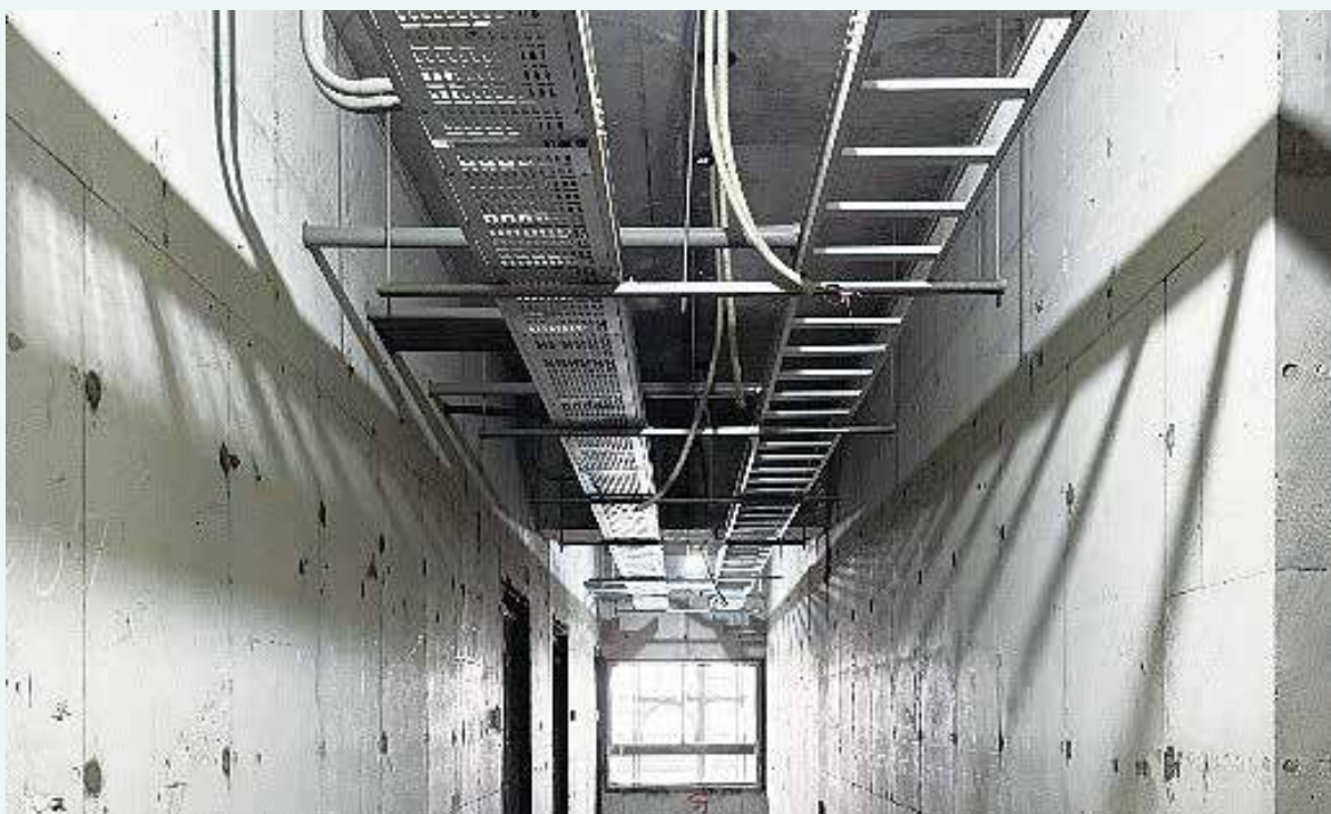
圖 46 拆模後表面平整
