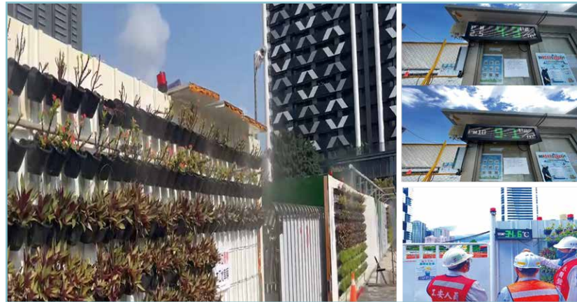
圖 25 空氣品質監測低於設定警報值，水圍籬自動灑水
