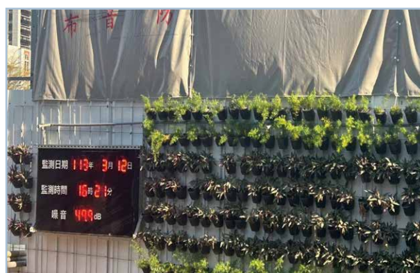
圖 22 噪音量管制顯示板
