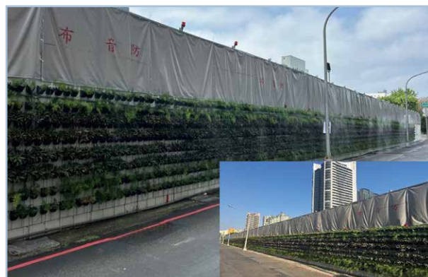
圖 19 圍籬上加裝隔音帆布
