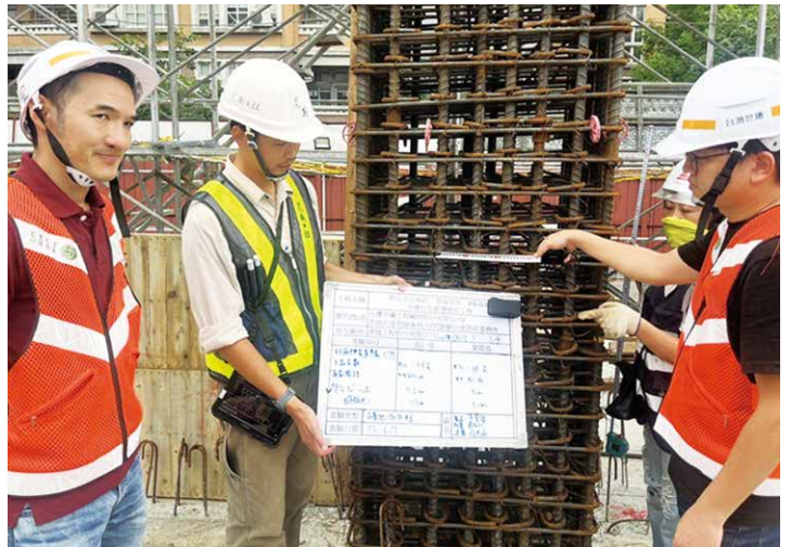
圖 4(b) 模矩化配筋工法柱配筋
