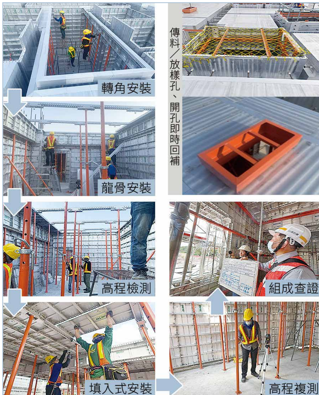
圖 15 底板鋁模施工
