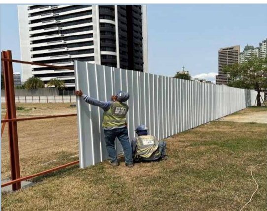
圖 8 工地周界圍籬
