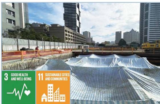
圖 16 開口設置防塵帆布
