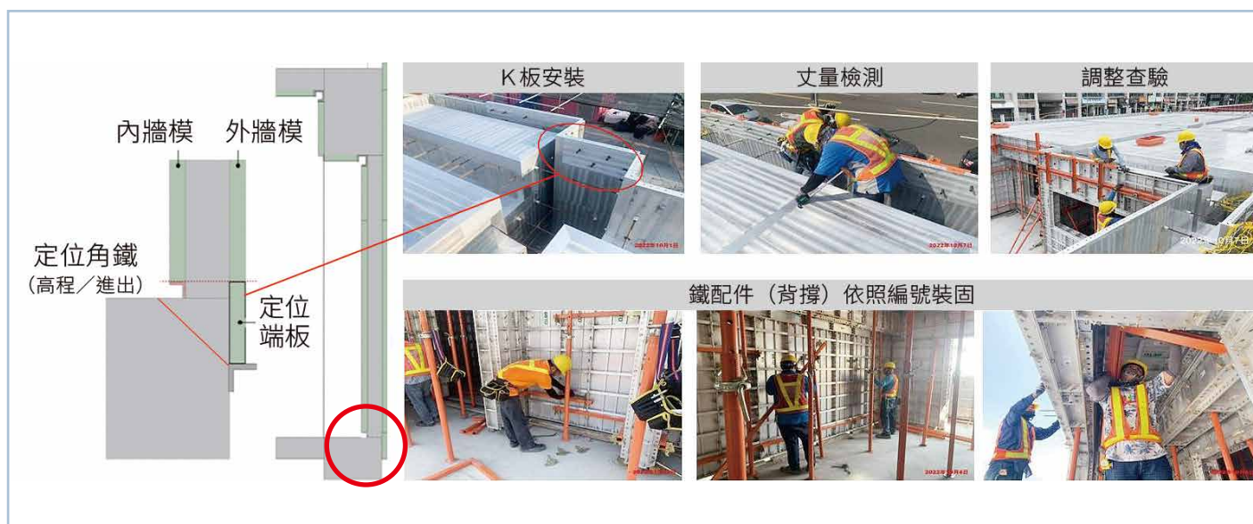
圖 12 K 板柱昇層鋁模施工
