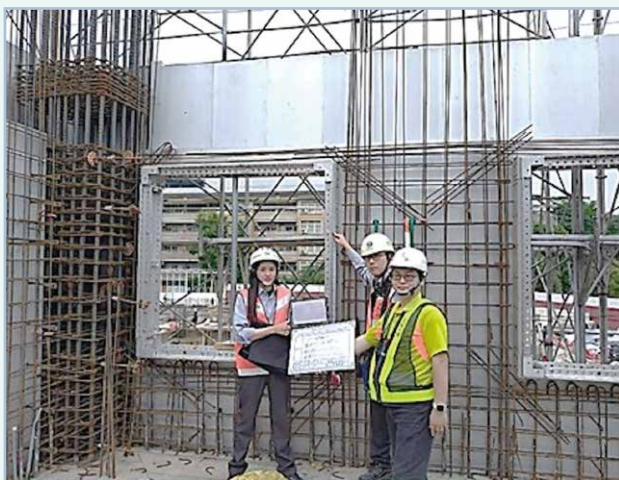
圖 17 運用 BIM 工具進行鋁模施工查證
