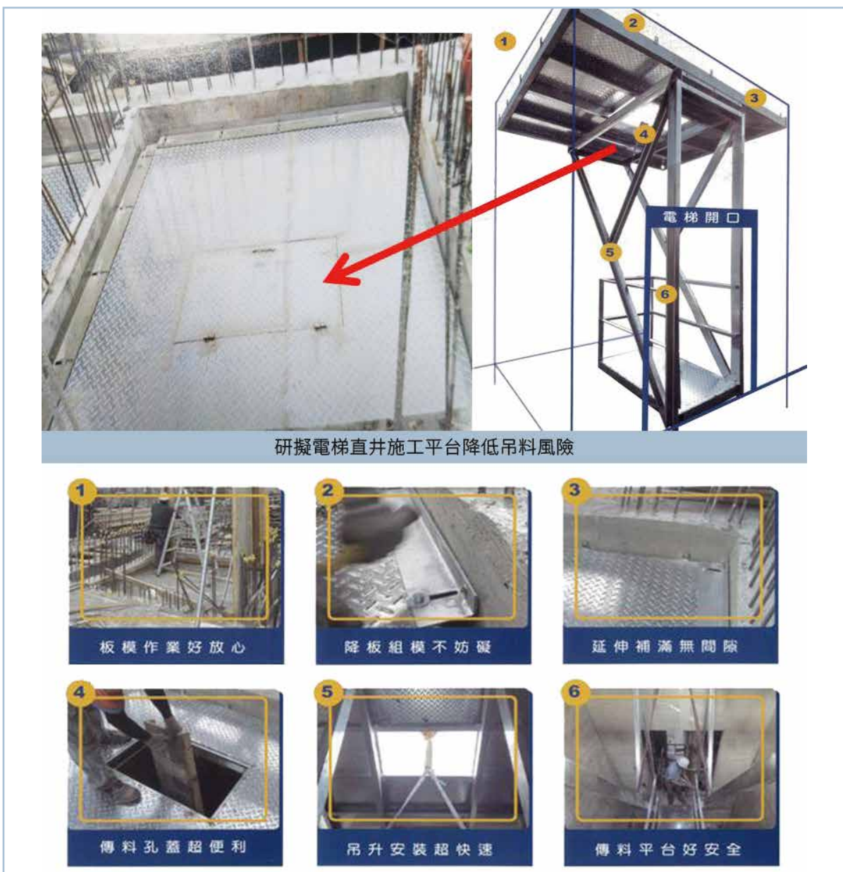
圖 19 鋁模電梯直井施工平台優化
