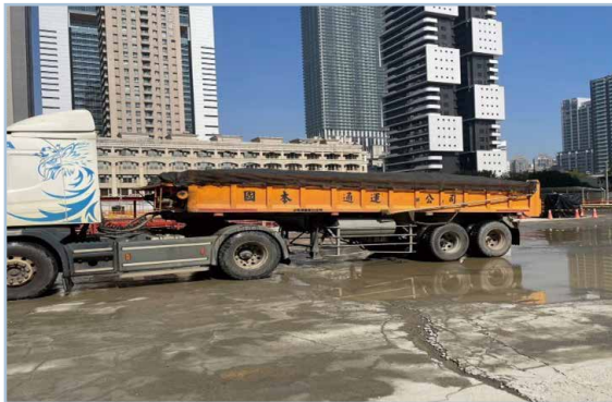
圖 15 土方運輸覆蓋防塵網
