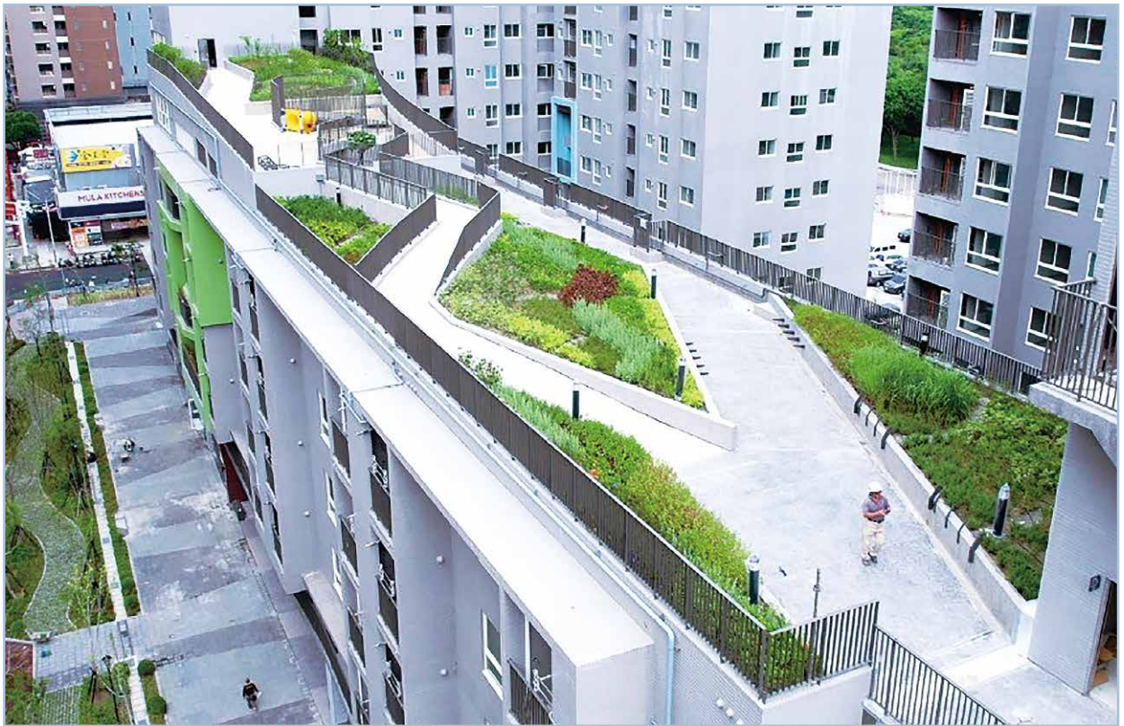
圖 6 八樓屋頂層完工照
