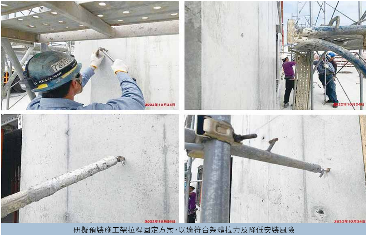
圖 20 鋁模外牆施工架優化
