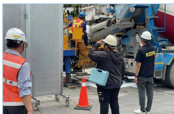
圖 20 移動隔音屏降低 5 dB
