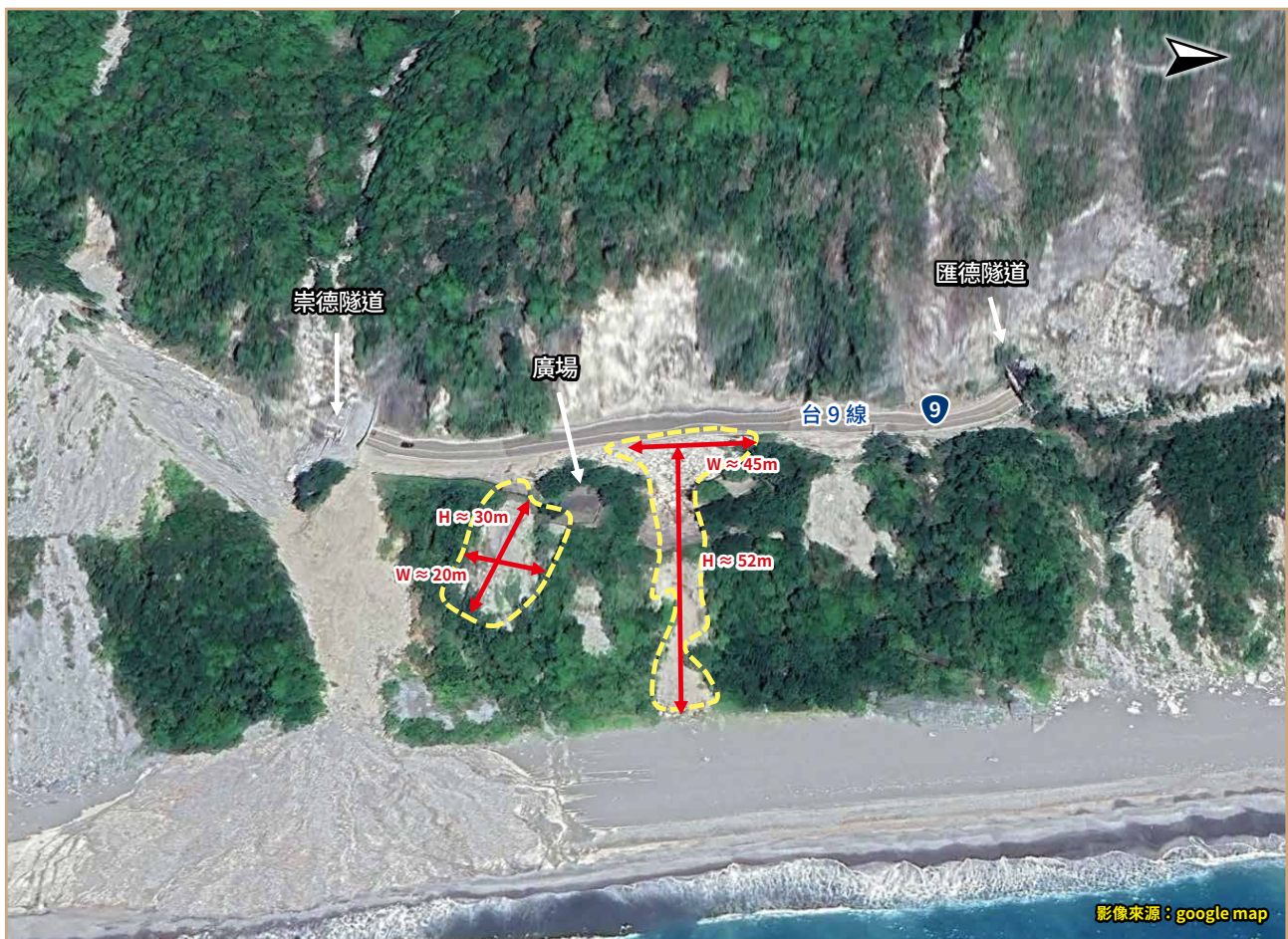
圖 14 崇德步道邊坡崩塌狀況
