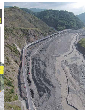
2017 年新建完工之明霸克露橋
