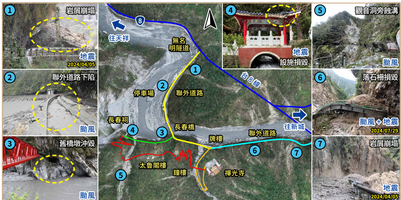
圖 6 長春祠步道遊憩區災損
