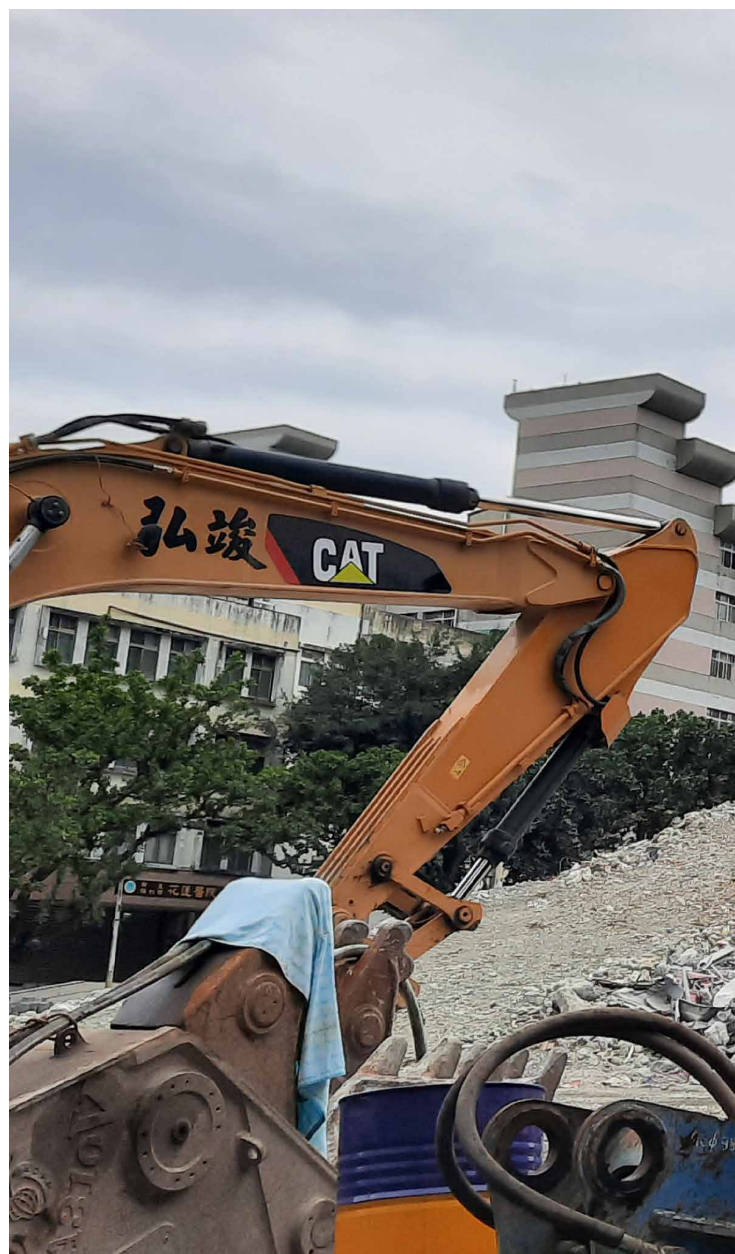
▲ 統帥大樓震後拆除
