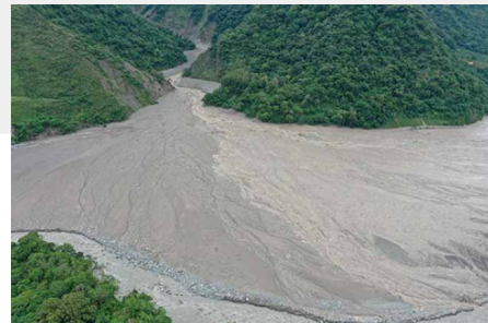
0807豪雨明霸克露橋玉穗溪口遭土石沖毀覆蓋
