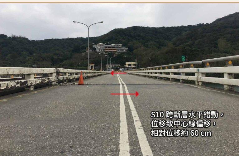
圖 6 花蓮大橋水平位移照片
