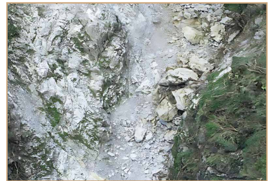
圖 20 高聳邊坡 UAV 探查
