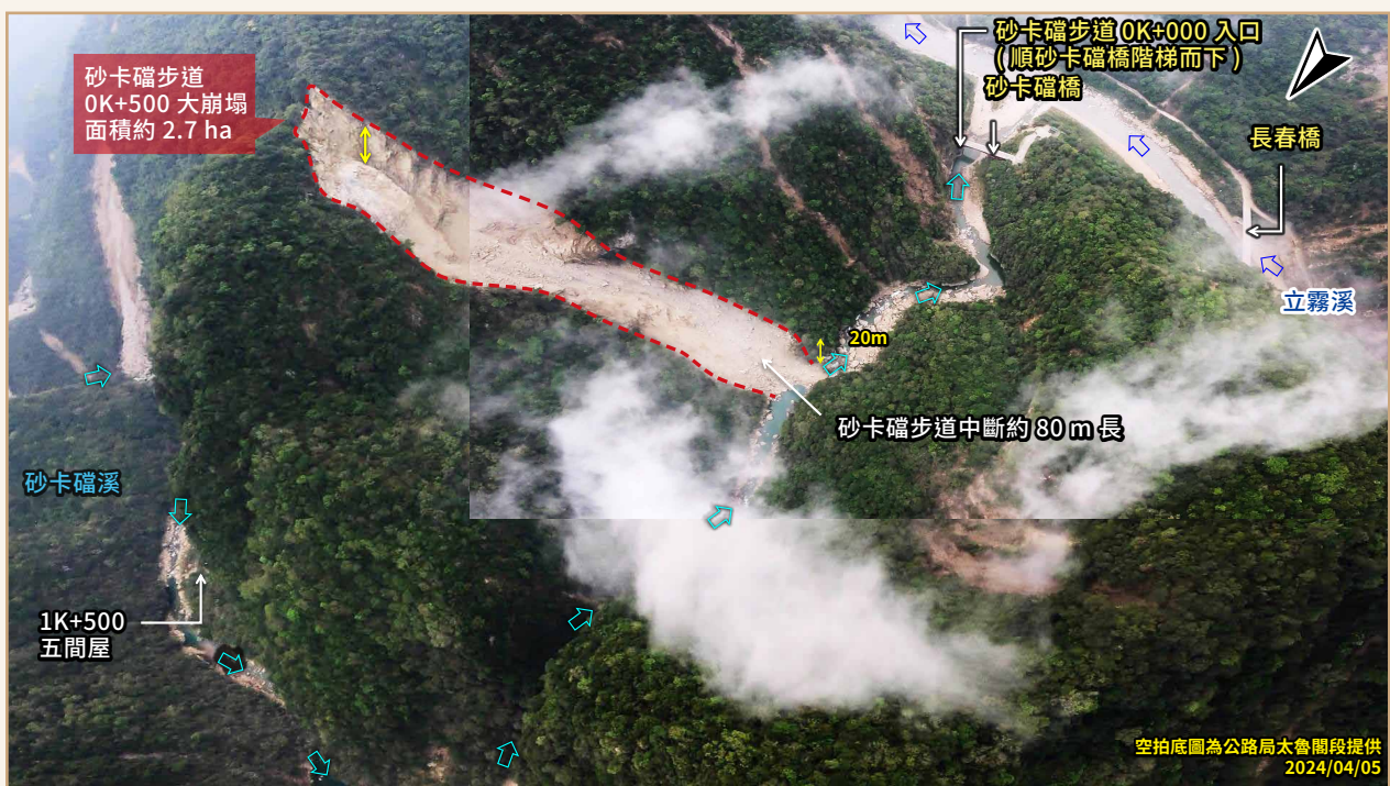
圖 12 砂卡礑步道 0k+500 大崩塌情形 (公路局太魯閣工務段，2024/4)
