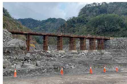
2022年2月完成鋼便橋工程
