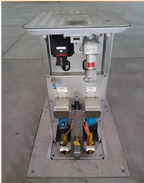
圖 26 地面電源 400Hz 接頭 (GPU)
