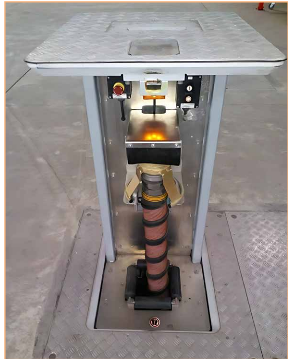
圖 27 地面壓縮空氣快速接頭
