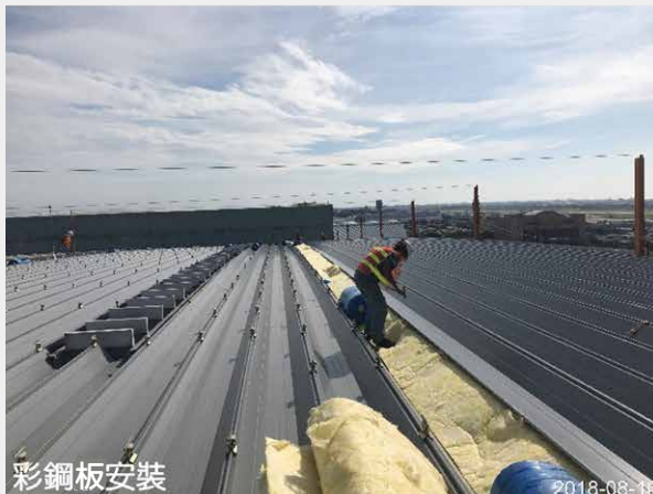
圖 13 機棚區雙層彩色鋼板施工照片
