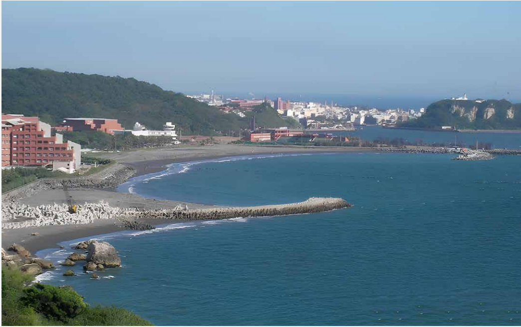
廖學瑞團隊創人工岬灣配合養灘工法，成功復育出長約 1 公里的彎月型沙灘，讓西子灣美景風采再現
