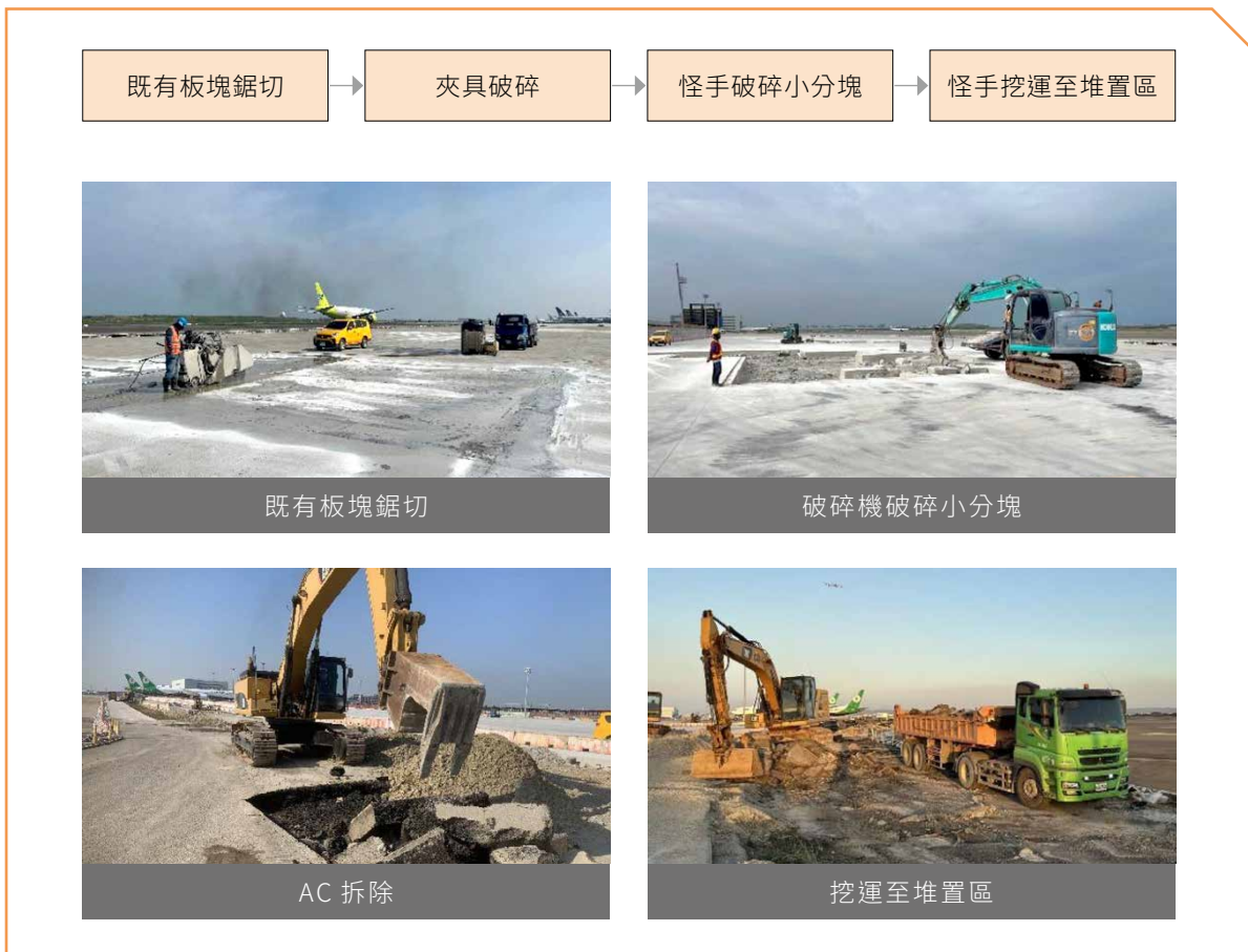
圖 7 工地拆除流程圖
