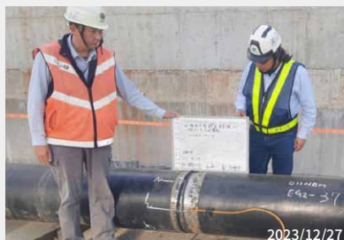
油管銲道檢驗 - 放射線照相檢測
