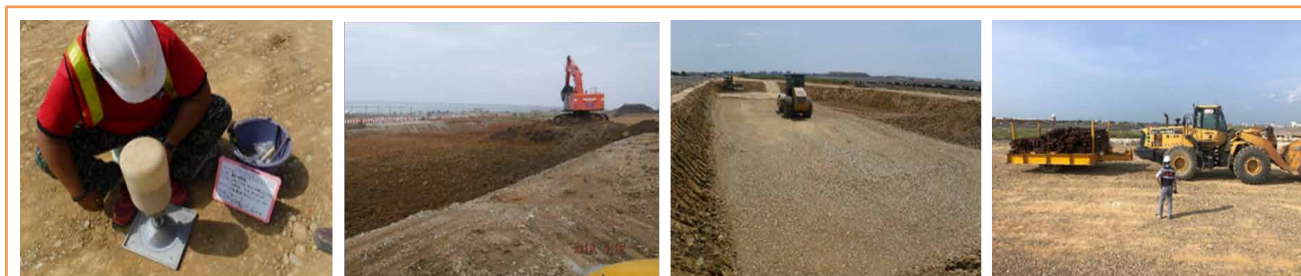
圖 10 原地面 CBR、工地密度試驗→不適用土壤挖除運離→碎解料填築及夯壓→重型車載試驗驗證
