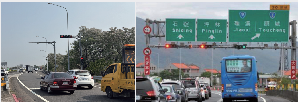
匝道儀控號誌燈現場照(車輛排隊管制中)
