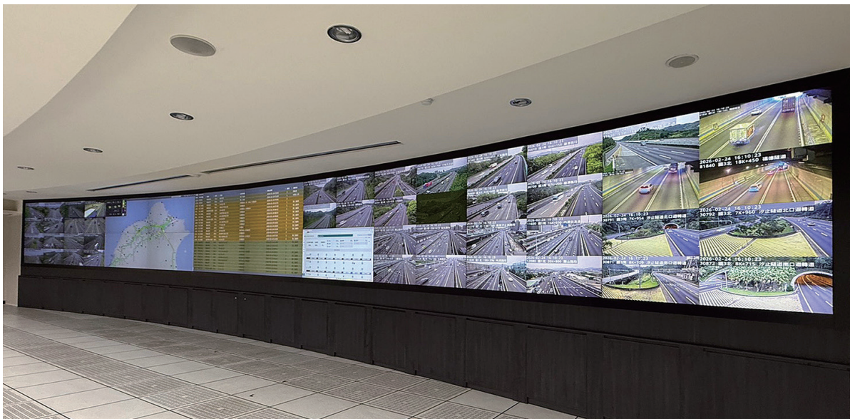
圖 1 交通部高速公路局北區交通控制中心
