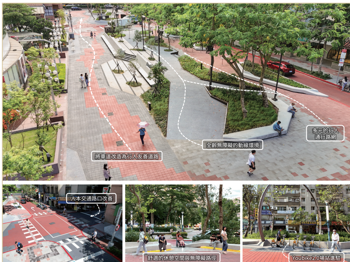
圖 5 瑤公綠廊工程改造後情況
